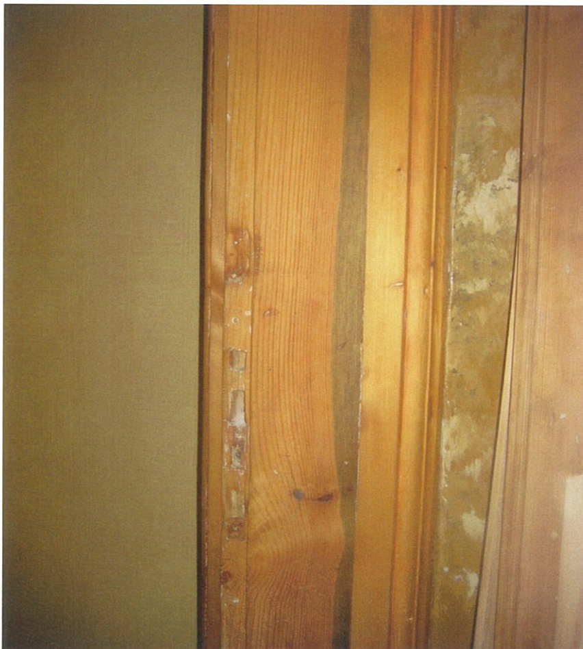
Joonis 8.20 Sinavusseen uktselengil (ehe näide kursusel omandatud kasulikest teadmistest)
