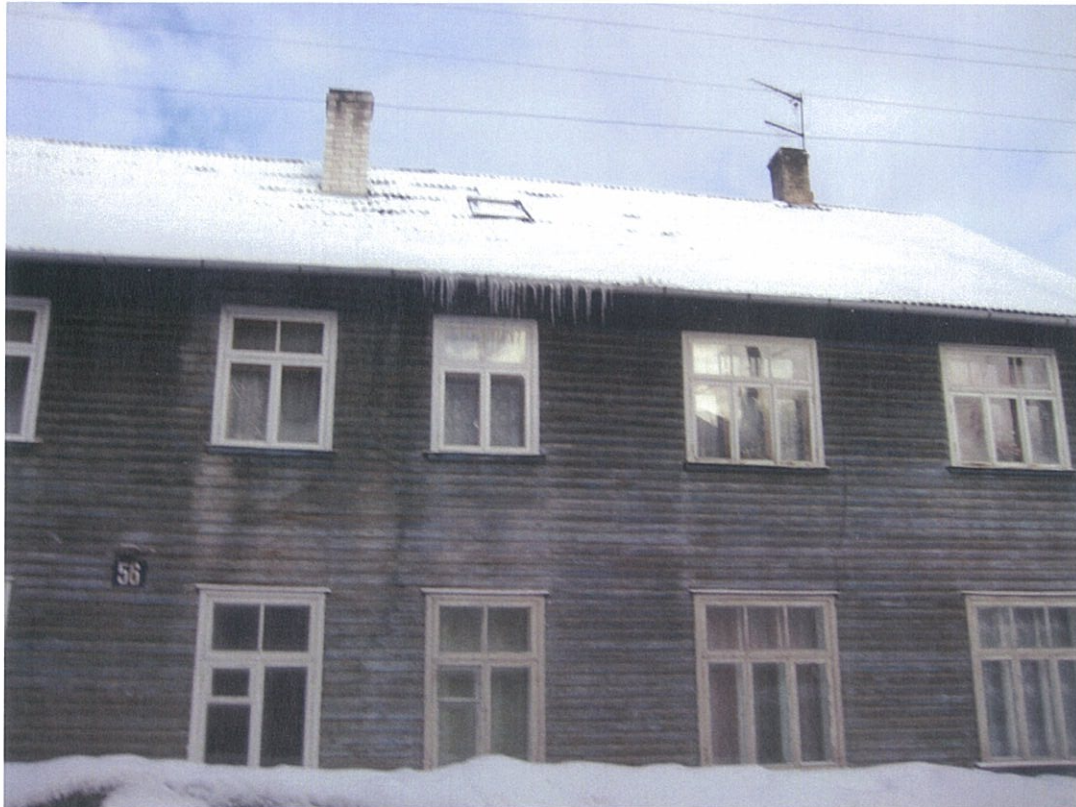
Joonis 3.3 Jääpurikad tänava kohal!!! See ongi pööningule avaneva ventilatsioonitoru asukoht
