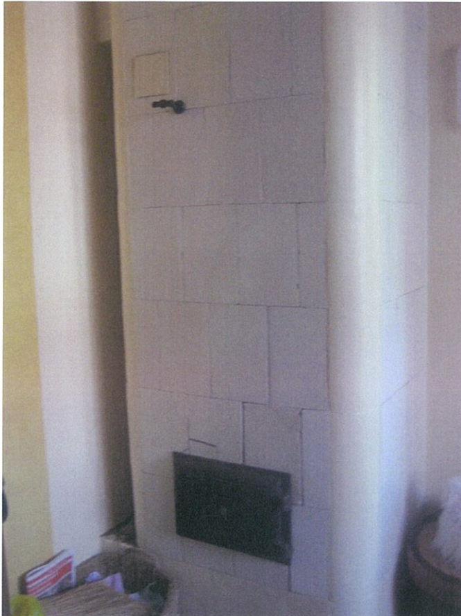
Joonis 8.11 Ainus kahhelahi majas – mõra kivis ja ukse ümber kivid tasapinnast väljas!!!
