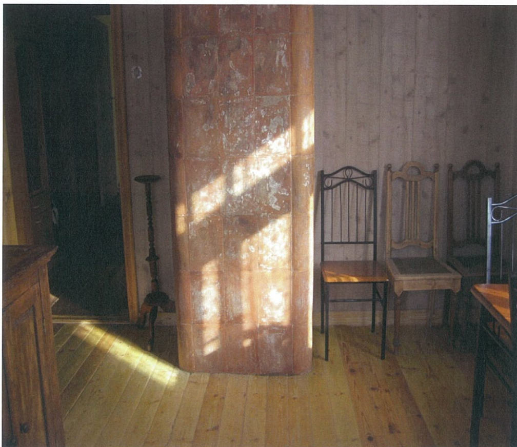
Joonis 8.13 Originaalsust minu mõistes taotlev ahjupuhastustulemus, eelmisel fotol oleva ahju teine (toapoolne) külg
