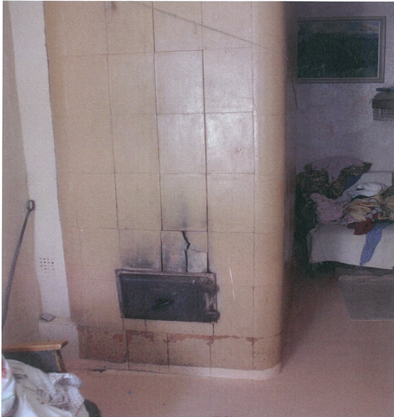
Joonis 8.7 See ahi igatseb vähemalt üht uut kivi
