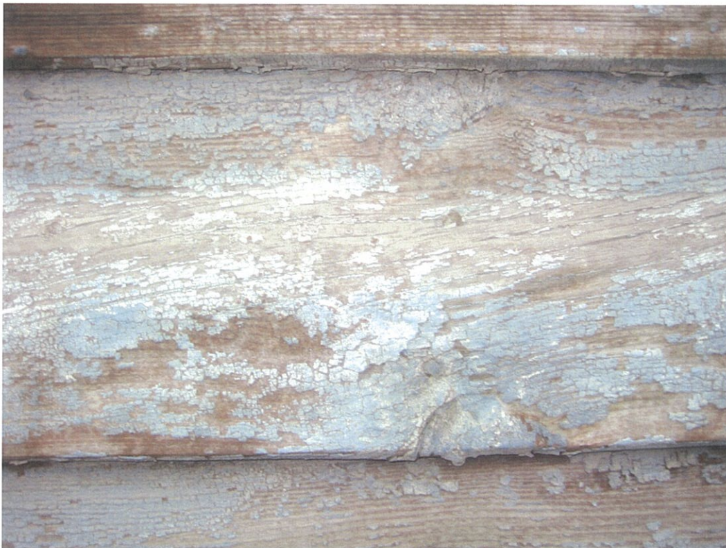
Joonis 4.1 Kitsas voodrilaud ja värv – niipalju, kui seda üldse alles on
