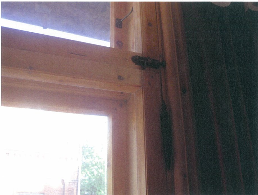
Joonis 8.10 Manused: haagid originaalid, hinge ja riivid siia, „teisaldatud“
