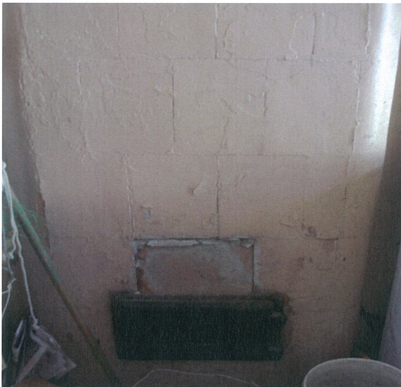
Joonis 8.6 Hädapärane parandustöö on katkise kivi asendamisega tehtud
