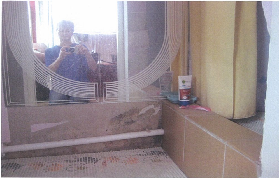
Joonis 8.1 Hallitav vannitua sein (külm koridorisein)
