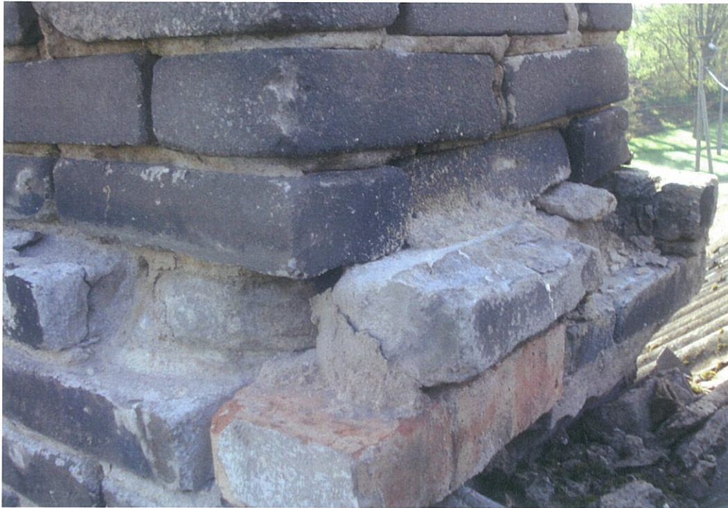
Joonis 3.7 Meie kiirparandatud korsten
