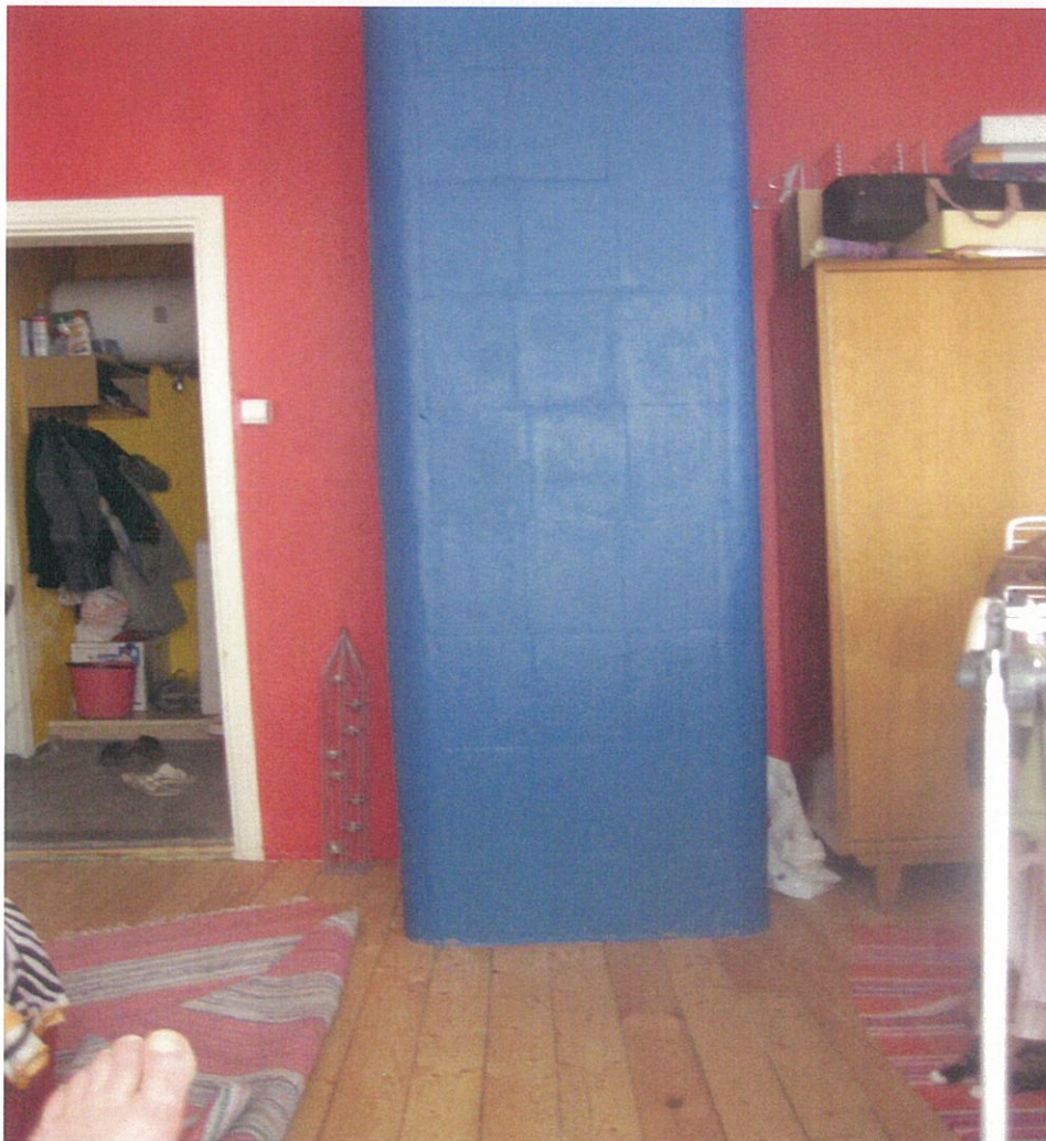
Joonis 8.2 Uuesti värvitud ahi ja sile põrand (laudadevahelised praod täitmata)
