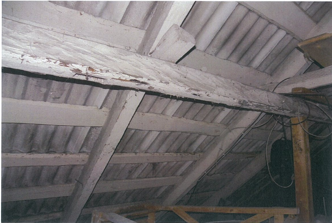
Joonis 3.1 Sarikad ja toolvärk
