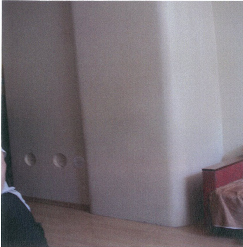
Joonis 8.5 Pahteldatud ja värvitud ahi, põrandakatteks laminaat
