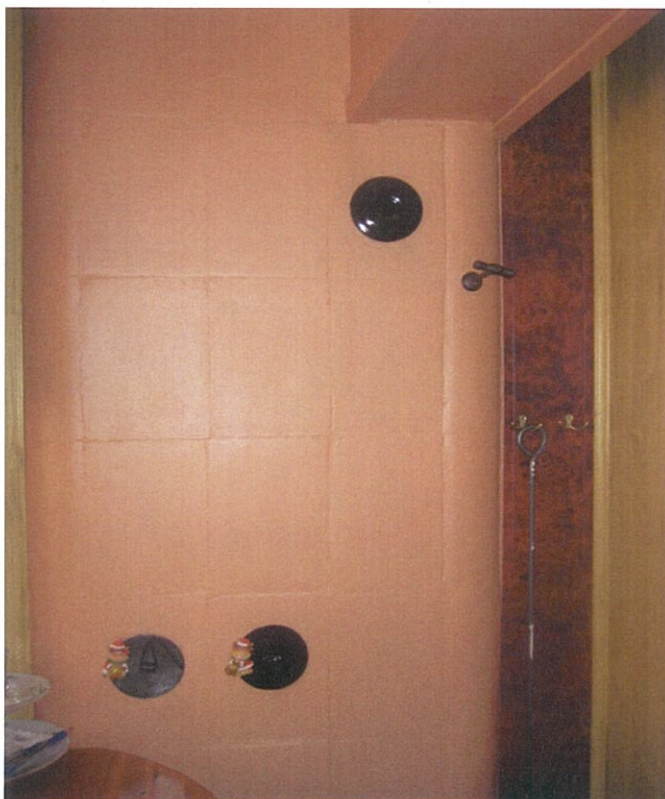
Joonis 8.12 Puhastatud ja uuesti värvitud ahi köögi poolt.
