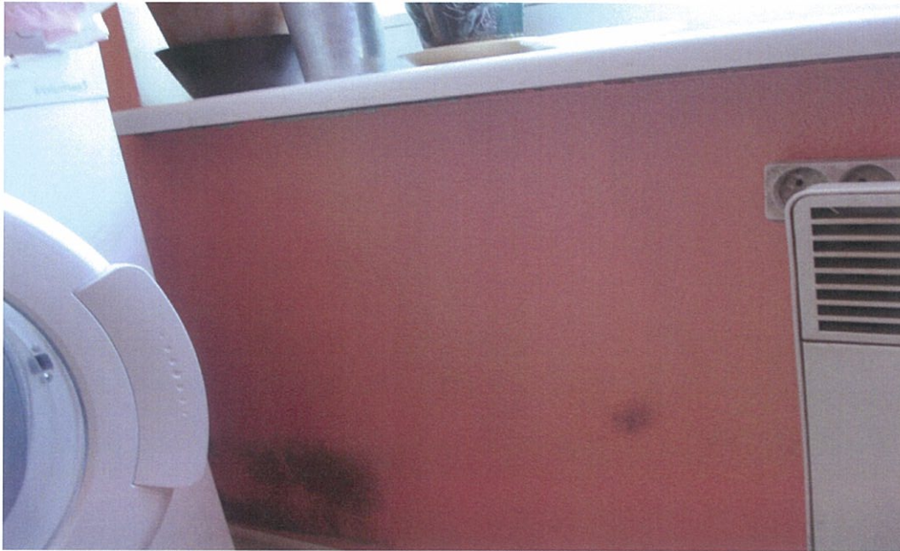
Joonis 8.3 Pidev hallitus köögi seinal (välissein)
