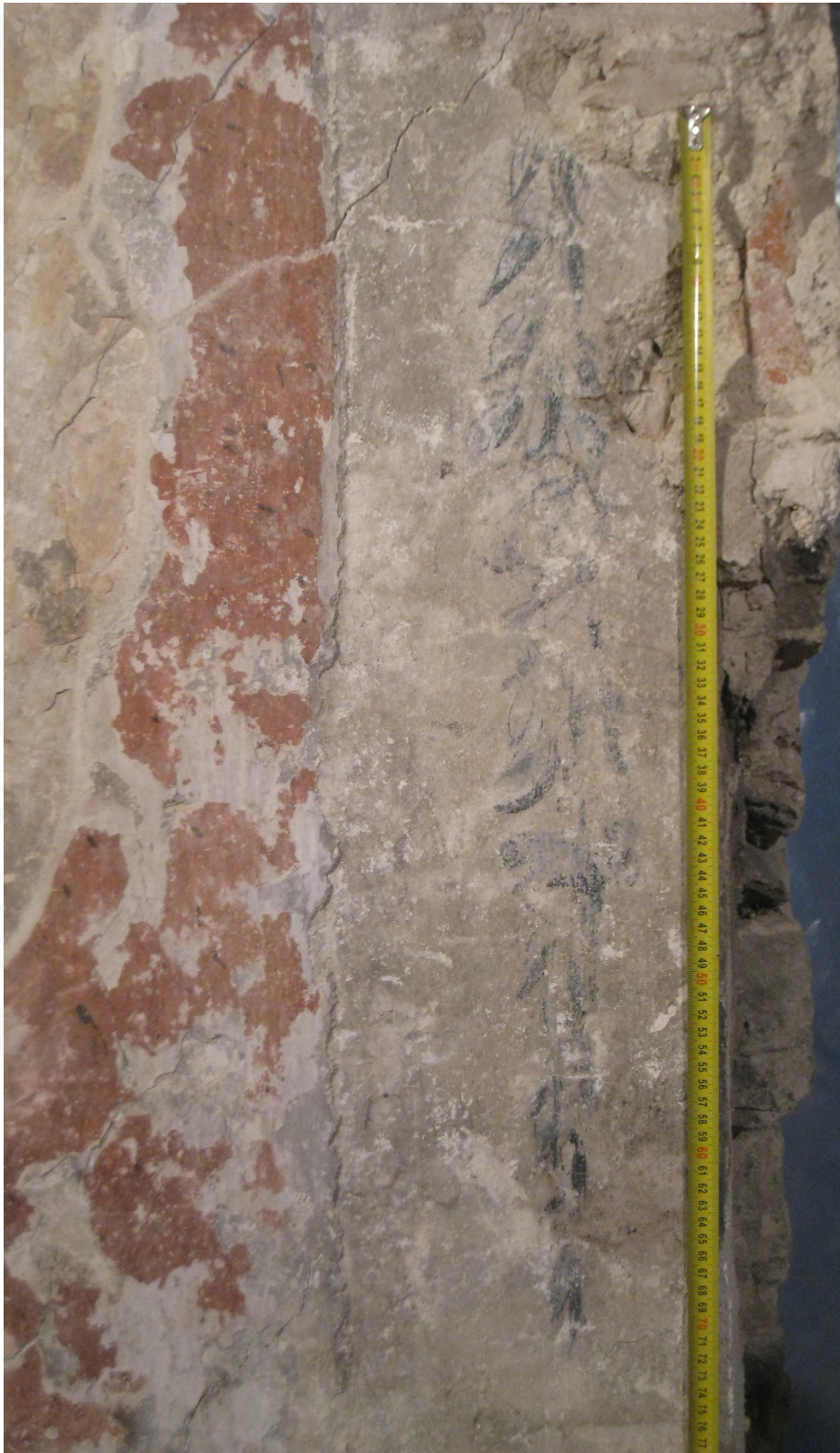
Foto 20. See maaling, mis asub niši ja ukseava vahel on tänaseks kaetud profülaktilise kleebisega (6% Klucel piirituse vesilahuses 1:1 ja 20 m/g mikalent paber) ning selle ette on ehitatud ukseongi piirav telliskividest post. (Foto L.Jäger)
