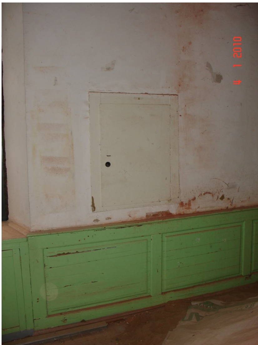
Foto 20. Restaureeritav seinakapp ruumis nr. 124.
