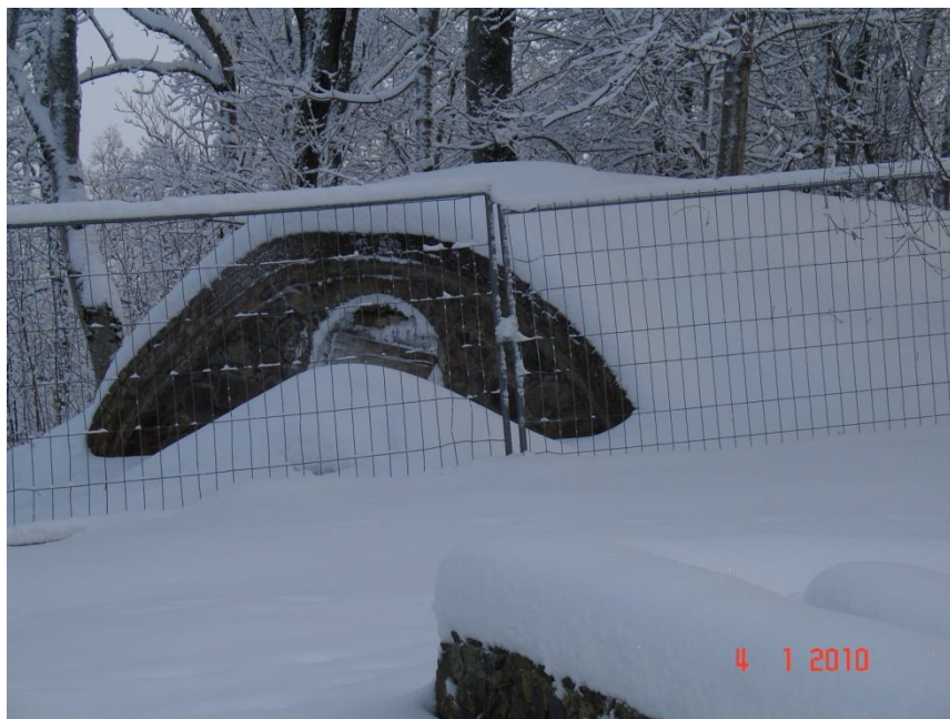
Foto 9. Vana maakividest seintega ja silindervõlviga kelder mõisa peahoone taga.
