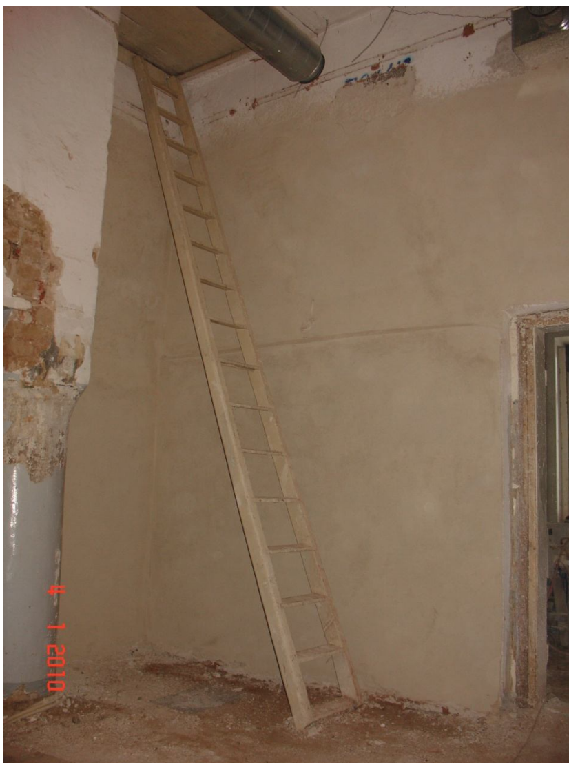
Foto 21. Vana põõningu redel rekreatsiooni ruumis nr. 140.
