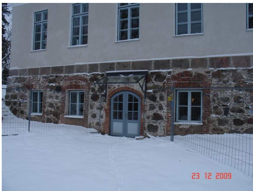
Foto 6. Soklikorruse maakividest vundamendi ja graniitplokkidest sokli vormistus.
