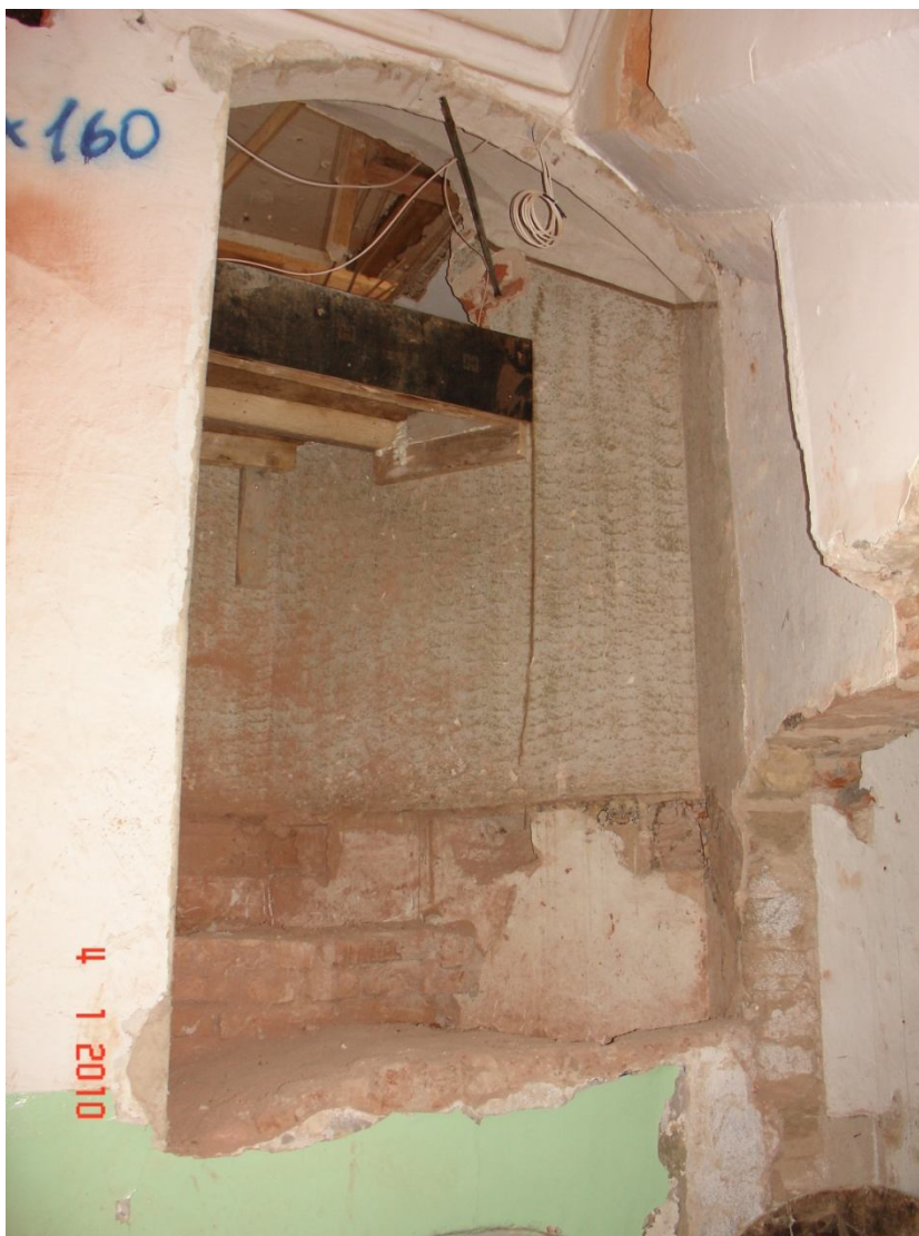
Foto 26. Vana trepi käik rekreatsiooni ruumis nr. 126.
