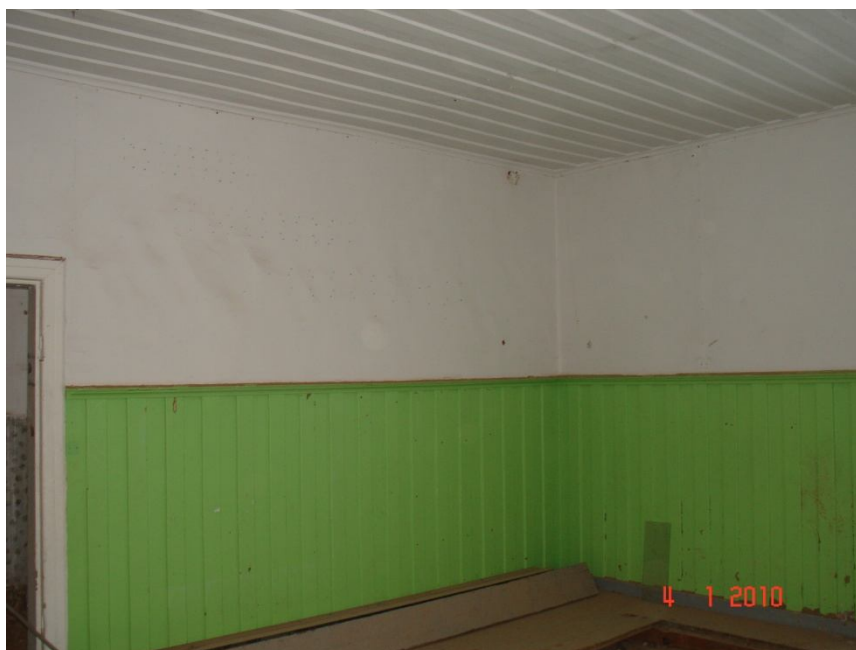
Foto 14. Poola laudis laes ja laudisest tahveldus seintel teisel korrusel ruumis nr. 202.
