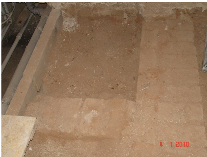
Foto 25. Põrandate alune kanal ruumis nr. 137.
