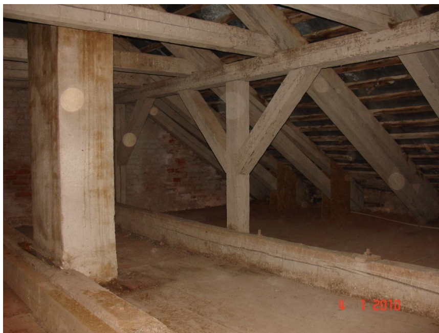
Foto 17. Parempoolse tiibhoone katusekonstruktsioonid.
