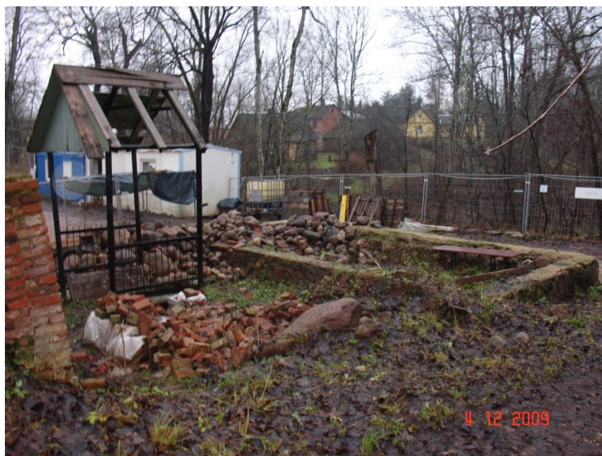
Foto 8. Vana kuuri vundamendid hoone vasakpoolses otsas.
