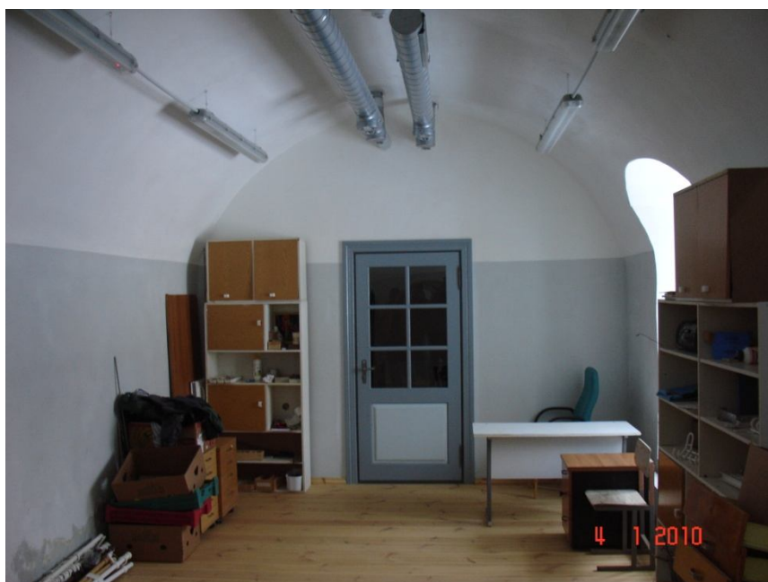
Foto 10. Silindervõlv keldrikorrusel
