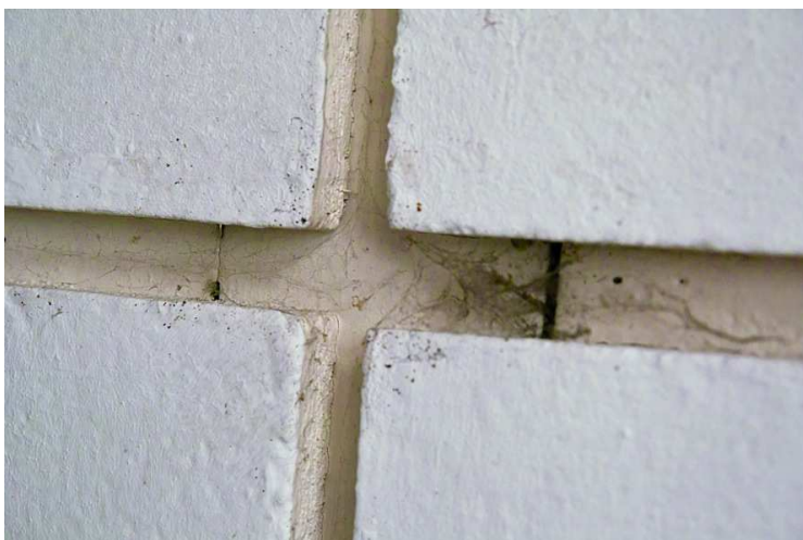
Joonis 34 – lakke paigaldatud saepuruplaat
