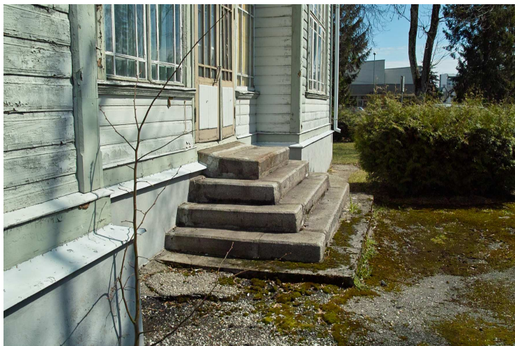
Joonis 14 – vajunud Papli tänava poolne trepp ja trepi esine pinnas
