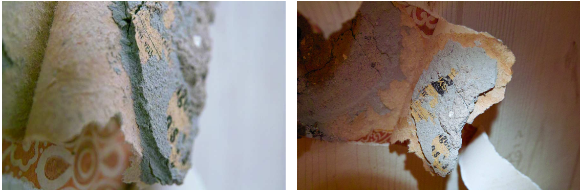
Joonis 34, 35 – krohvialune tapeet 2. korruse ruumis
