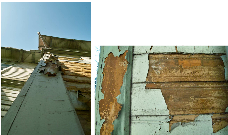
Joonis 20, 21 – värvi ulatuslik koorumine Kuuse tn poolsel fassaadil
