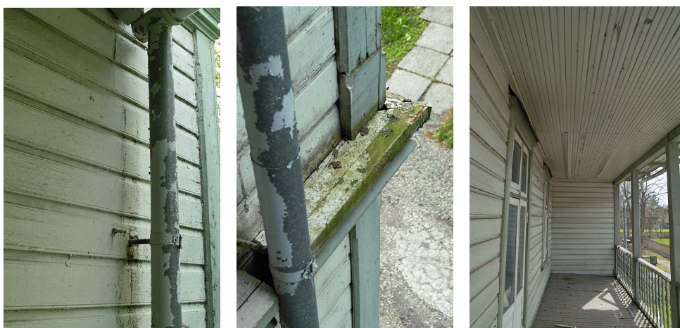
Joonis 22, 23 – värvi koorumine, veekahjustused
