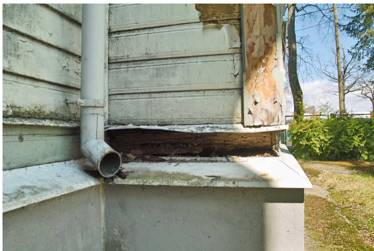
Joonis 17 – pehastunud aluspalk Kuuse tänava poolses seinakonstruktsioonis
