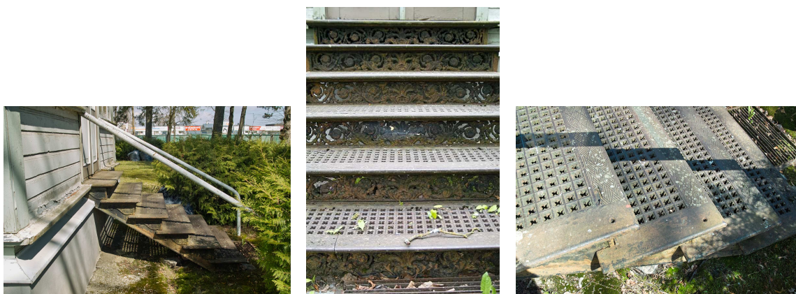
Joonis 14, 15, 16 – Kuuse tänava poolne malmtrepp
