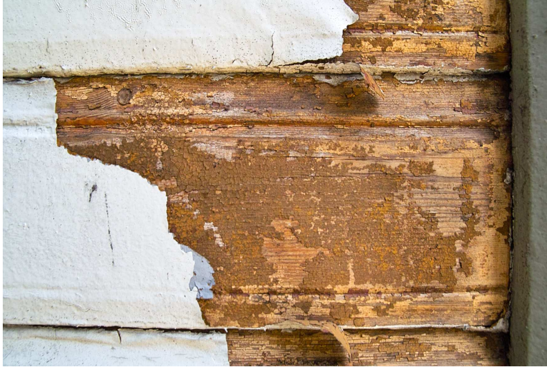
Joonis 2 – koorunud alumised värvikihid laudadel
