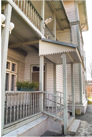
Joonis 4 – juurde ehitatud varikatus ja tuulekoda
