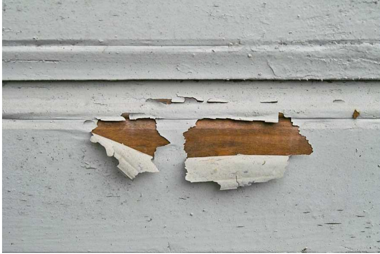
Joonis 18 – värvi koorumine A. H. Tammsaare poolsel fassaadil alumisel laual
