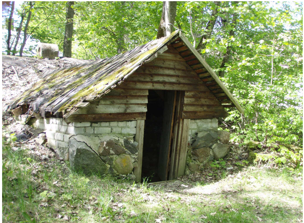
Joonis 13. Keldri tuulekoda 2(parem)
