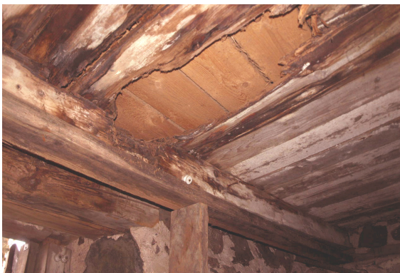
Halvas tehnilises seisukorras maa- aluse veskiruumi vahelae talastik koos ajutise toetusega.
