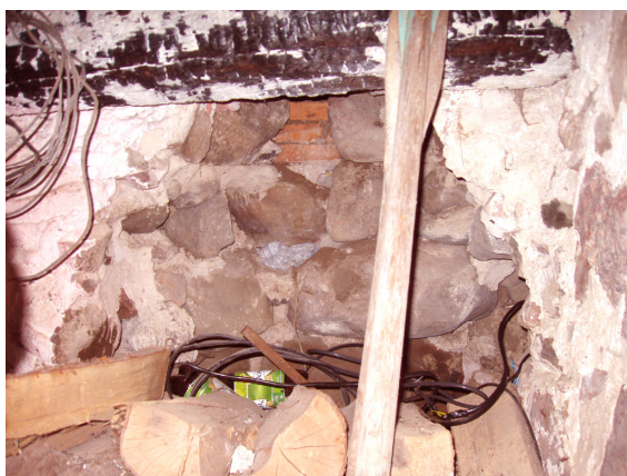
Algne tahumata raudkividest elektrigeneraatori ruumi eluruumidest eraldav vahesein
