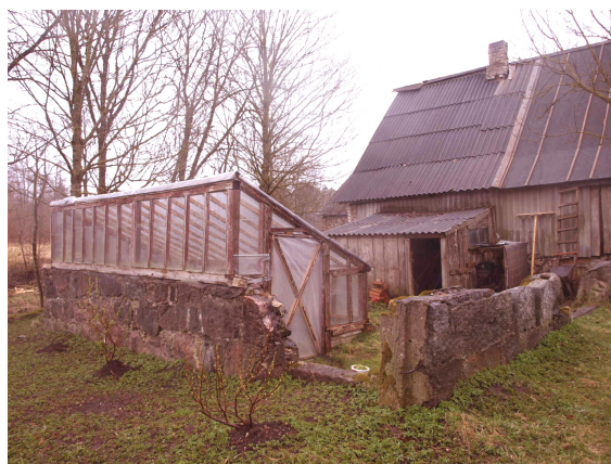
1930. aastatel rajatud tahutud kividest loomalauda kõrge vundament
