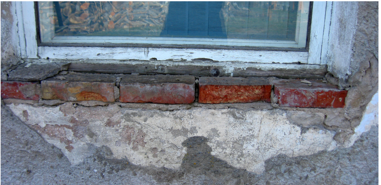
Joonis 16. Krohviparanduse ootel
