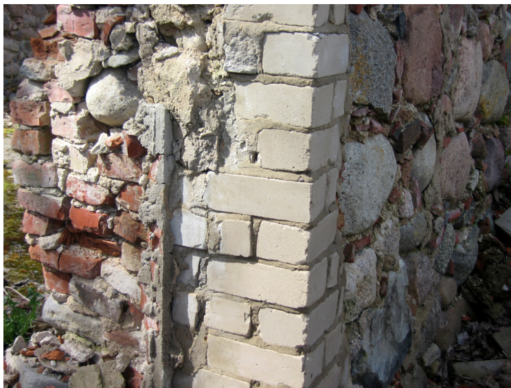
Joonis 25. Hallidest tellistest laotud uus nurk
