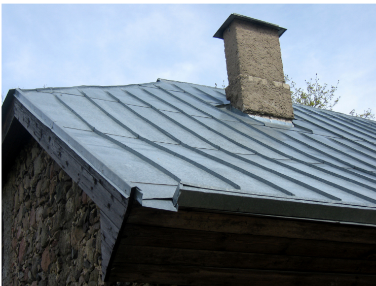
Joonis 28. Vaade kiriku krohvitud korstnale
