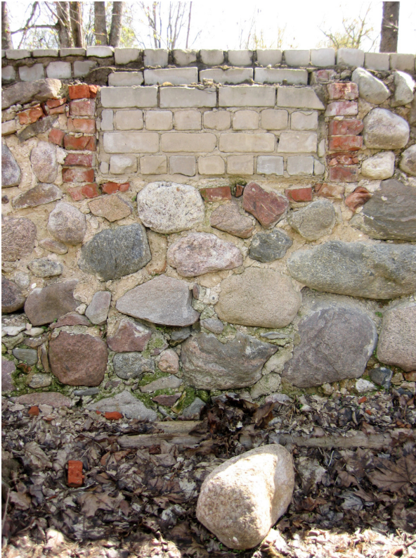
Joonis 23. Täislaotud ava idaküljes
