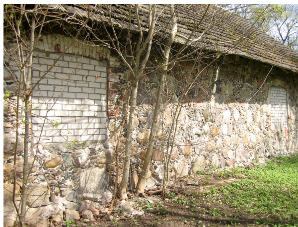
Joonis 19. Täislaotud aknaavad lõunapoolses eterniidiga
