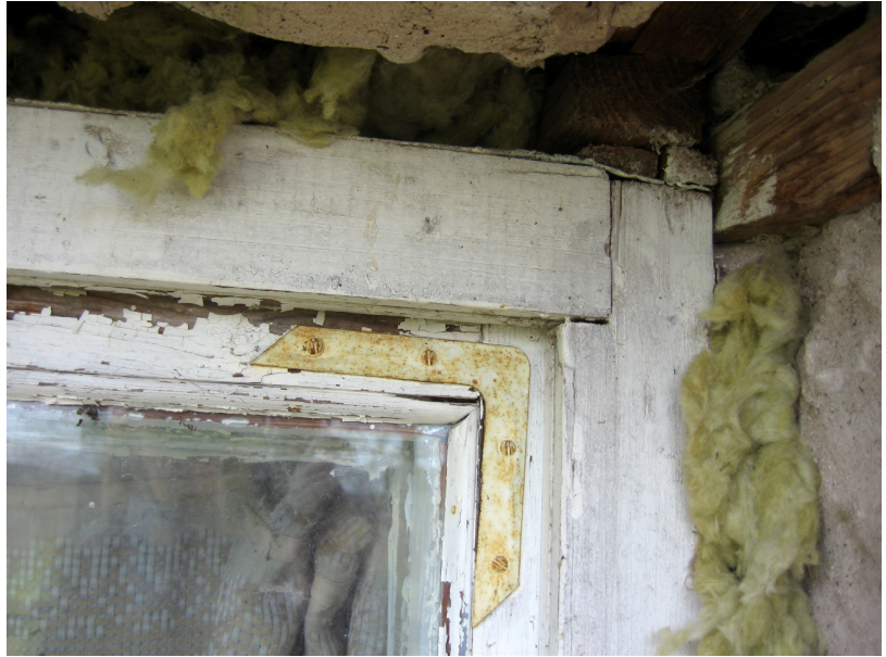
Joonis 15. Halvasti paigaldatud aknad
