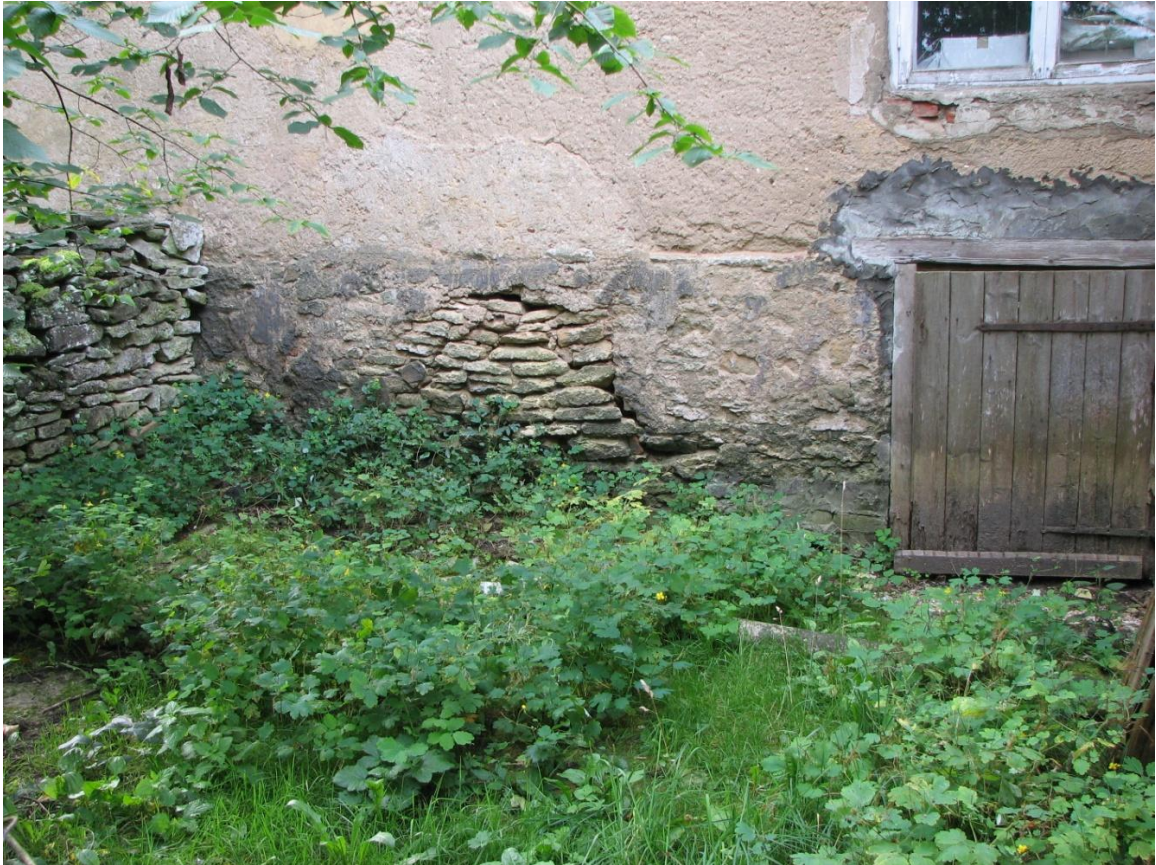
Foto nr. 3 Lampkasti pealne seinosa on väljasurutud. Lagunenud seinosa tuleb lammutada ja uuesti üles laduda.
