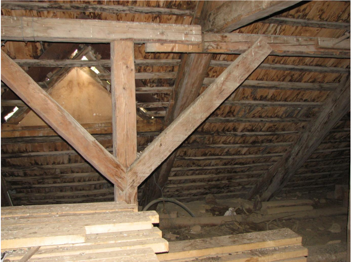
Foto nr. 9: Toolvärgi ühendustapid on lahti vajunud. Toolvärgid vajavad kohendamist.
