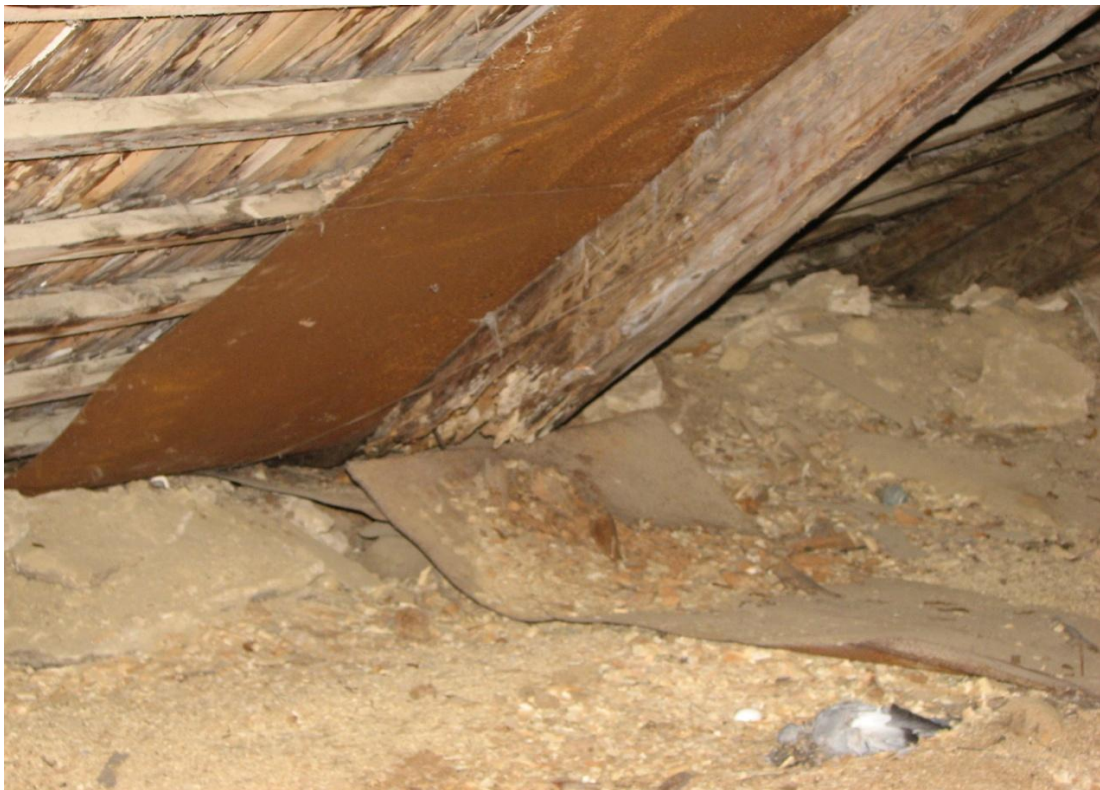
Foto nr. 8: Sarikad on liigse niiskuse tõttu pehkinud. Kahjustada saanud sarika otsad vajavad proteesimist.
