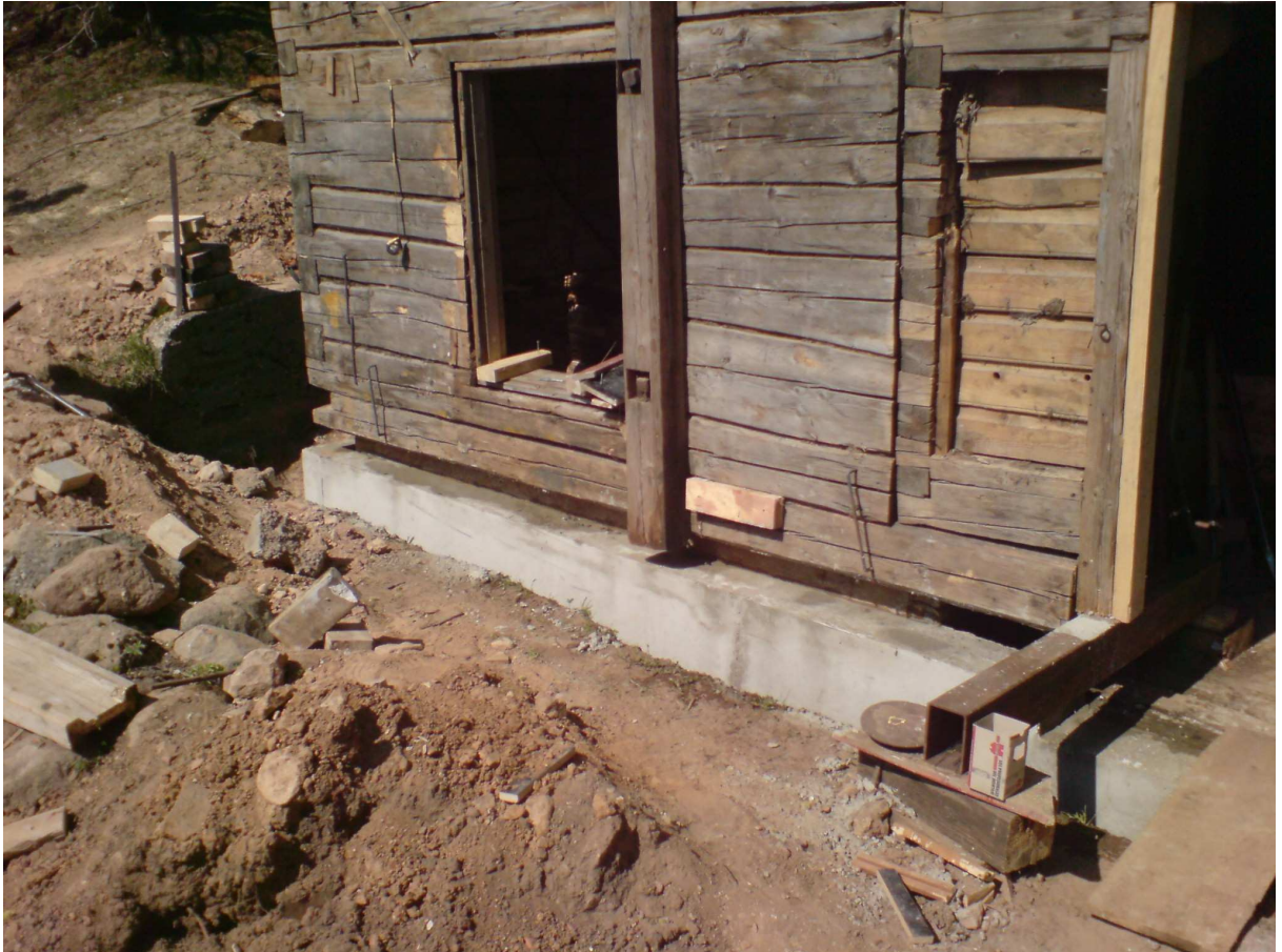
Joonis 2 –uus vundament lõunaküljel
