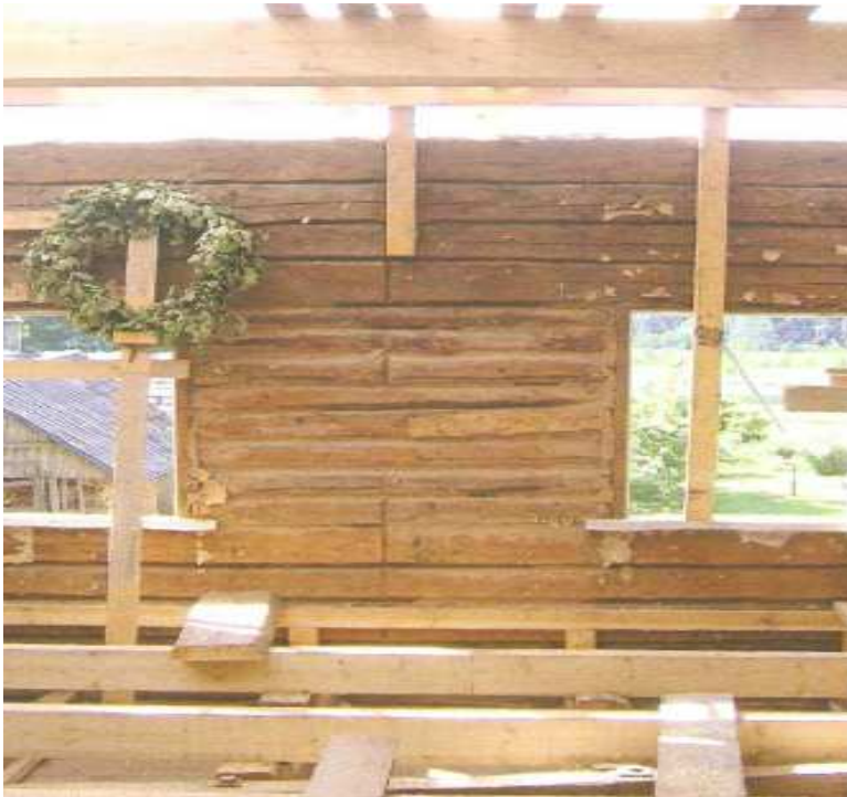
Joonis 16 – lisatalastik I korruse laes
