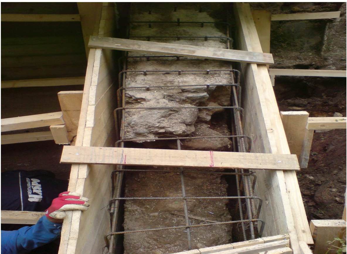
Joonis 11– idakülje tugimüür enne betoneerimist
