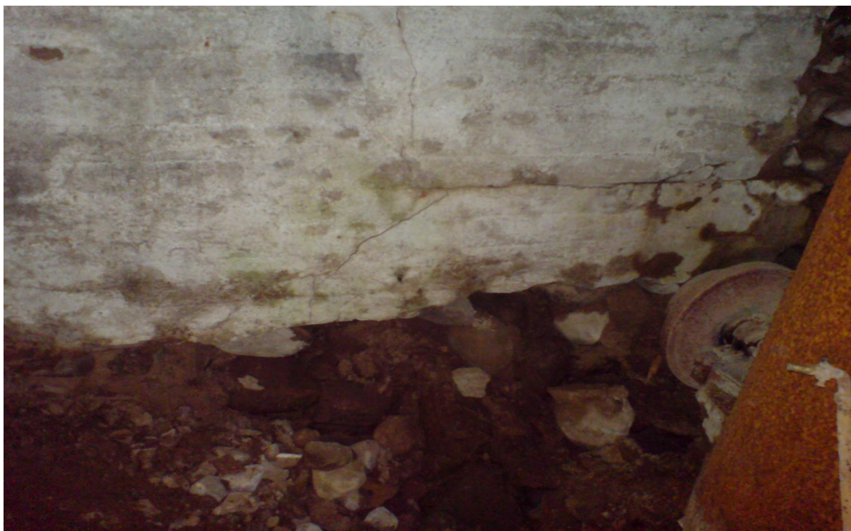
Joonis 7 –hoone kirdenurk seestpoolt
