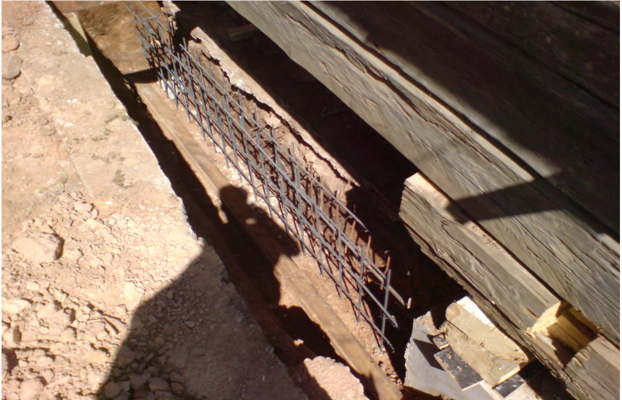
Joonis 4 –vundamendi armeering lääneküljes
