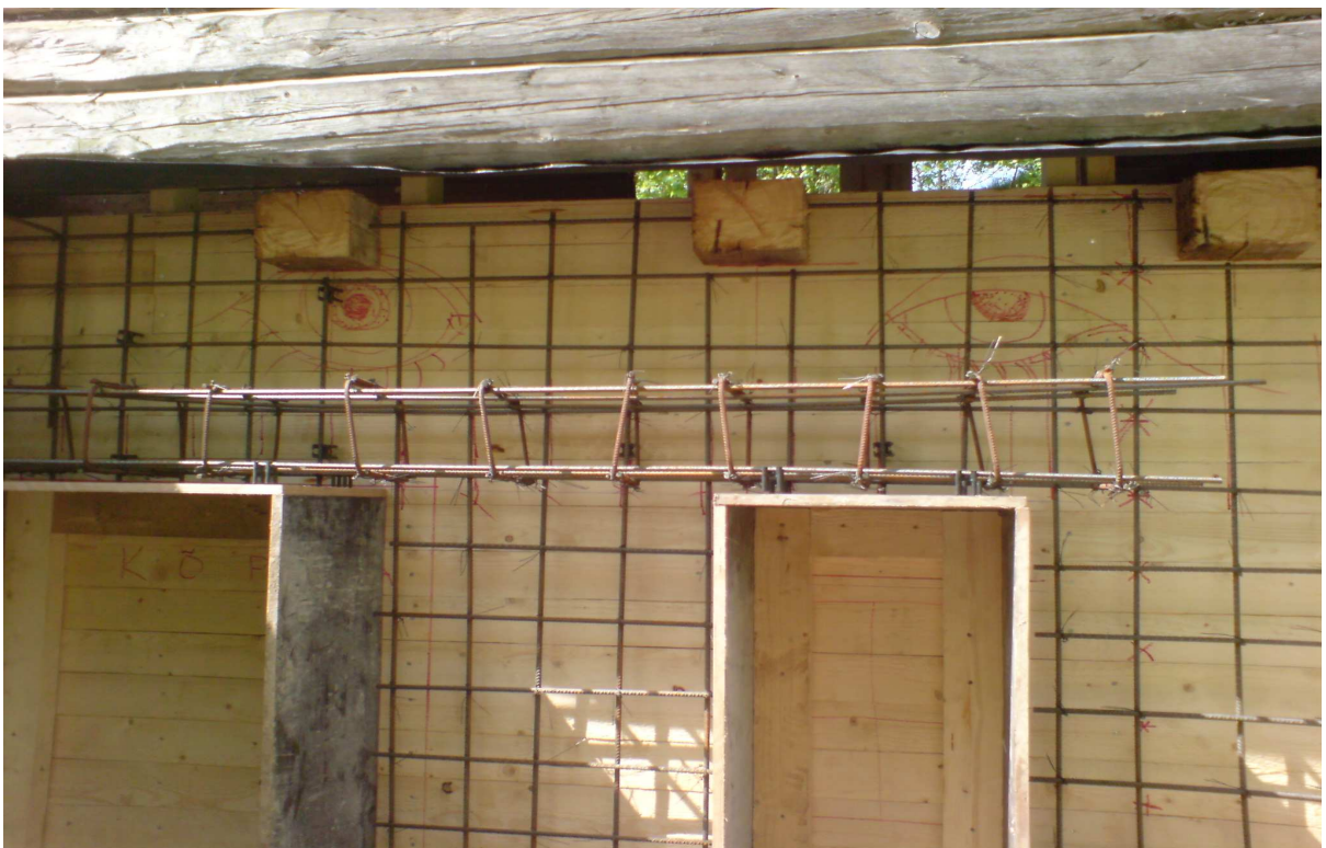
Joonis 9 –idaseina armeerimistööd
