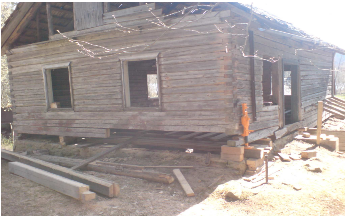
Joonis 5 –põhjakülje vundament
