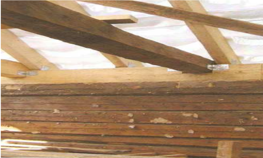
Joonis 17 – II korruse laetalad
