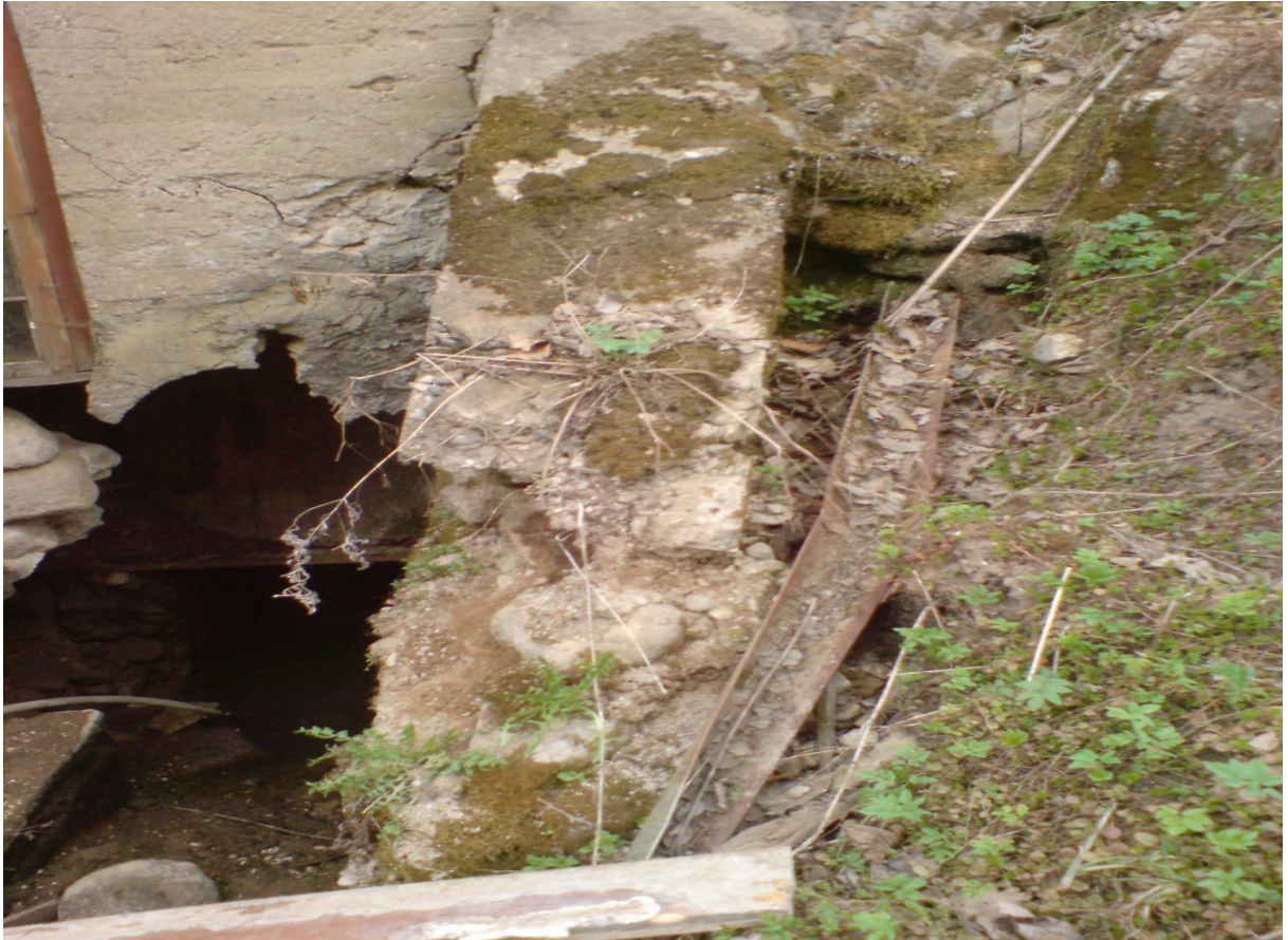
Joonis 8 –idakülje tugimüür ja lagununud sein
