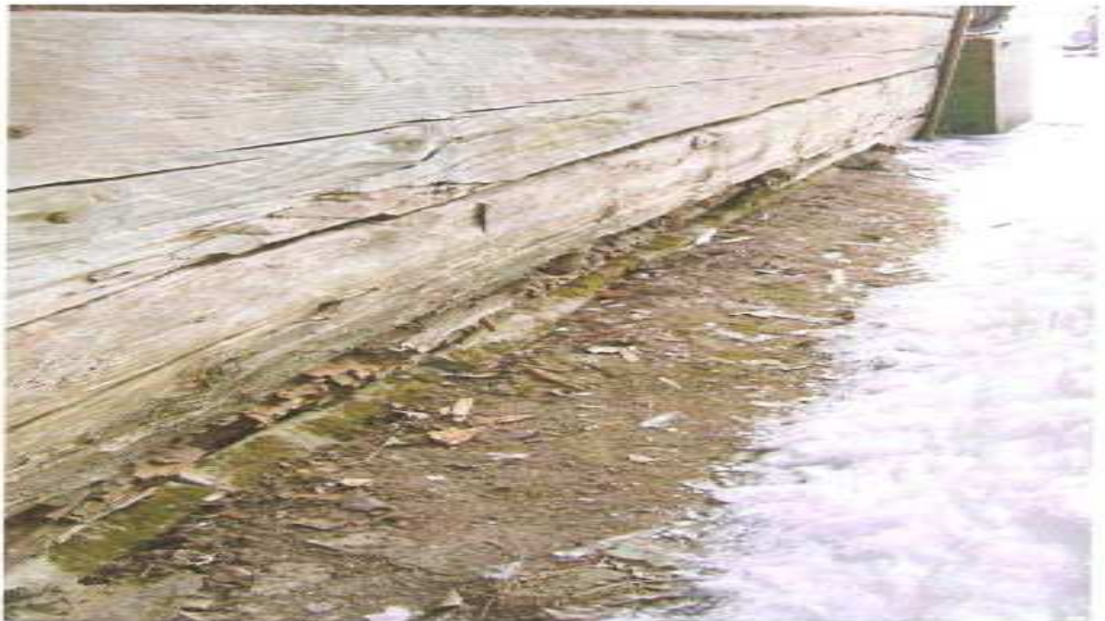
Joonis 1 - seinad toetusid suures osas otse pinnasele
