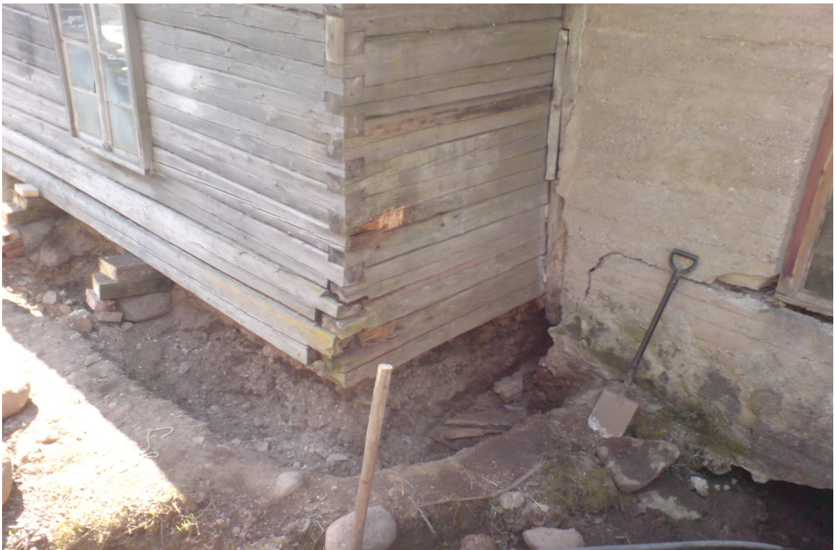
Joonis 3 –vundamenti kaevis idaküljes
