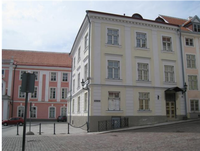
Joonis 3 Vaade hoone lõuna-ja idafassaadile
