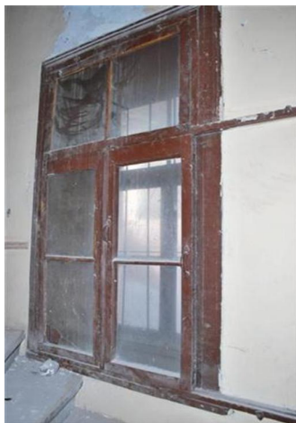
Joonis 11 Restaureeritav puitaken
