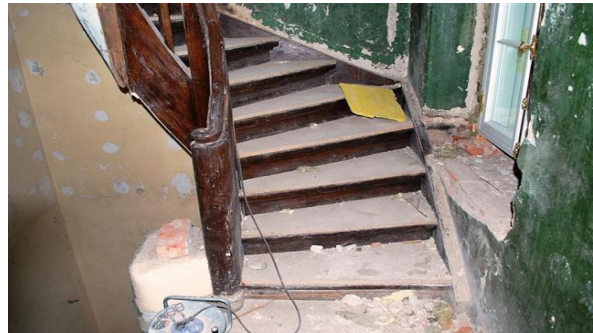
Joonis 10 Pööningu puittrepp
