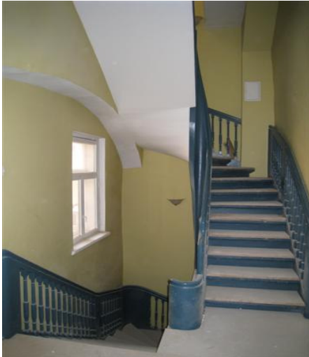
Joonis 9 Hoone puidust peatrepp
