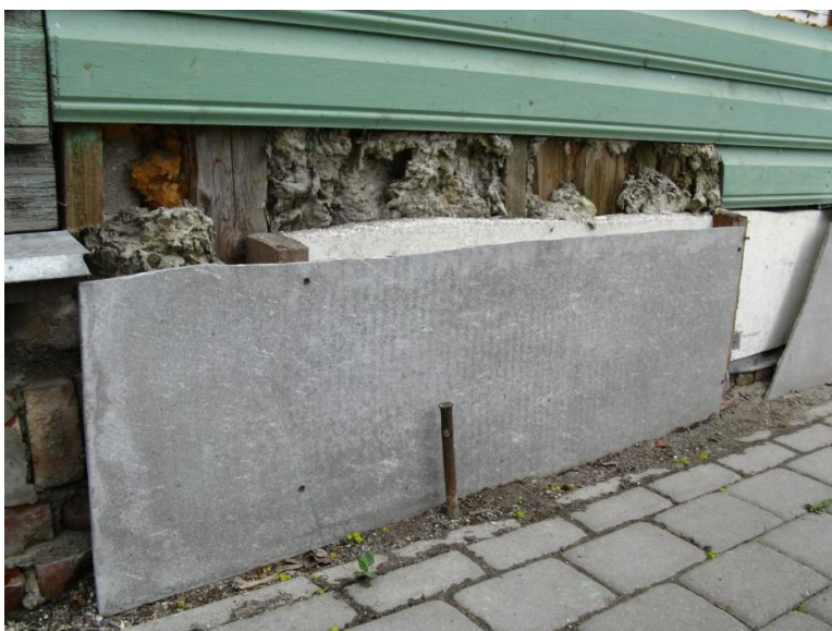
Joonis 7: Tellistest laotud vundament, mis on osaliselt soojustatud penoplastiga
