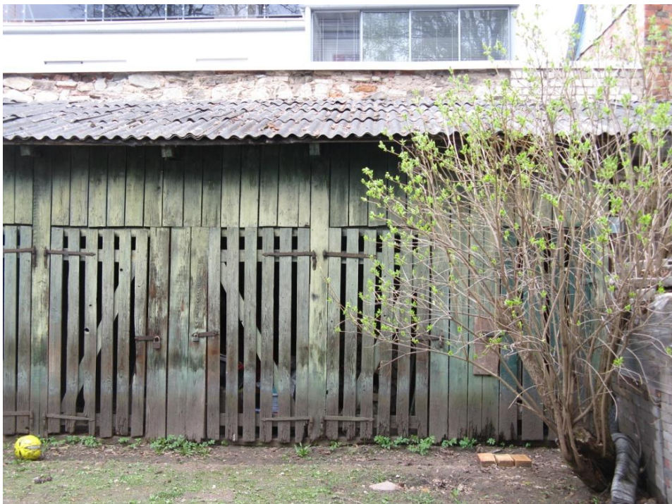
Joonis 35: Pesuköögiga seotud ühekorruseline puukuur
