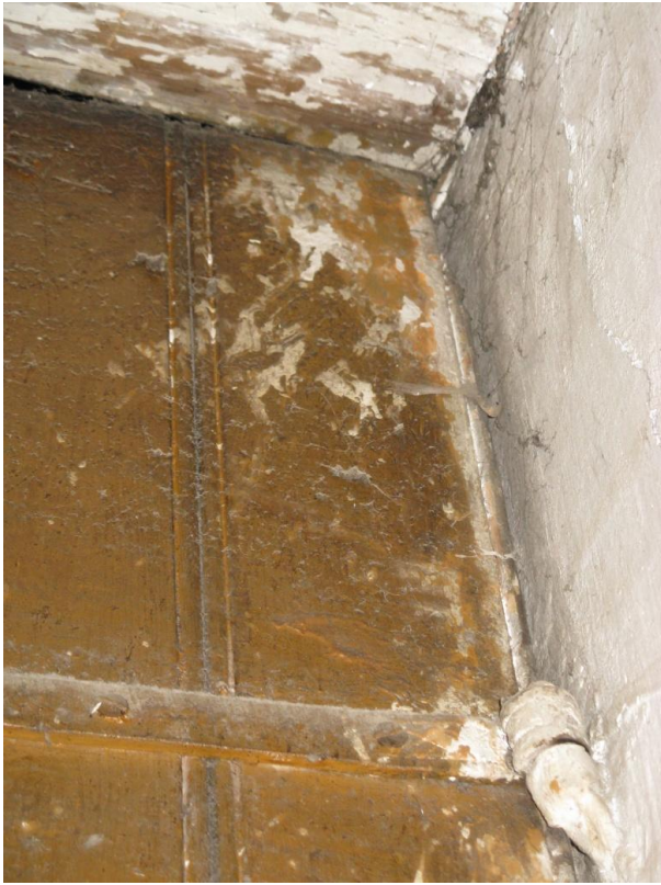
Joonis 30: Trepikoja ja pööningu vaheuks on veekahjustustega
