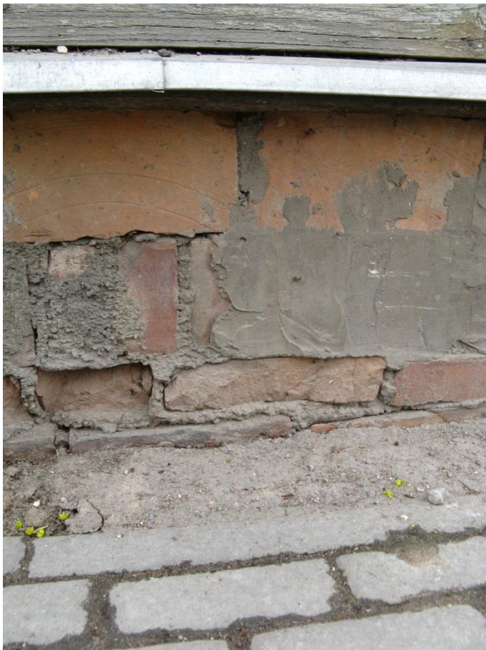
Joonis 6: Tellistest laotud vundament, mis on osaliselt tsementkrohviga kaetud
