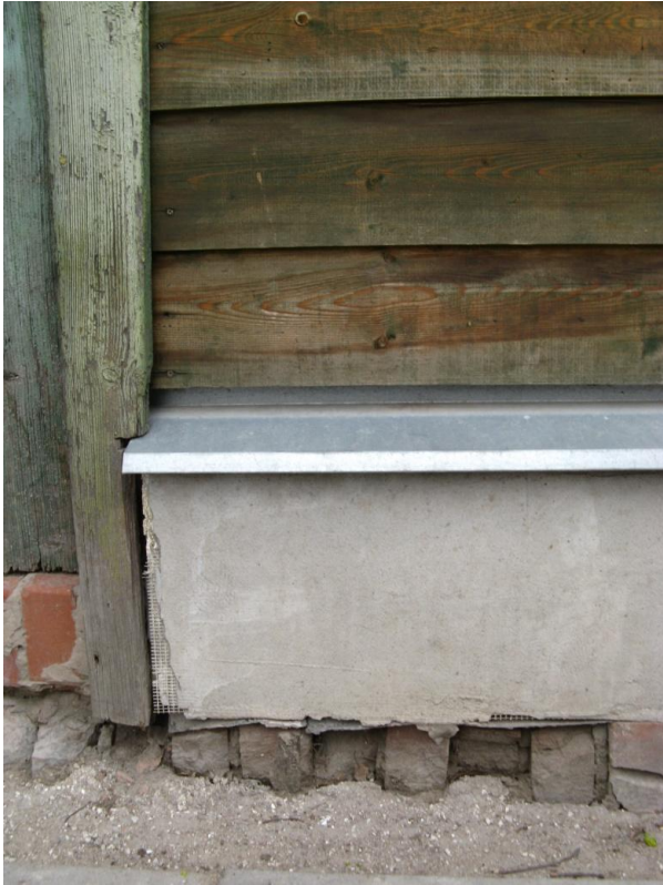
Joonis 8: Tellistest laotud vundament, mis on kaetud penoplasti ja tsementkrohviga
