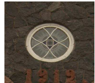
Joonis 3. Idafassaadi roosaken väljastpoolt
