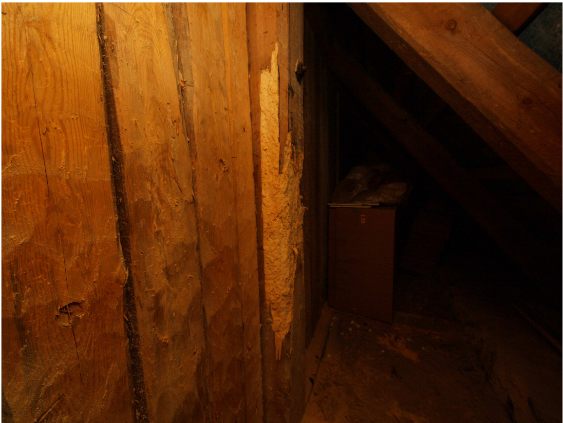
Joonis L7-9. Kahjustused lõunaküljes katusealuses (seina alumise ja keskmise vöö vaheline osa)
