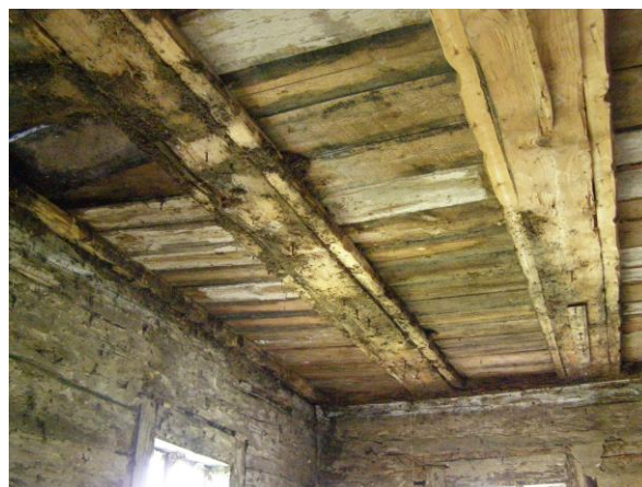
Joonis 8, Taaskasutatud laudad ( must lagi )
