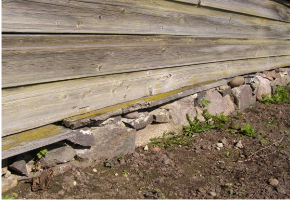
Joonis 13, Lagunenud vundament
