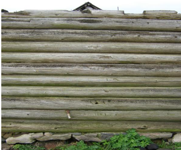
Joonis 7, Taaskasutatud otsaseinapalgid
