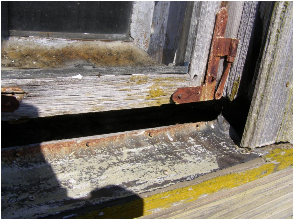
Joonis 15, Aknaalust vööpalki ei ole enam
