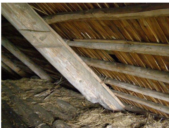
Joonis 9, Taaskasutatud sarikas
