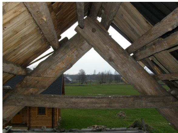
Joonis 10, Taaskasutatud sarikas
