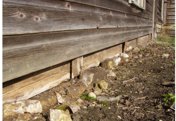
Joonis 14, Pinnase tõusmine
