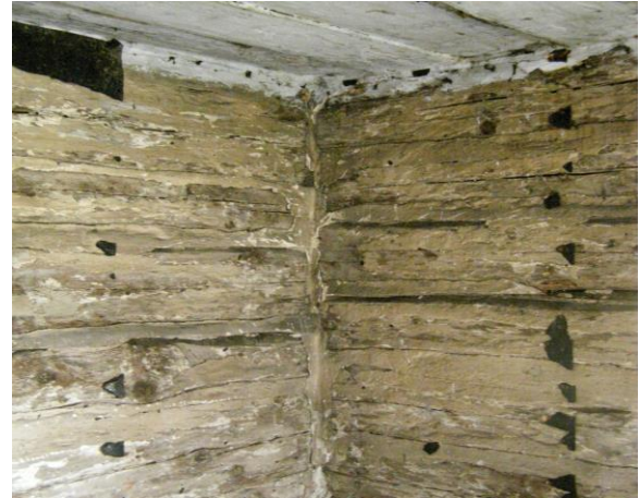
Joonis 12, Tõrvapapi jäänused seintel
