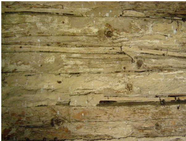
Joonis 11, Palgivahede täitmine
