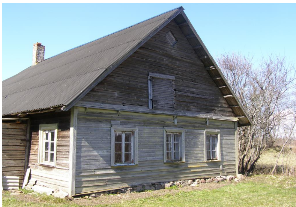
Joonis 25, Uuendatud välisvooder akenda vahelises osas
