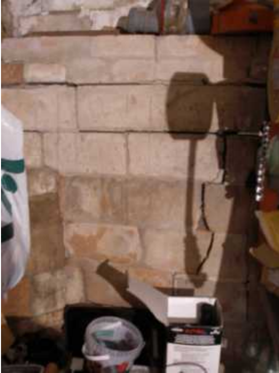
Joonis nr.21 Pragunenud soemüür.
