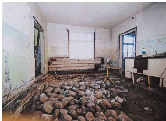
Joonis 16. Lahti võetud köögi põrand.
