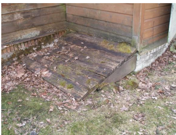
Joonis 6. Lampkast ja silikaattellistes vund.
