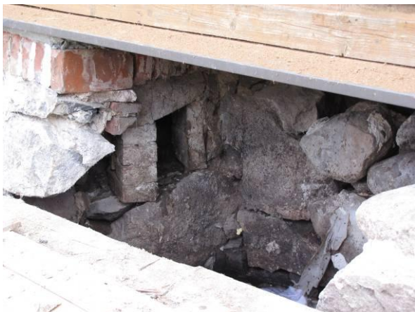
Joonis 8. Lampkastis vent.kanal korstnasse.
