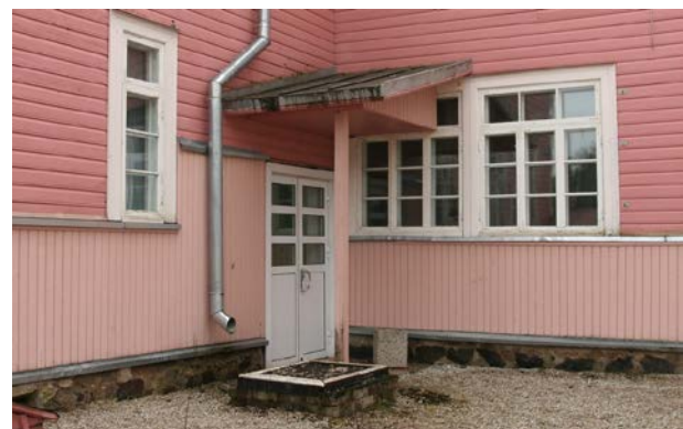
Foto 16. Katkine vihmaveetoru ohustab laudist ja selle all olevaid palke. Foto: S. Mälk, aprill 2010.
