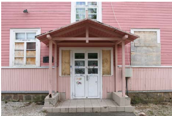
Foto 16. Katkine vihmaveetoru ohustab laudist ja selle all olevaid palke. Foto: S. Mälk, aprill 2010.
