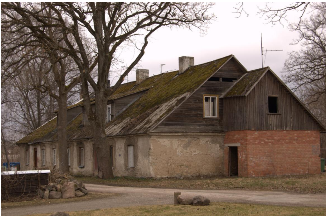
m) Foto Tall-tõllakuuri vaade lõunast 2010a. 1980-te paiku ehitatud punastest kärgtellistest trepikoda, katusekalle viidu muudetud samaks põhikatuse kaldega.
