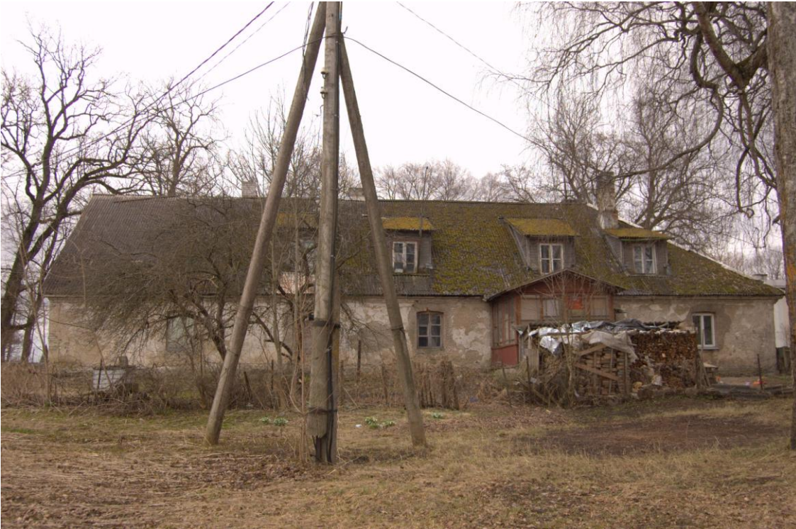
n) Foto Tall-tõllakuuri vaade läänest 2010a. Veranda ehitatud 1925-53a vahel.
