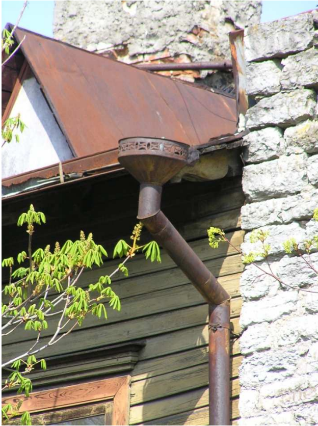
FOTO 21: vihmavee äravoolusüsteemi arvatav originaaldetail
