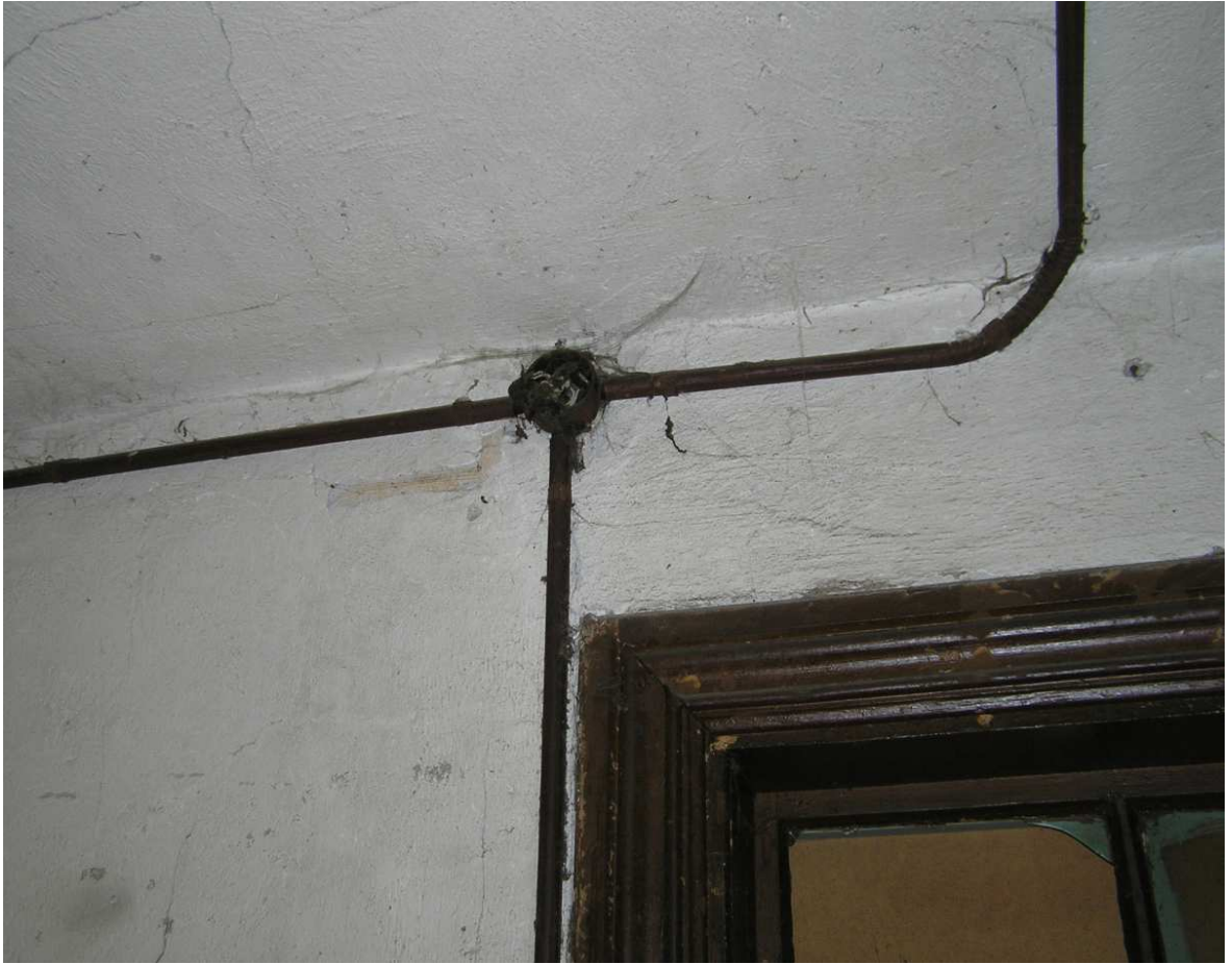
FOTO 35: amortiseerunud elektrisüsteem
