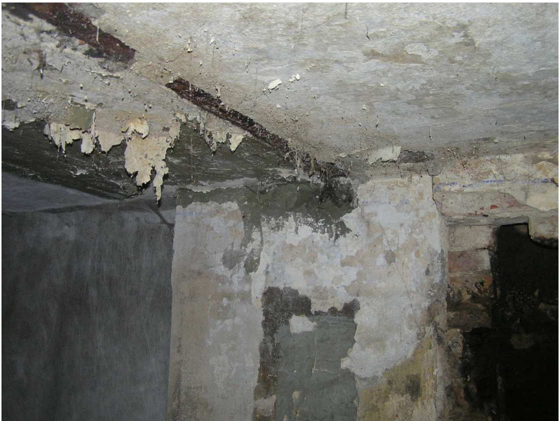
FOTO 22: Keldrilae terastalad on korrudeerunud ja vajavad puhastamist.
