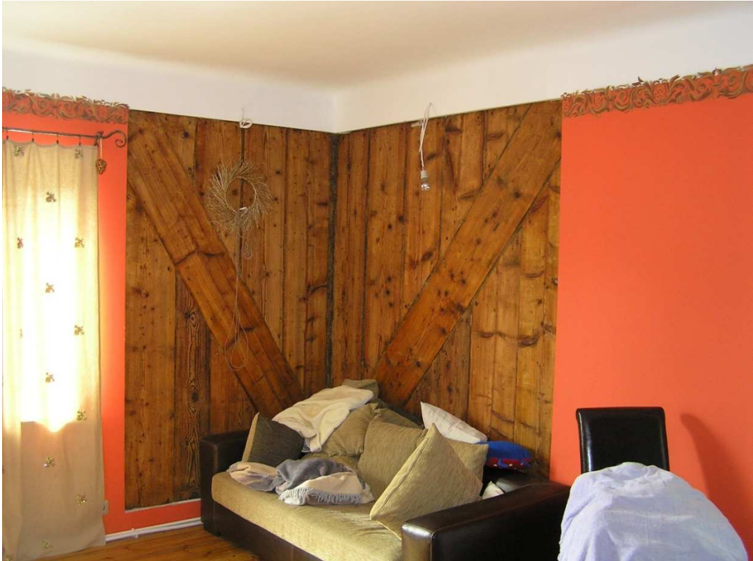
FOTO 23: juurdeehitatud majaosa välisseinakonstruktsioon (topeltplanksein)
