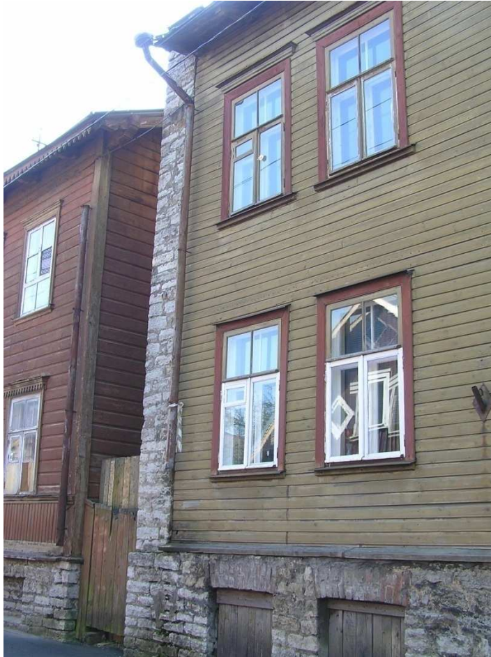
FOTO 29: hoone fassaad – avade ümbrused on vormistatud mitme erineva profiiliga laudadest, idapoolne päekivisein
