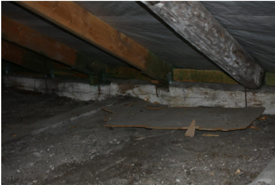
Joonis XXXI – Sarikate kinnitused müüriatile
