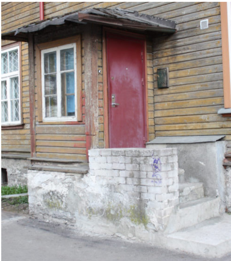
Joonis IV – Trepi külje parandused silikaattellisega
