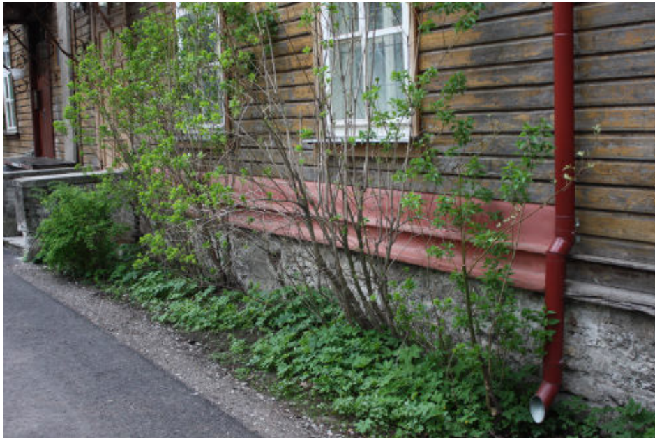
Joonis XI – Plekiga kaetud soklilaud ja horisontaalvöö
