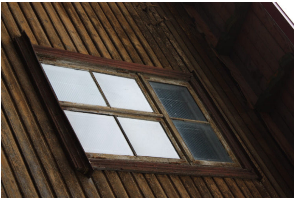
Joonis XVIII – Algsed kuuese raamijaotusega puitaknad
