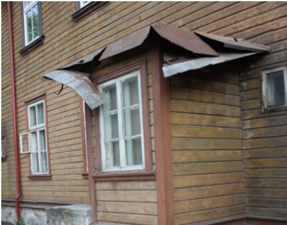
Joonis XXXIV – Kehvas seisus väljaehituse katus
