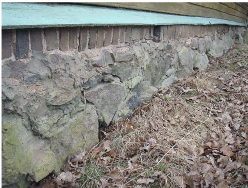
Joonis 3. Maakivist sokkel tellistest vööga
