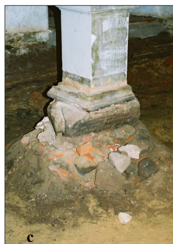
Joonis.5. Puhja kiriku fotod: (a) seest vaade itta, puit põrand eemaldatud ; (b) siseinte saneerimistööd; (c) lahti võetud rõdu posti, enne tugevdamist;(d) posti tugevdamine. Foto: 2005.Wunibald Ehitus OÜ, M. Perm.
