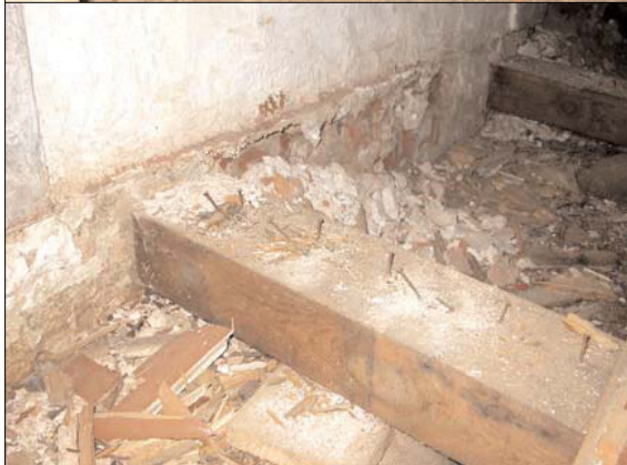
Joonis.5. Vana seenekahjustusega põranda fragmendid, mida hiljem eemaldatakse. Foto: Lea Stroh 2003..
