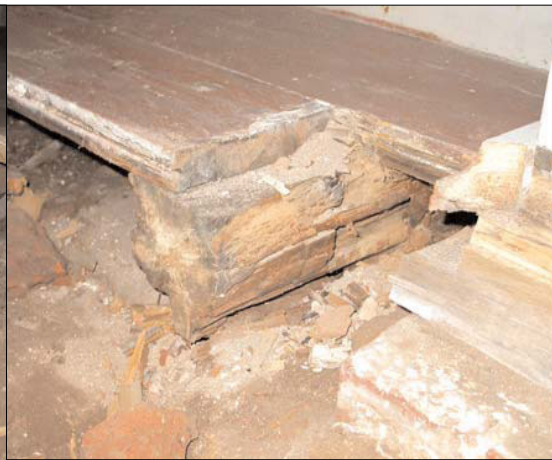
Joonis.5. Vana seenekahjustusega põranda fragmendid, mida hiljem eemaldatakse. Foto: Lea Stroh 2003..
