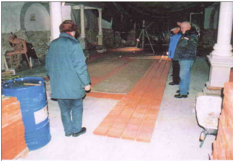
Joonis.7. Puhja kiriku põrandakivide paigaldamine Foto: 2005. M. Perm.
