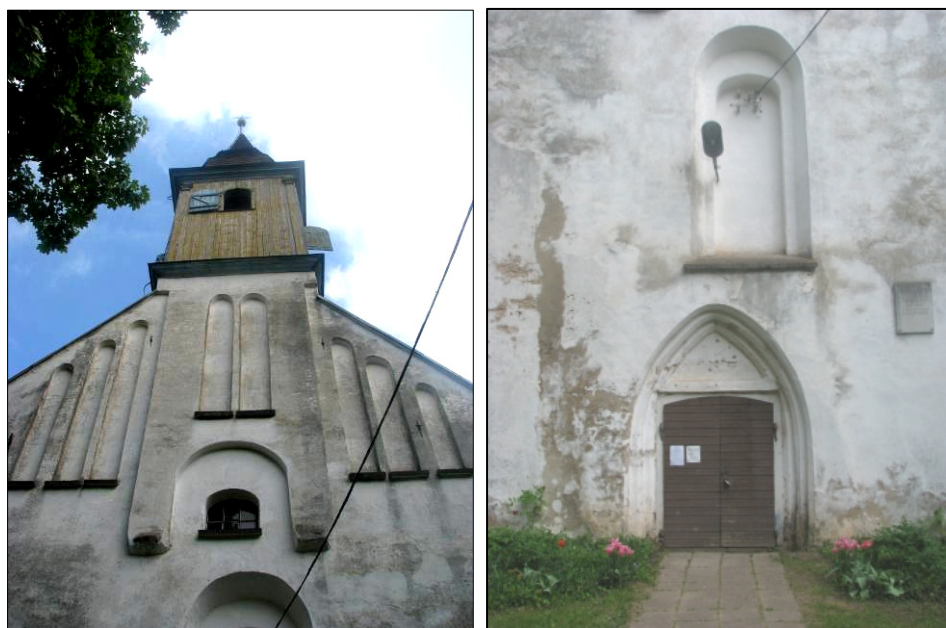
Joonis D.2. Puhja kiriku Lääne fassaad. Foto: Maksim Kurotskin 2010 a. kevad .
