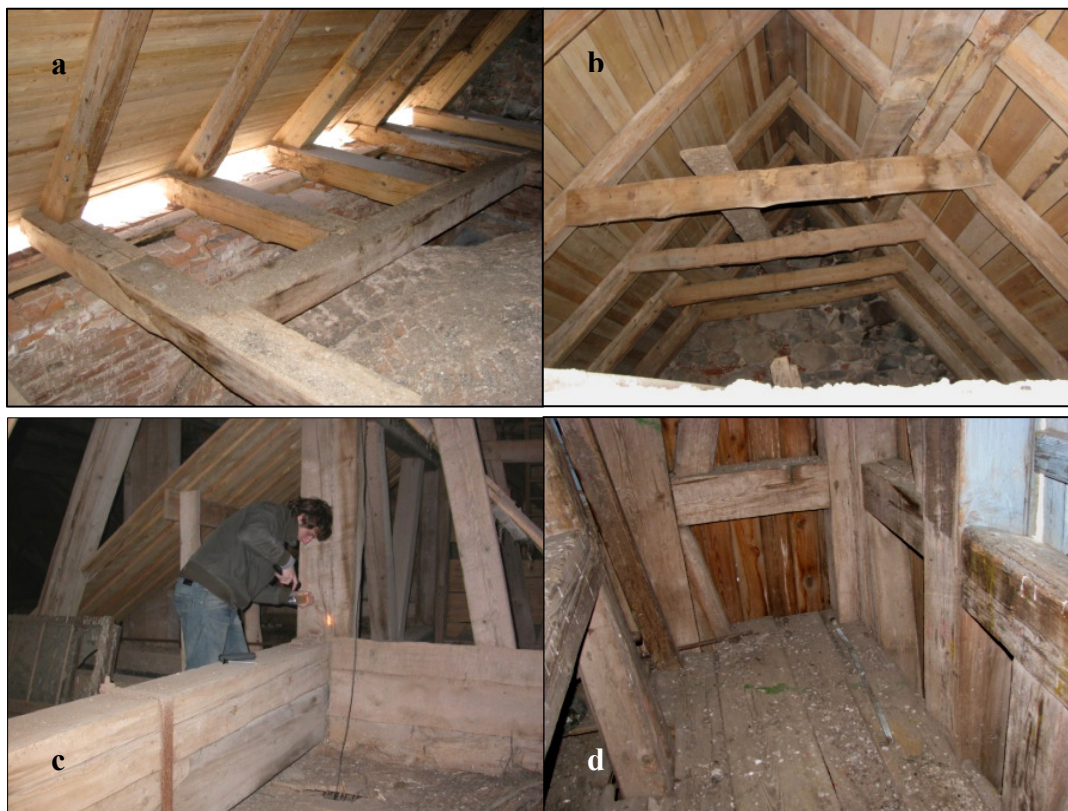
Joonis P.10. Puhja kiriku (a) ja (b) kooriruumi katus; (c)torni tugiraam; (d) torni põrand.
