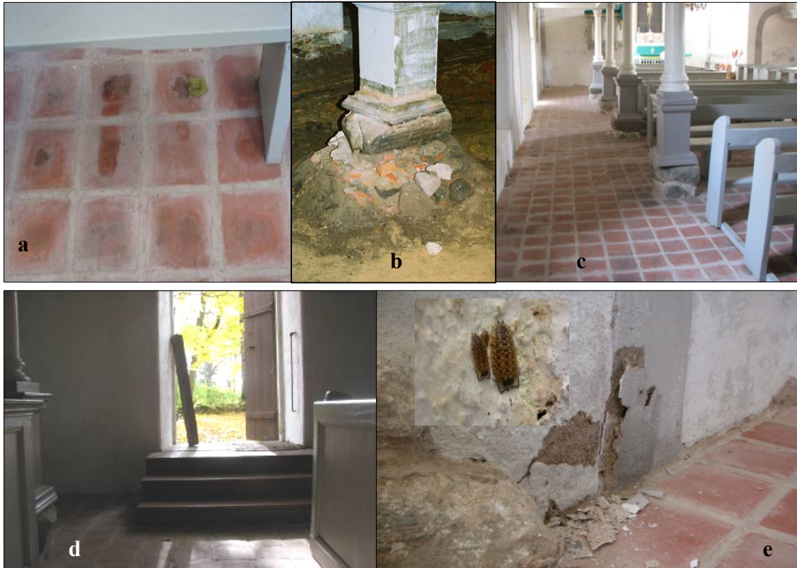
Joonis P.8. Puhja kiriku (a) kooriruumi põranda frangemt; (b) remondijärgus rõdupost; (c) pikihoone põrand; (d) seest vaade lõuna; (e) põranda ja seina sõlm lõuna sissepääsu kohal.
