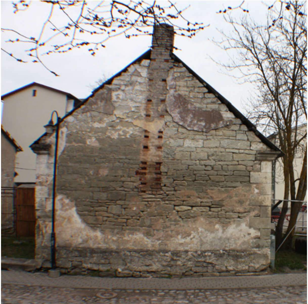
Joonis 21 Vaade abihoonele Kohtu tänavalt. Seinas eritub soklimüüritise üleminek seinaks.
