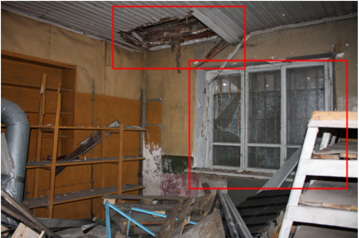
Joonis 24. Vaade siseruumist. Avatäidete tüüp. Avatud pehkinud laekonstruktsioon
