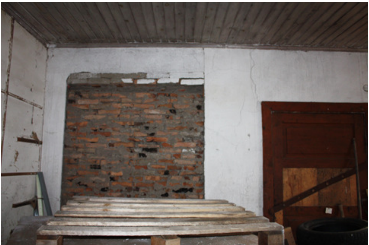
Joonis 23. Vaade siseruumist. Hoone keskosas täis ehitatud avad
