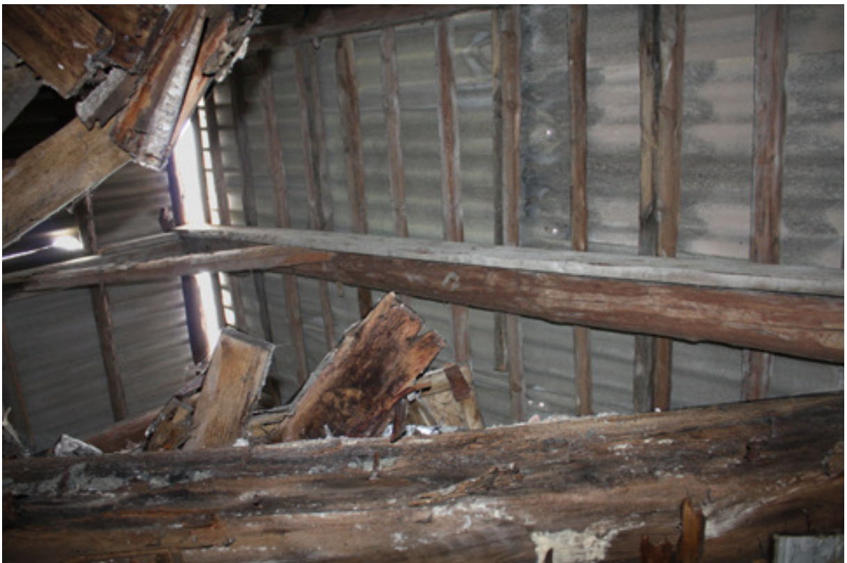
Joonis 25. Katusekonstruktsioon. Ümarpuidust sarikad, roovil eterniit Esiplaanil pehkinud laetala
