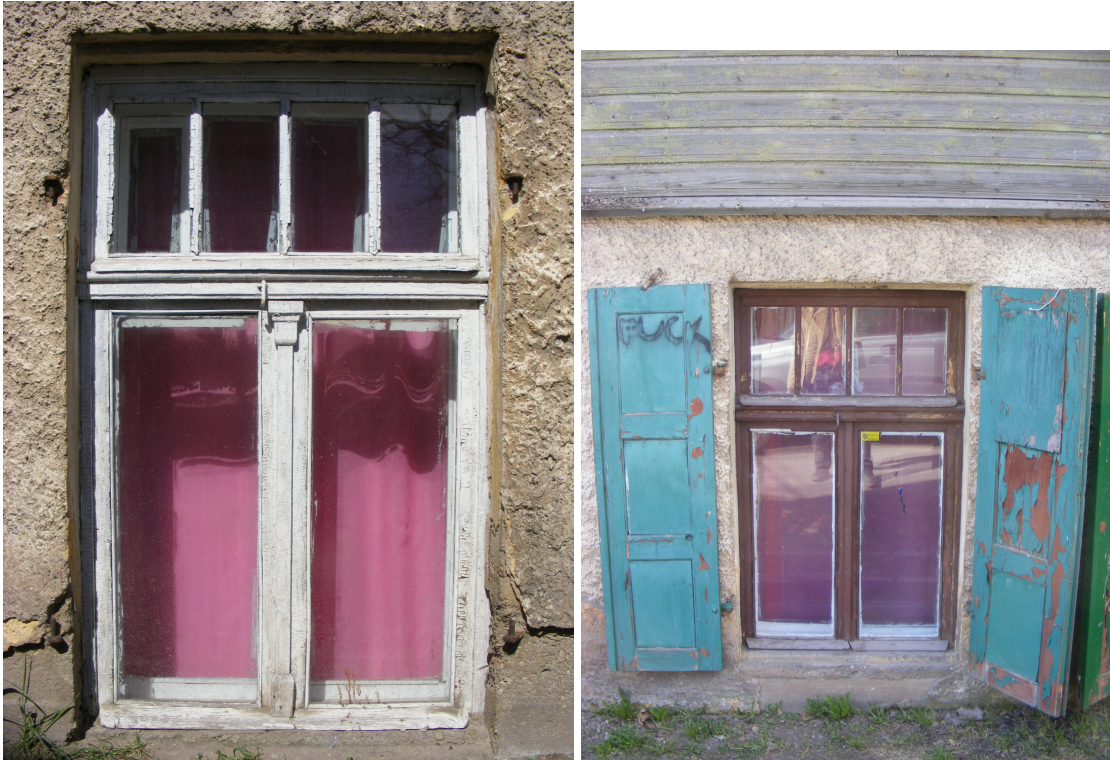
Joonis nr 15. Hoone soklikorrusel asuvad originaalaknad, millest Tähe tn poolsetel on alles ka aknaluugid. Allikas: Edgar Kaare, aprill 2010.
