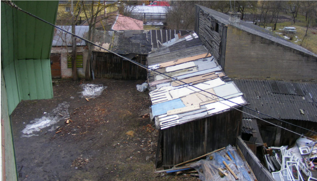
Joonis nr 24. Puukuuride katused on kriitilises seisundis. Allikas: Edgar Kaare, aprill 2010.
