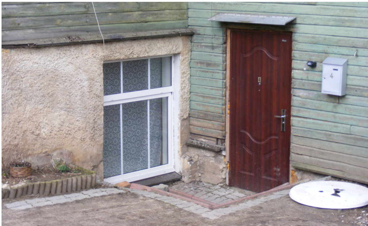
Joonis nr 14. Vaade hoone tagafassaadi poolsele juurdepääsule. Ümbritsev maapind on aastakümnetega kerkinud, mille tulemusel on ustele ja akendele rajatud tagasiasteid. Allikas: Edgar Kaare, aprill 2010.
