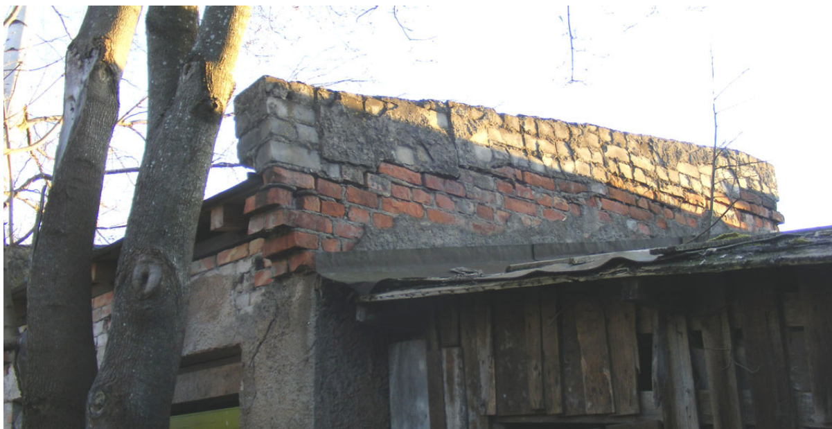
Joonis nr 23. Pesuköögi tulemüür, millele on tehtud silikaattellistega parandusi. Allikas: Edgar Kaare, aprill 2010.
