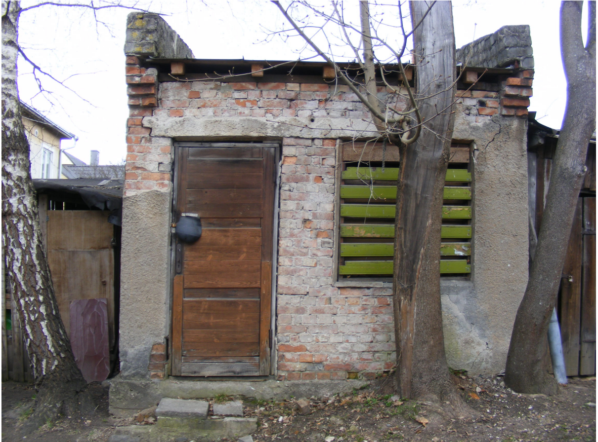
Joonis nr 9. Krundil asuv punastest savitellistest ja lubimördiga krohvitud pesuköök on ehitatud 1956. aasta tüüprojehti järgi. Allikas: Edgar Kaare, aprill 2010.
