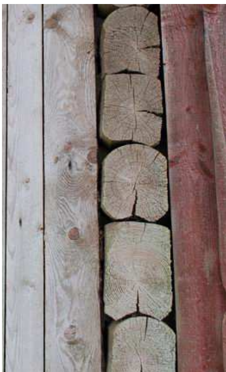
Joonis 4: Nurk D seinte ühenduskoht
