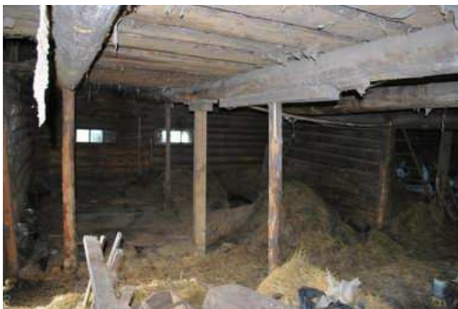
Joonis 3: Toetatud põiktalad laudaosas
