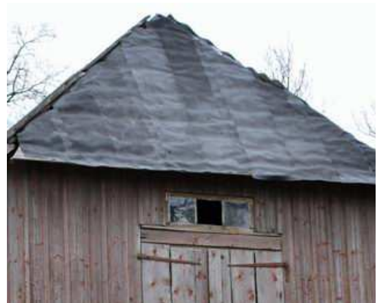
Joonis 2: Tõrvapapiga kaetud laudapoolne kelbaosa
