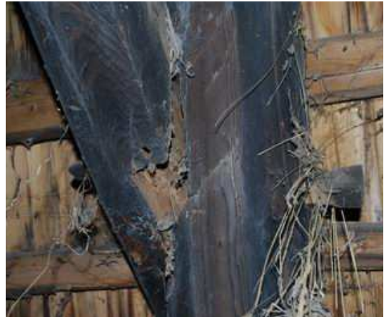
Joonis 4: Sarika ja pärlini ristumiskoht on ühendatud puitkiiluga
