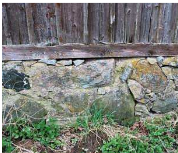
Joonis 6: Hästisäilinud sokli osa küljel CD
