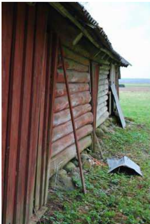
Joonis 1: Väljapoole vajunud sein (külj DA)
