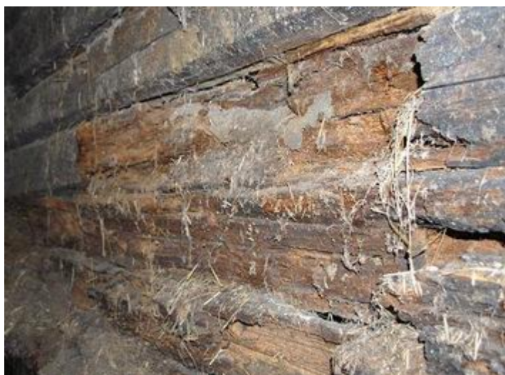
Joonis 5: Landaosa sisekülje kahjustus (külj BC)
