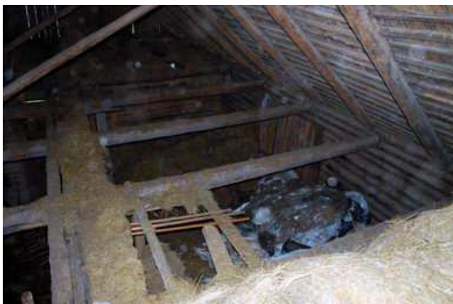
Joonis 1: Vahelaed põiktalad ja pikitala (prahi all)
