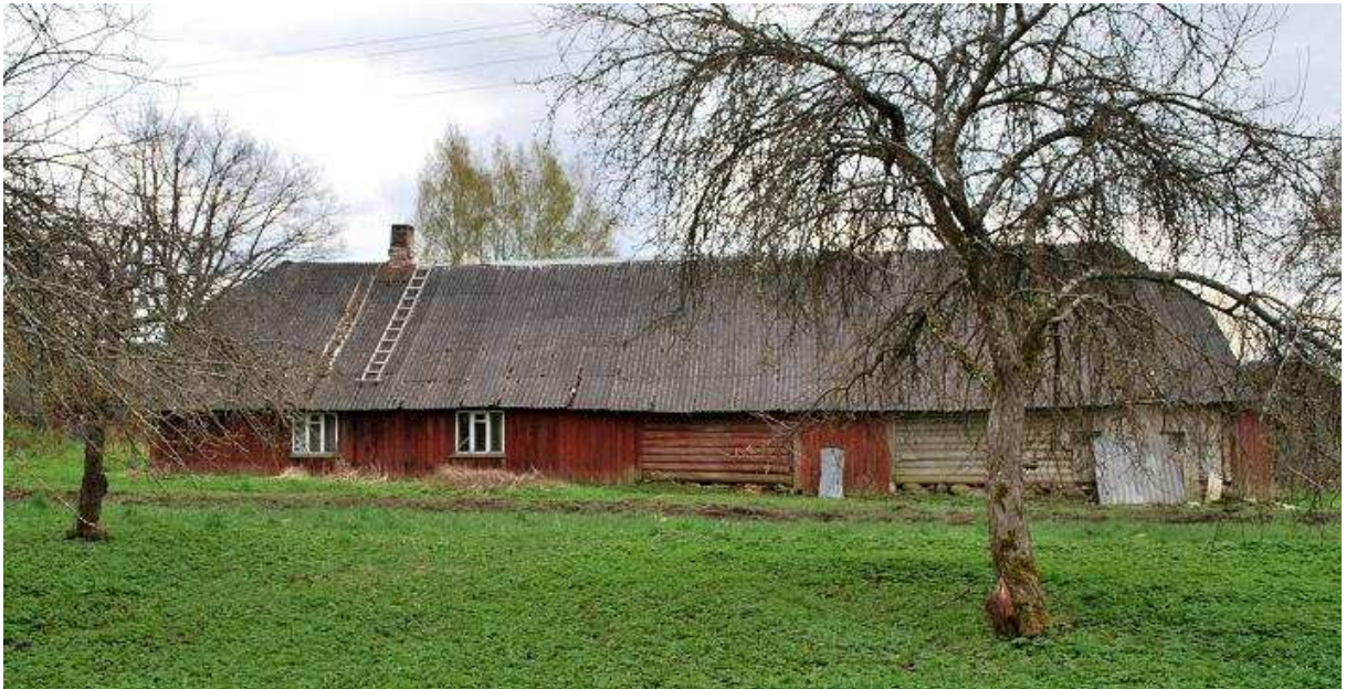
Joonis 2: Vaade tagafassaadile (külg DA)
