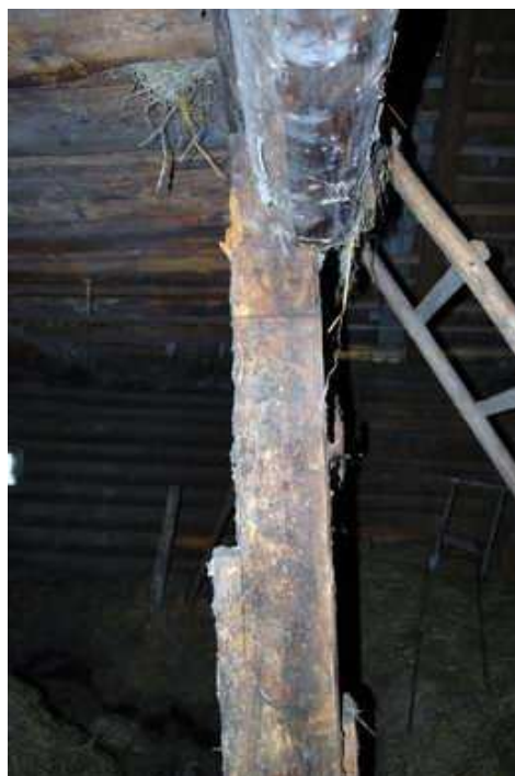
Joonis 2: Väljavajunud uksepost lauda ja reheosa vahel
