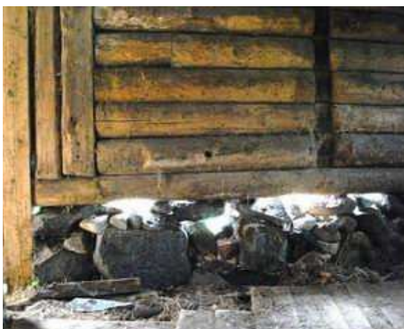
Joonis 5: Sideaineta sokkel laudaosas küljel CD
