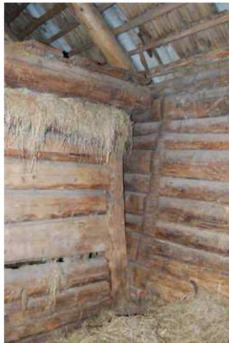
Joonis 5: Tenderpostiga vahesein lauda ja reheosa vahel.
