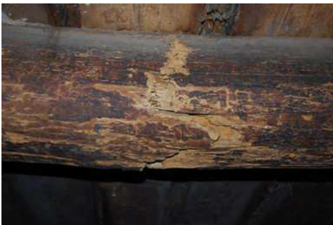
Joonis 4: Murdunud põiktala
