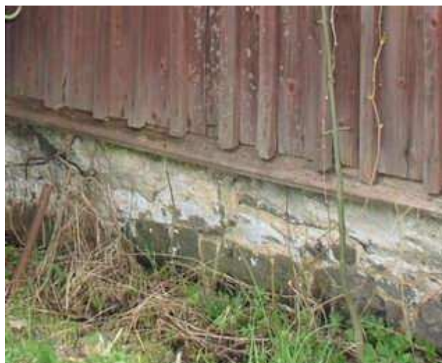
Joonis 4: Hästisäilinud sokkel küljel BC
