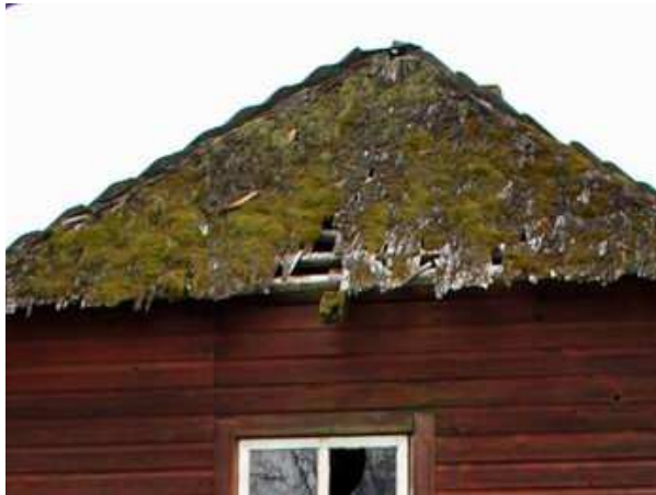
Joonis 1: Külje AB poolne kelbaosa, näha laastkatuse jäänuseid
