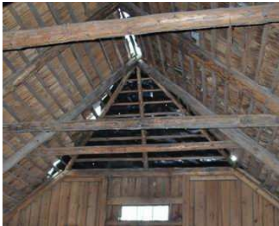
Joonis 3: Vaade kelba konstruktsioonile
