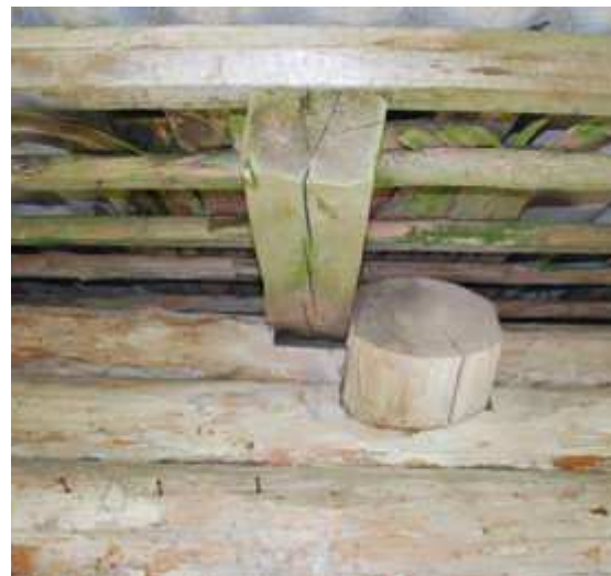
Joonis 6: Õue poolt räästa all näha laetala ots ja sarika ots.
