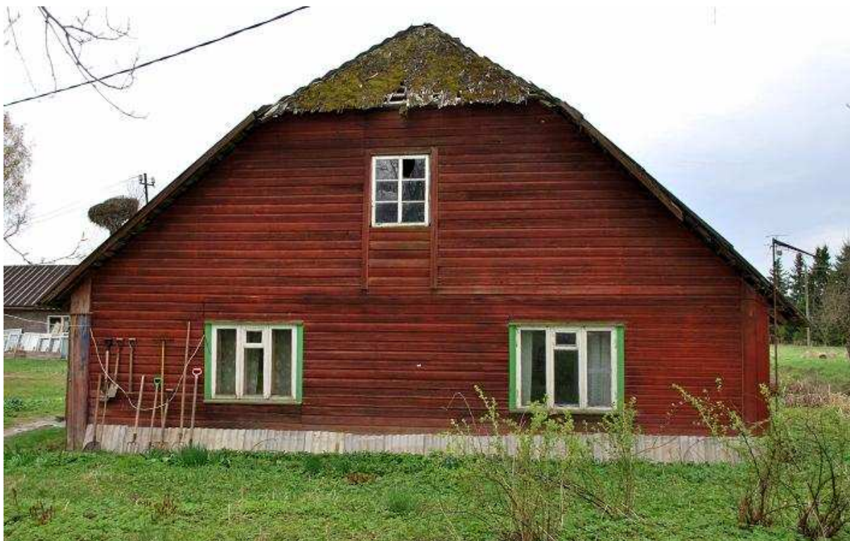
Joonis 3: Vaade kirdefassaadile (külk AB)
