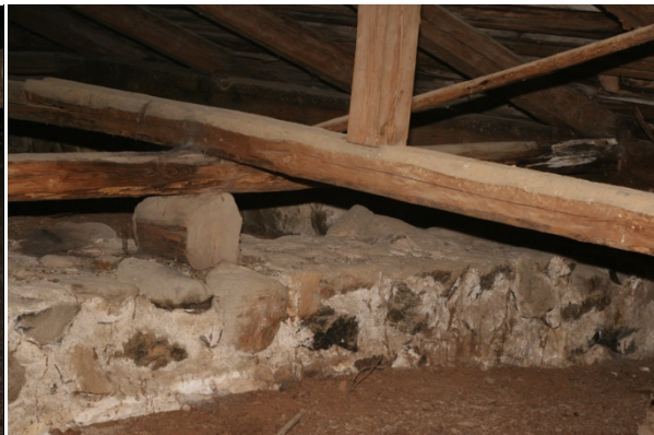
Foto 15 – puittala toetumine vaheseinale
