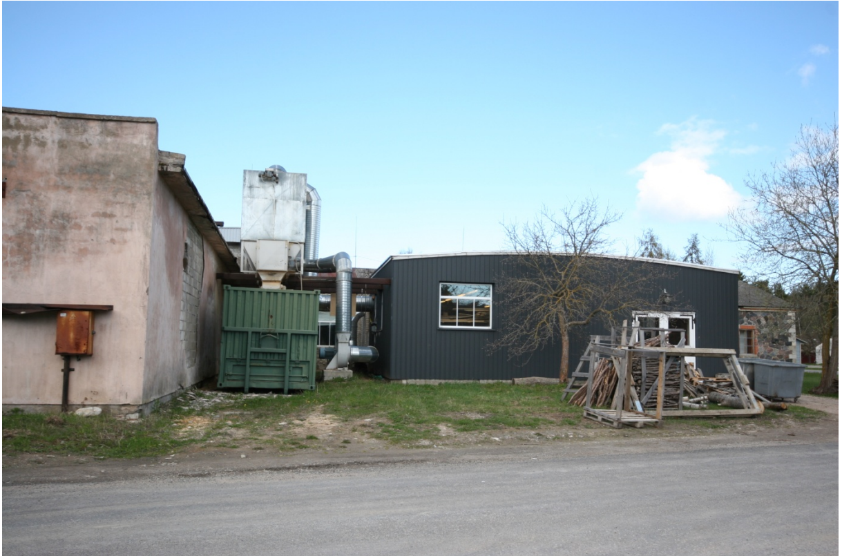
Foto 4 – tagafassaad koos 1960-datel ehitatud juurdeehitusega ning 1960-datel ja 1970-datel aastatel kolmes etapis ehitatud katlamajaga, fotol on ka praegu magasiida ruumides tegutseva OÜ Muhu Puidukoda ventilatsioonisüsteem
