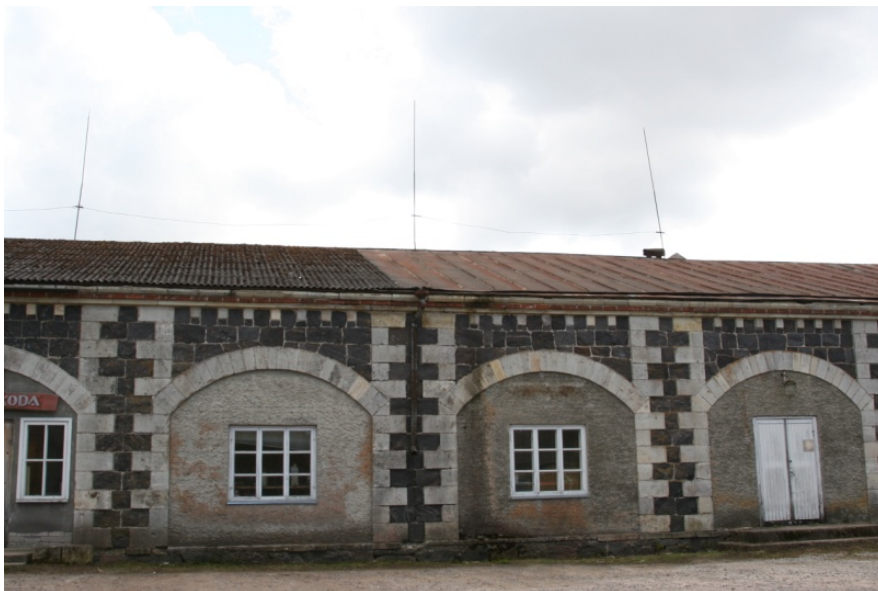
Foto 40 – eterniit- ja valtsplekk-katus
