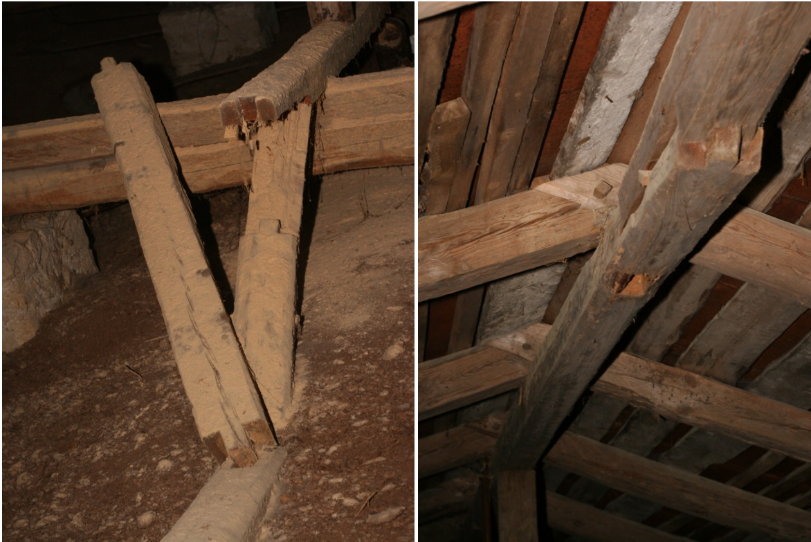
Foto 55 – toolverki murdunud alumine vöö Foto 56 – toolverki posti tapiava ülemises vöös
