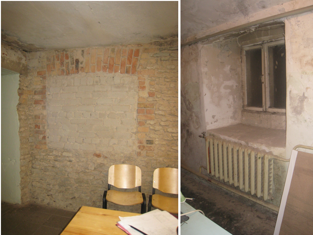
Fotod 38 ja 39. Vasakul kinnimüüritud keldriaken hoone keskosa idaseinas. Paremalt sama keskosa keldriaken läänepoolses välisseinas.
