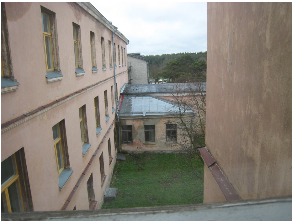
Foto 40. Vaade 3.korruse fassaaditiiva koridori aknast võimlale.
