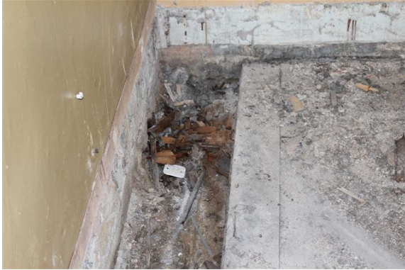
Fotod 17 ja 18. Esimese korruse pinnasele ehitatud põrand peale avamist. Pealtnäha rahuldavas seisus põrandalauade alumised pinnad ja kandetalad on puidumädanikust kahjustatud.
