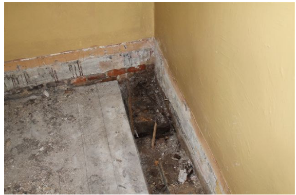
Fotod 17 ja 18. Esimese korruse pinnasele ehitatud põrand peale avamist. Pealtnäha rahuldavas seisus põrandalauade alumised pinnad ja kandetalad on puidumädanikust kahjustatud.
