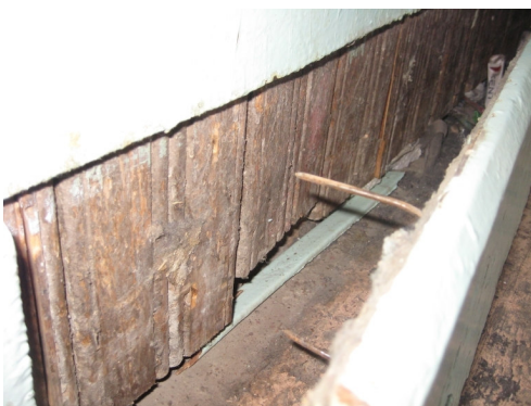
Foto 28 ja 29. Vasakul: võttes lahti võimla seina vineertahvelduse, tuleb alt välja algne profileeritud püstlaudis. Paremalt: 1.korruse söökla otsaseinas peale krohvi eemaldamist välja tulnud kaaravade tellismüüritise serv. Läbi ukse on näha söökla laetalade terasest toeraam.
