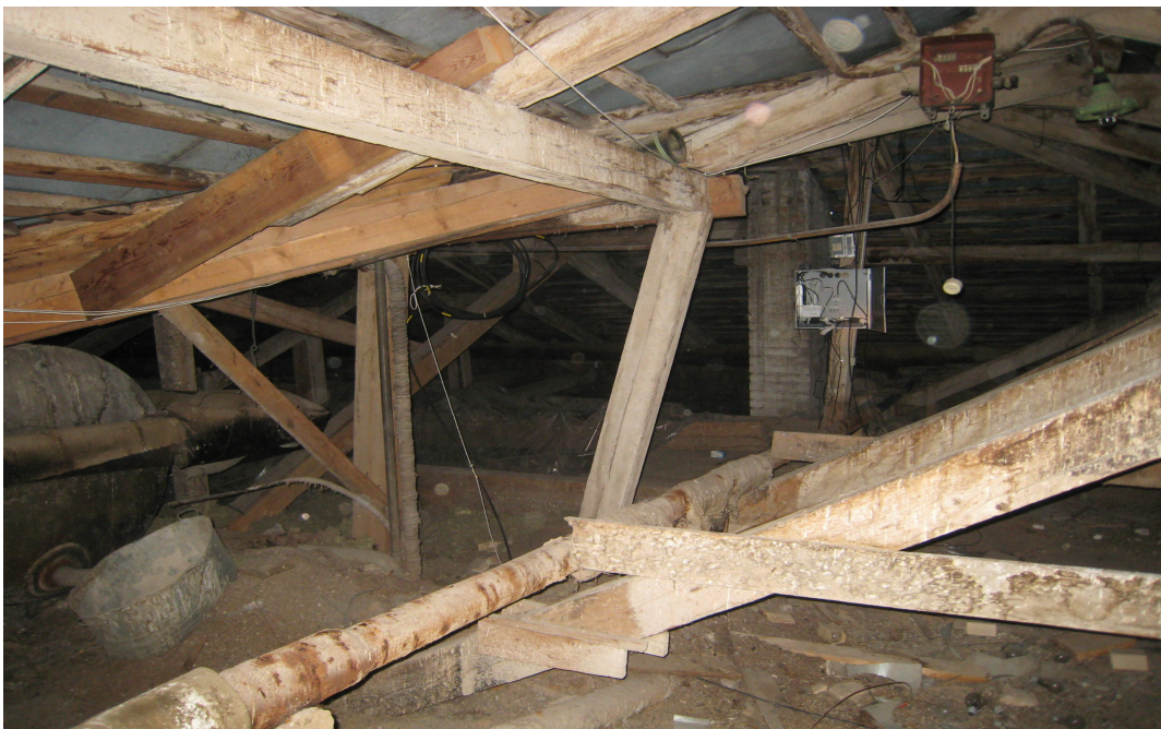
Foto 32. Vaade hoone keskosa tagatiivaga ühendavale neelukohale. Näha on pööningu mitterahuldav heakord ja kuidagimoodi lapitud sarikad.
