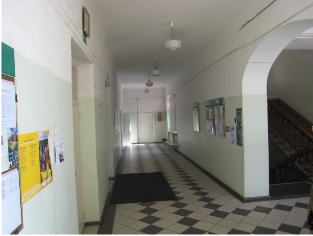
Fotod 20 ja 21. Vasakul oleamasolev koridori pörand fassaaditiiva 1.korrusel, paremal vaade tagumise trepikoja trepile 1.korruse koridori suunas. Trepi astmete esiosad on kulunud ja kohati murdunud. Koridorid ja trepiastmed on kaetud epovaigust kihiga.
