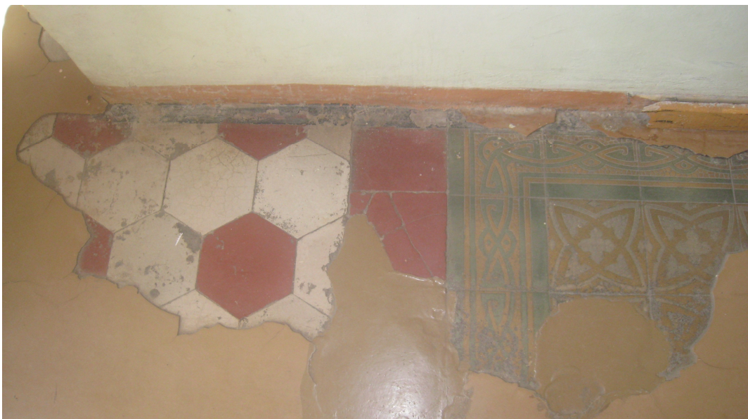
Foto 19. 2.korruse trepikoja põrand. Algne plaadistus on kaetud nüüdseks juba kulunud epovaigust kattega.
