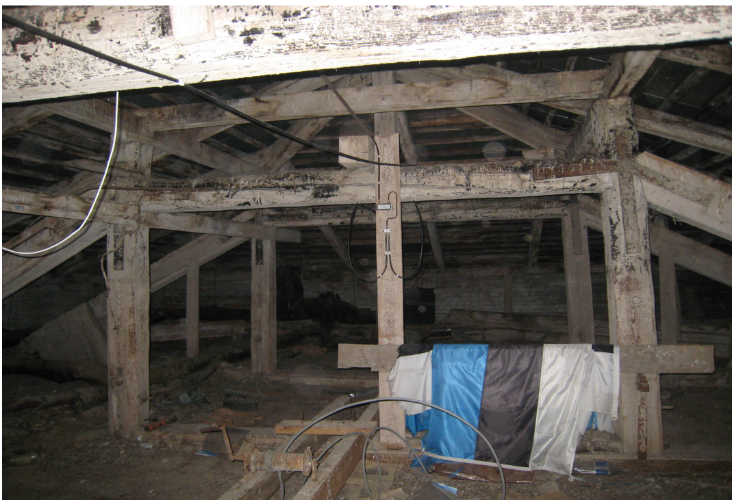
Foto 33. Aulapealne pööning. Vaade katust kandvatele turvikutele.
