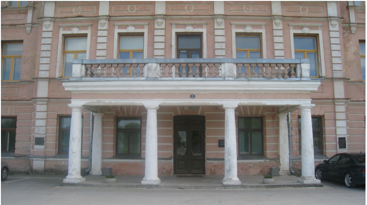
Foto 35. Rakvere ametikooli peasissepääs aastal 2010. Hoonele iseloomulik avatäidete mitmekesisus. Algetena on säilinud peauks, rõduposti kõrval olev aken ja rõdu välisuks. 2.korrusel on kollaste raamidega uued pakettaknad.
