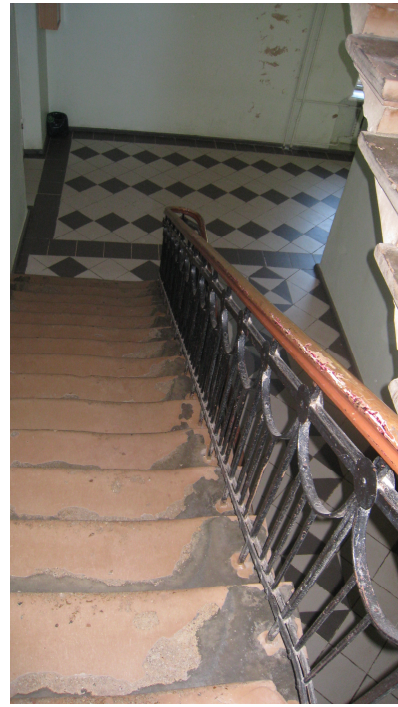
Fotod 20 ja 21. Vasakul oleamasolev koridori pörand fassaaditiiva 1.korrusel, paremal vaade tagumise trepikoja trepile 1.korruse koridori suunas. Trepi astmete esiosad on kulunud ja kohati murdunud. Koridorid ja trepiastmed on kaetud epovaigust kihiga.
