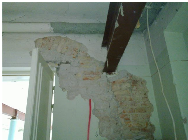
Foto 28 ja 29. Vasakul: võttes lahti võimla seina vineertahvelduse, tuleb alt välja algne profileeritud püstlaudis. Paremalt: 1.korruse söökla otsaseinas peale krohvi eemaldamist välja tulnud kaaravade tellismüüritise serv. Läbi ukse on näha söökla laetalade terasest toeraam.
