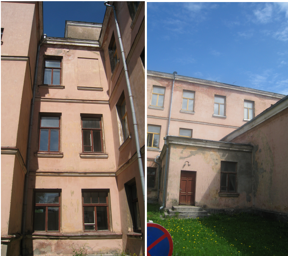
Fotod 14 ja 15. Vaade läänepoolsest sisehoovist fassaaditiiva ja keskosa ühendusnurgale ja võimla kõrvalehitisele.
