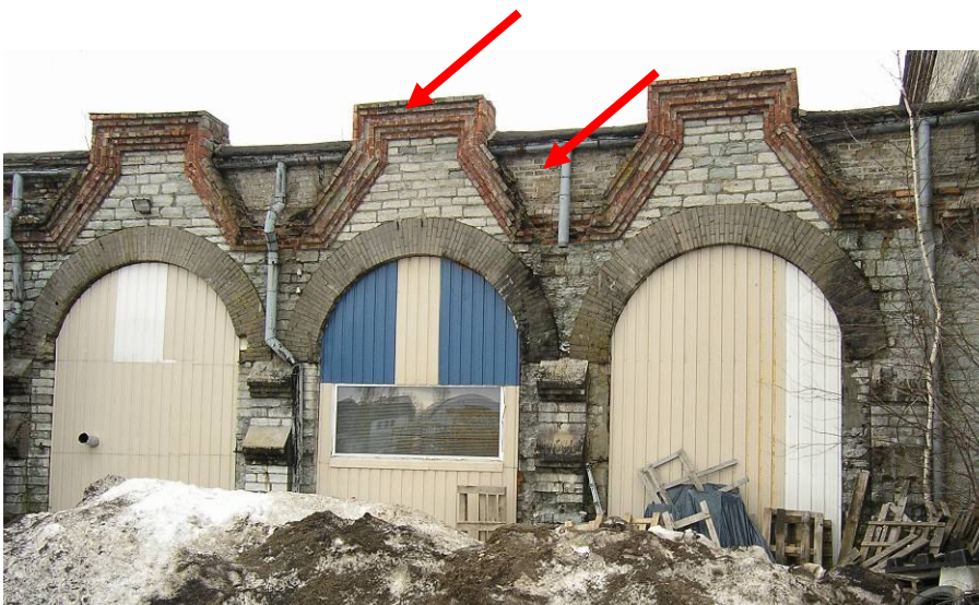
Foto 32: I sektsiooni savitellistest karniis ja tõstetud räästas
