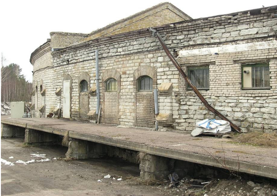
Foto 23: Depookorpuse II ja III seksiooni üleminek tagafassaadis
