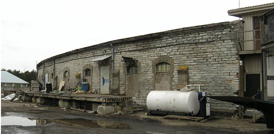
Foto 22: Depookorpuse III ja IV seksioon tagafassaadis
