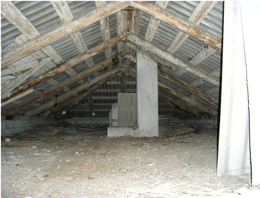
Foto 34: Administratiivkorpuse katusekonstruktsioonid ja algupärane korstnajak
