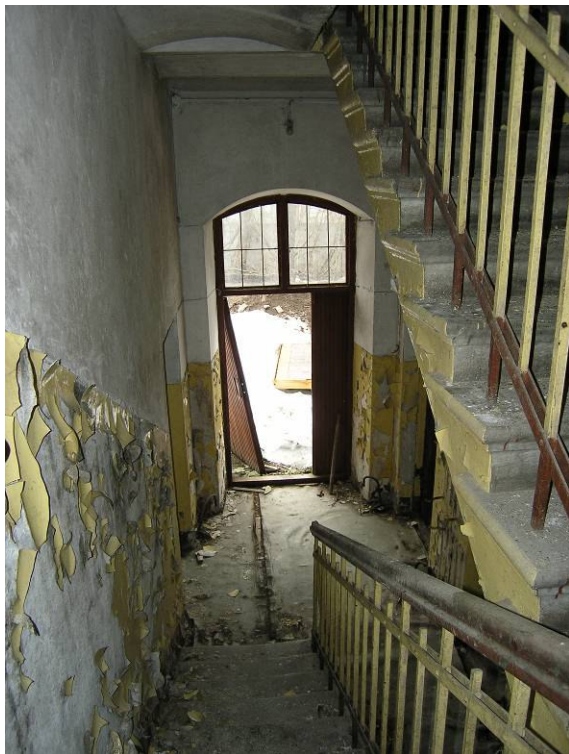
Foto 16: Aministratiivkorpuse metallpiirde ja puitkäsipuuga kivitrepp
