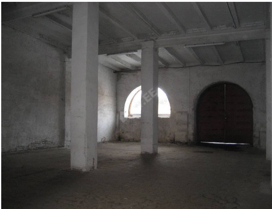
Foto 27: III ja IV seksiooni interjäär (katuse kandjateks on raudbetoonpostid ja -talad)
