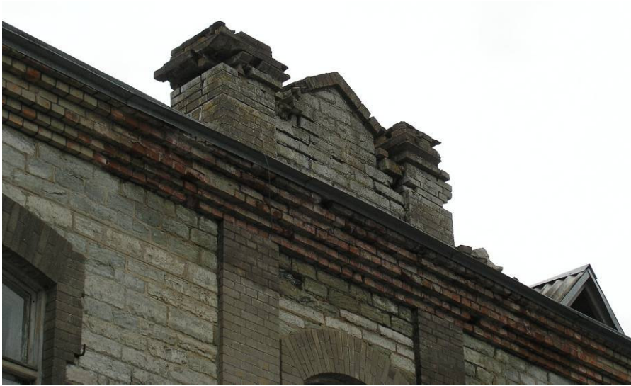
Foto 31: Administratiivkorpuse sissepääsu kohal olev frontoon ja karniis
