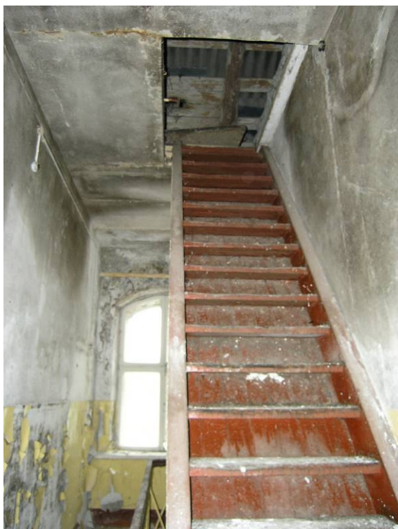
Foto 17: Aministratiivkorpuse pööningule viiv puittrepp
