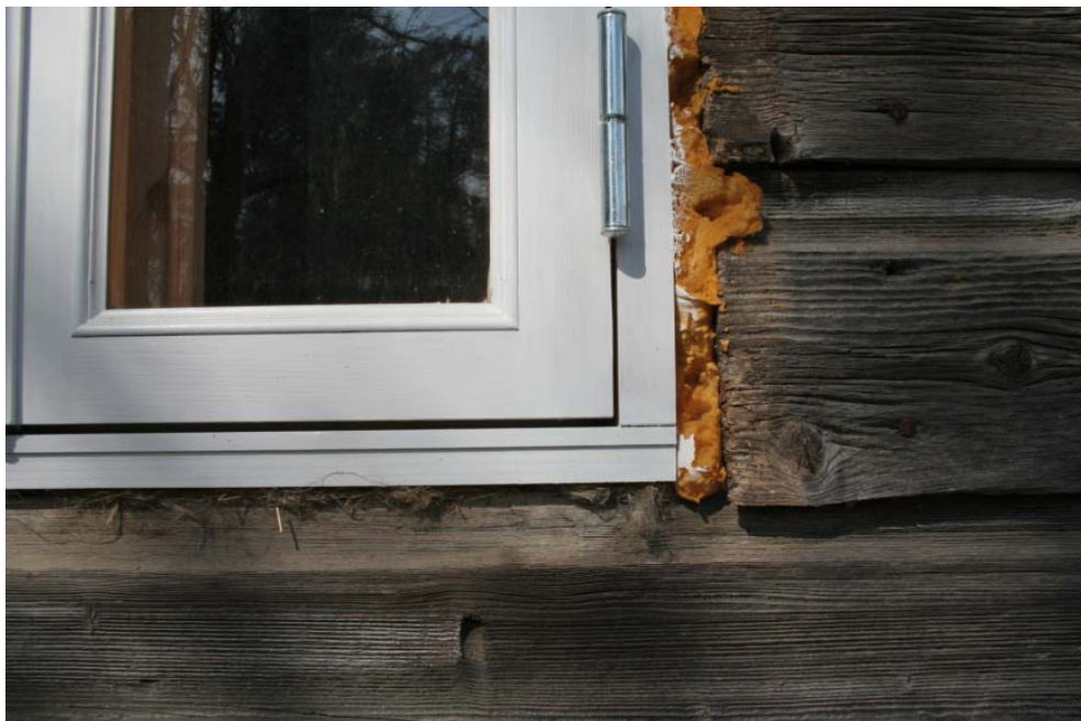
Foto 36. Akna paigaldamine poliüuretaanvahuga
