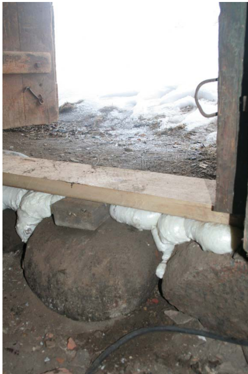
Foto 24. Sula- ja vihmavee sissevalgumast tõkestamine
