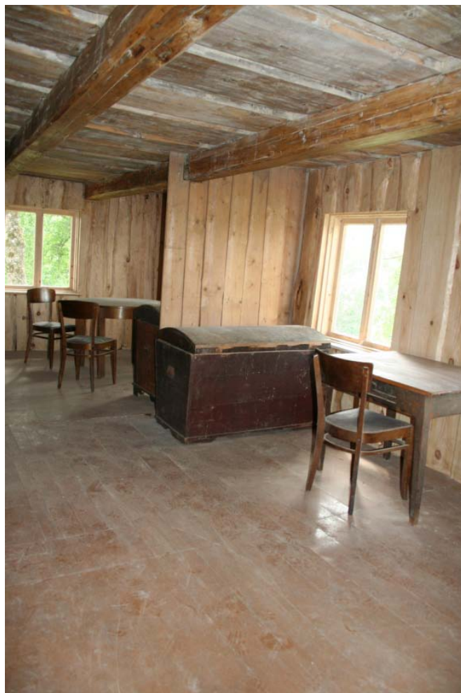
Foto 27. Palkseinad on kaetud servamata laudadega
