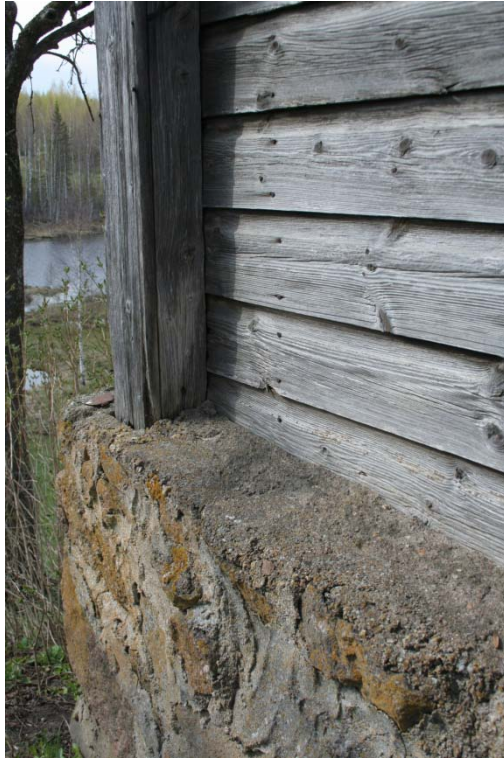
Foto 23. Seinast eenduv sokkel
