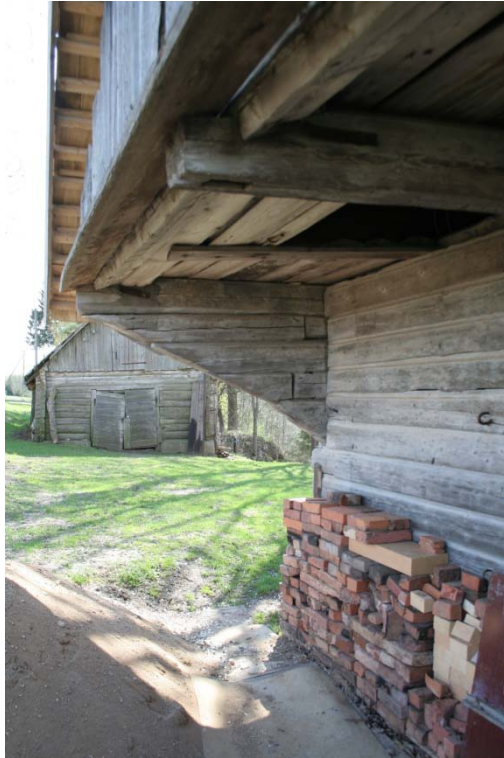
Foto 29. Varjualust toetav kolmnurkne kandnurk ja seinast üleulatuv laetala
