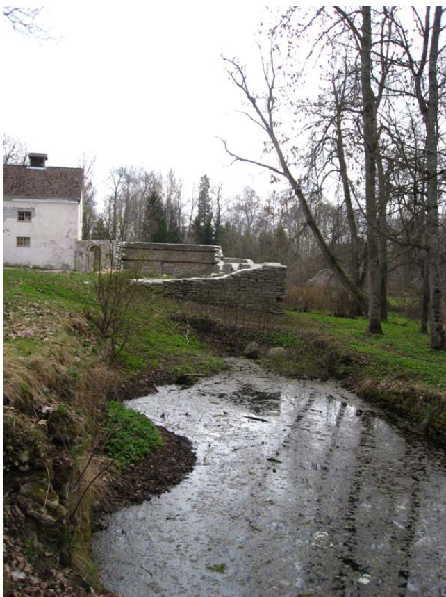
Foto 35. Kinnikasvanud ja laiali vajunud tõllapesukanalisse sissesõit. Autori foto 2011
