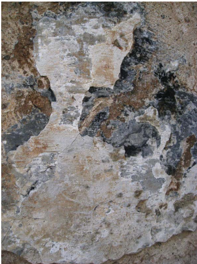
Foto 17. Arkaadidelt pudenenud värvikihi alt paistis musta värvi kiht, mis meenutas tõrvamist või mastiksvärvi. Autori foto 2011
