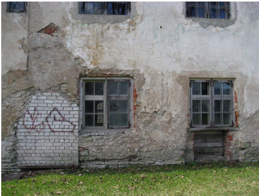
Foto 9. Silikaattellisega teostatud seinamüürimine ja laudisega kinni ehitatud ava. Sellised olukorrad vajavad asendamist sobilike materjalide ja lahendustega. Autori foto 2011
