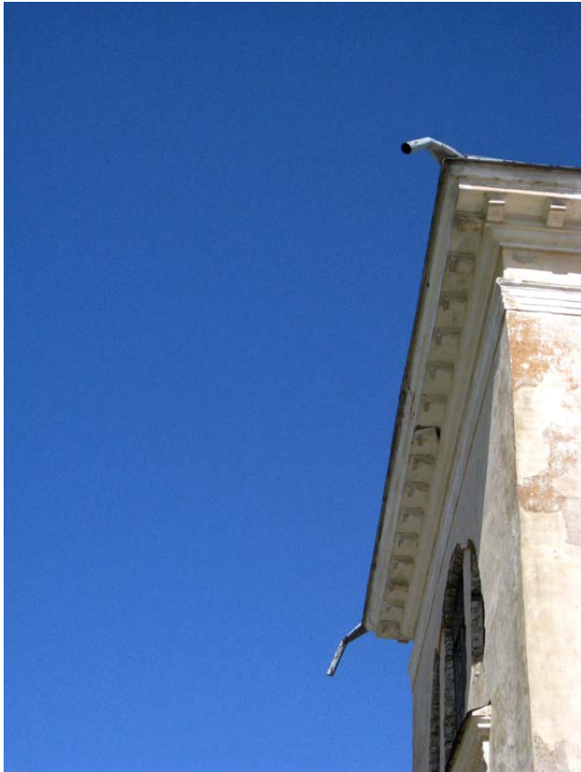
Foto 28. Külgrisaliitidele paigaldatud veesülitid. Piki katust jooksvad veelauad jäävad siin varju. Autori foto 2011
