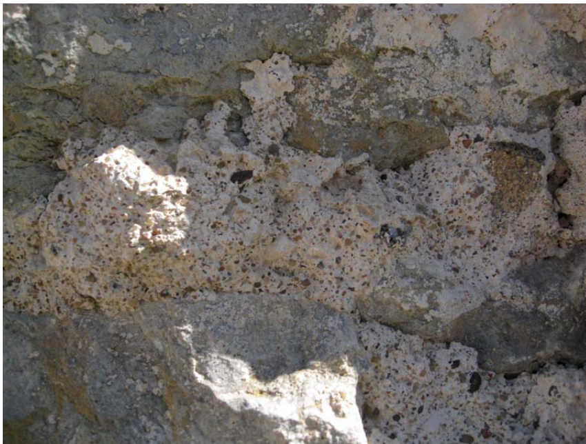
Foto 11. Irdunud krohvi alt ja pækivide vahelt paistev lubimört, mille sees paistavad suurefraktsioonilised liivaterad sideainena. Autori foto 2011
