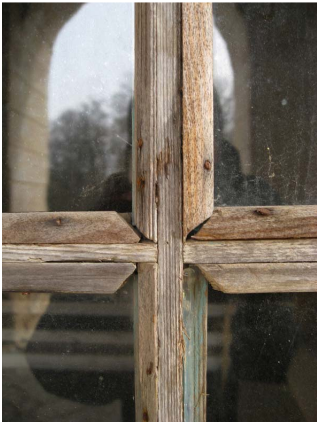
Foto 24. Pajljud akendeliistud ei ulatu omavahel kokku. Puit on kas nii palju kokku kuivanud või on tegemist viletsa tööga. Autori foto 2011
