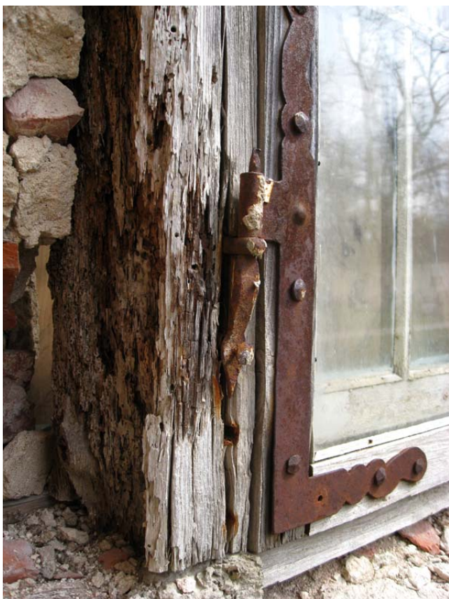
Foto 25. Mädanenud aknaleng, millel on ka puidukahjurite jälgi näha. Autori foto 2011
