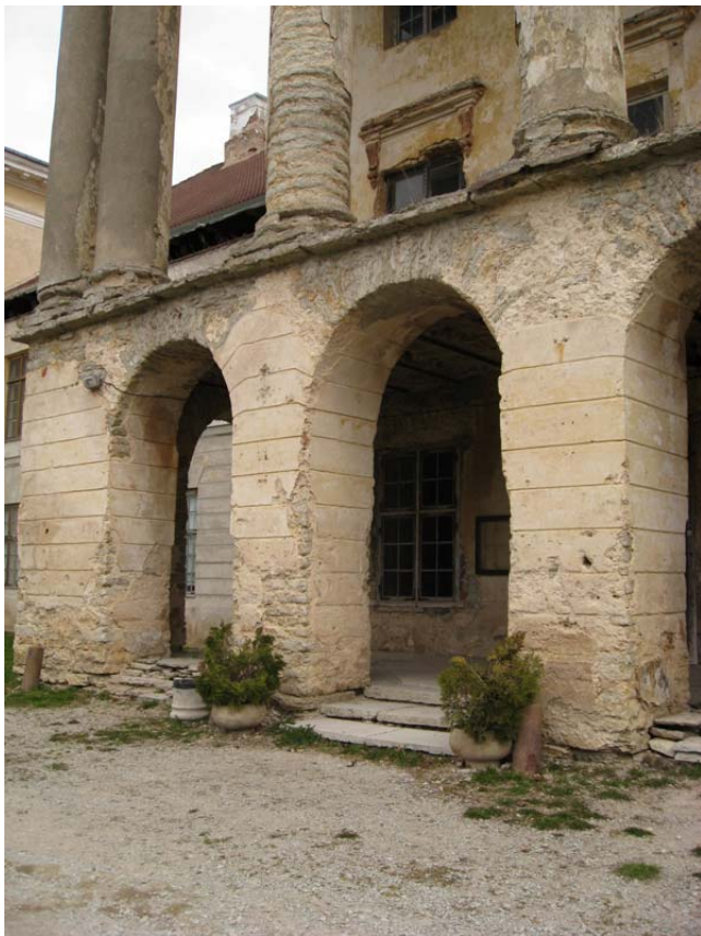
Foto 12. Tsemendiseguga tugevdatud arkaadide võlvid. Fotel on näha ka sammaste lagununud baasid. Autori foto 2011
