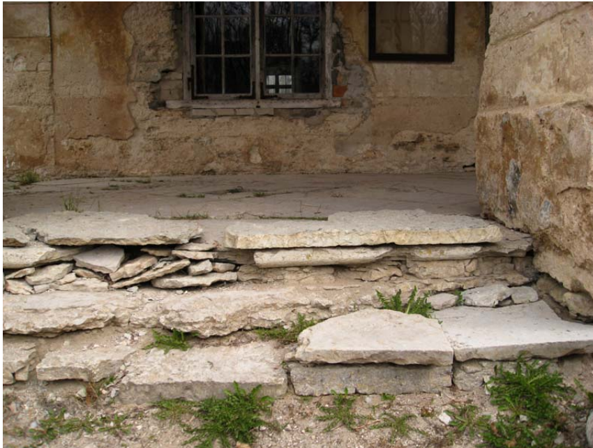
Foto 15. Kunagistest ümara ninaga trepiastmetest on järel ainult mõned fragmendid. Trepiastmeid on püütud käepärase paematerjaliga kohendada. Autori foto 2011
