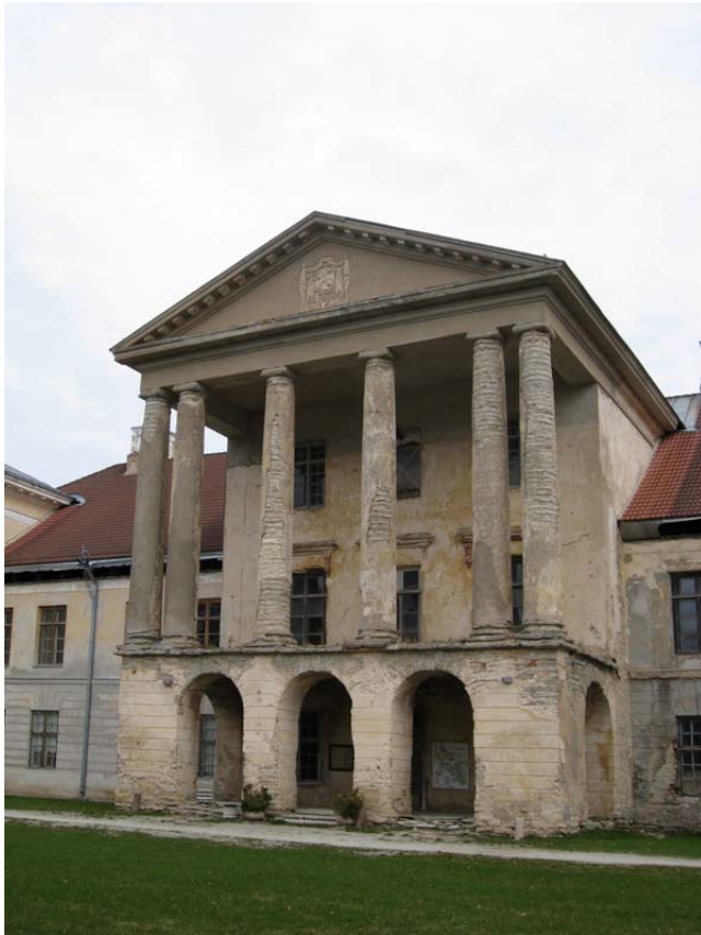
Foto 14. Joonia sammastelt on krohv maha langenud. Kahel vasakpoolsel on näha tsementkrohvi. Sammaste kapiteelid on hävinud. Renoveeritud kolmnurkfrontoon koos suguvõsa vapiga. Autori foto 2011
