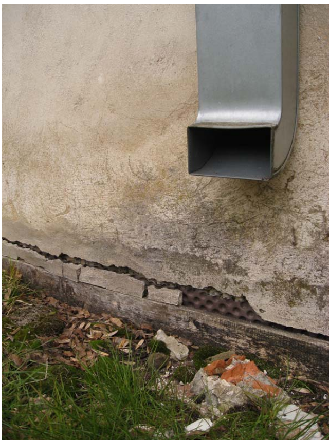
Foto 2. Seinast pudenev renoveerimise käigus lisatud tsementkrohv. Krohvi alt paistmas mummukile, mida hoone muudes osades ei esine. Autori foto 2011
