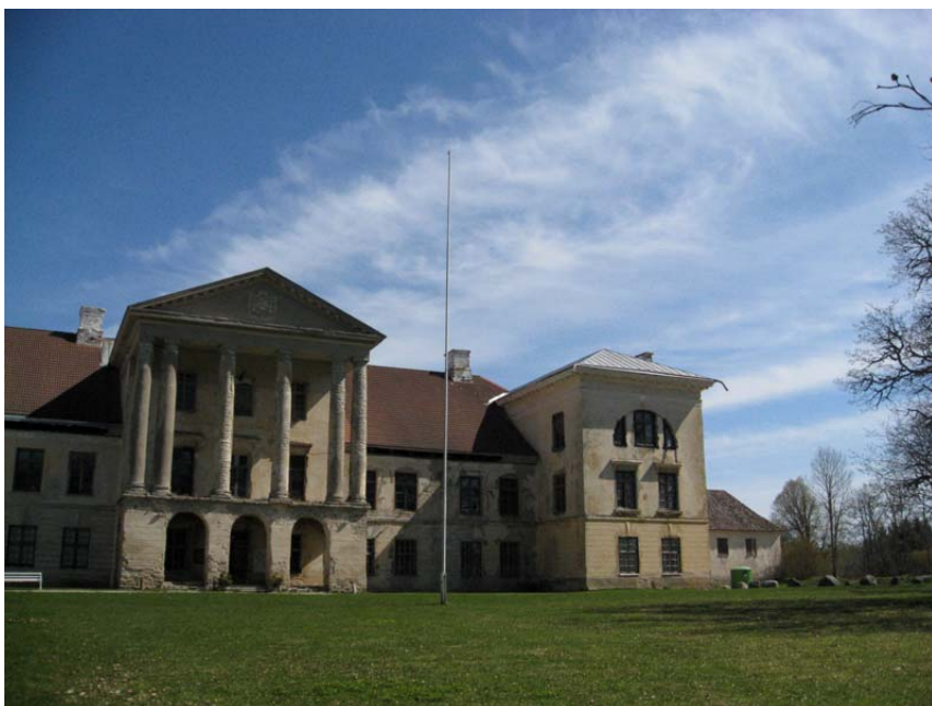
Foto 4. Tsementkrohvi parandustest ja renoveerimisest hallikirju fassaad. Autori foto 2011
