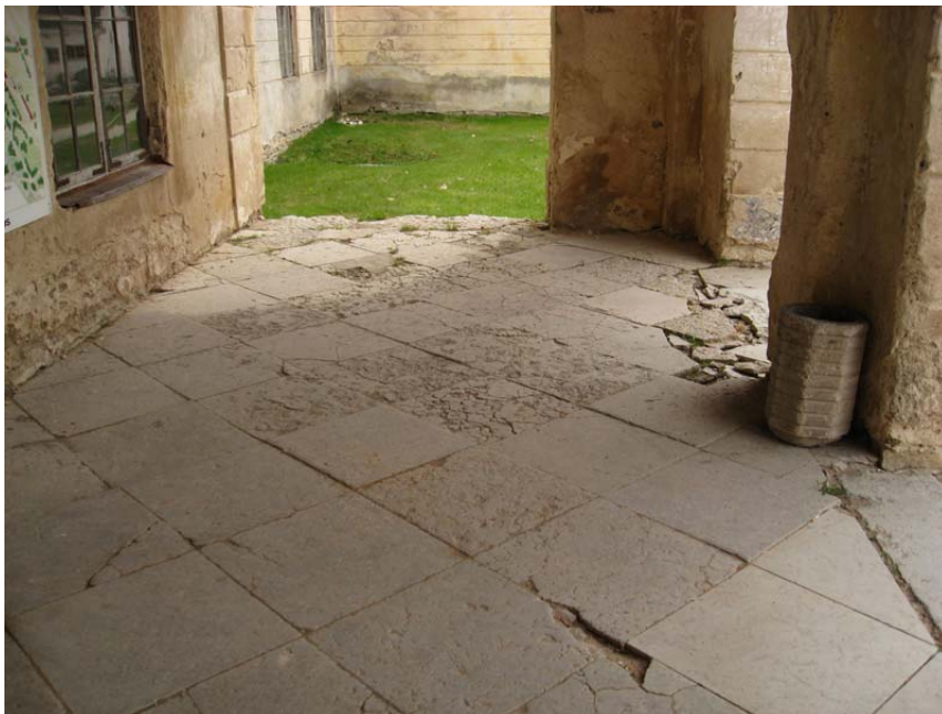
Foto 16. Peaukse esine ja portikuse alune paekiviplaatidest põrand. Mõned täiesti purunenud plaadid vajavad väljavahetamist. Autori foto 2011
