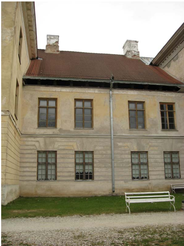
Foto 7. Räästakarniiside asemel laiutav õhuvähe. Autori foto 2011
