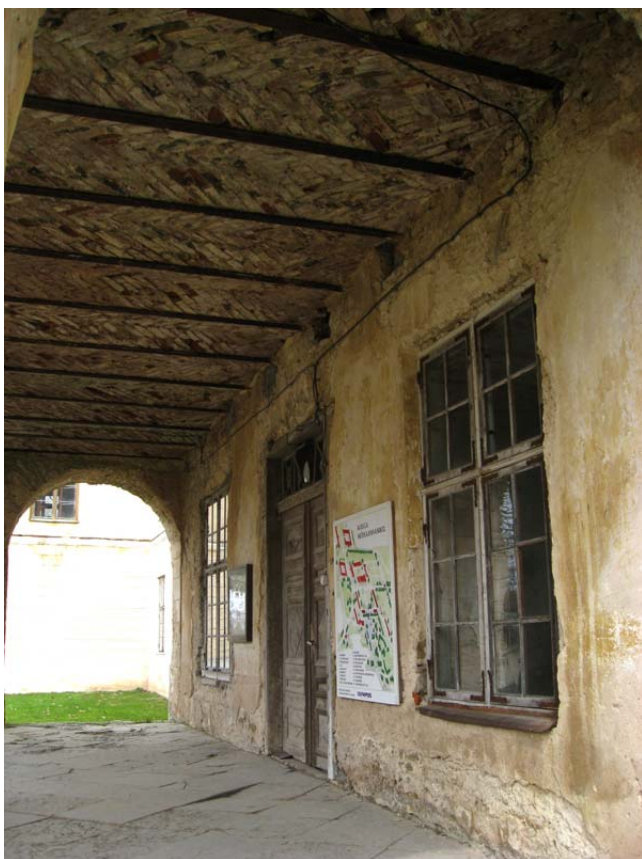
Foto 13. Mõisa peakuse esine. Roostetavatele raudtaladele toetuv arkaadide ja portikuse vahelagi. Lauged võlvid on laotud punasest tellisest. Autori foto 2011
