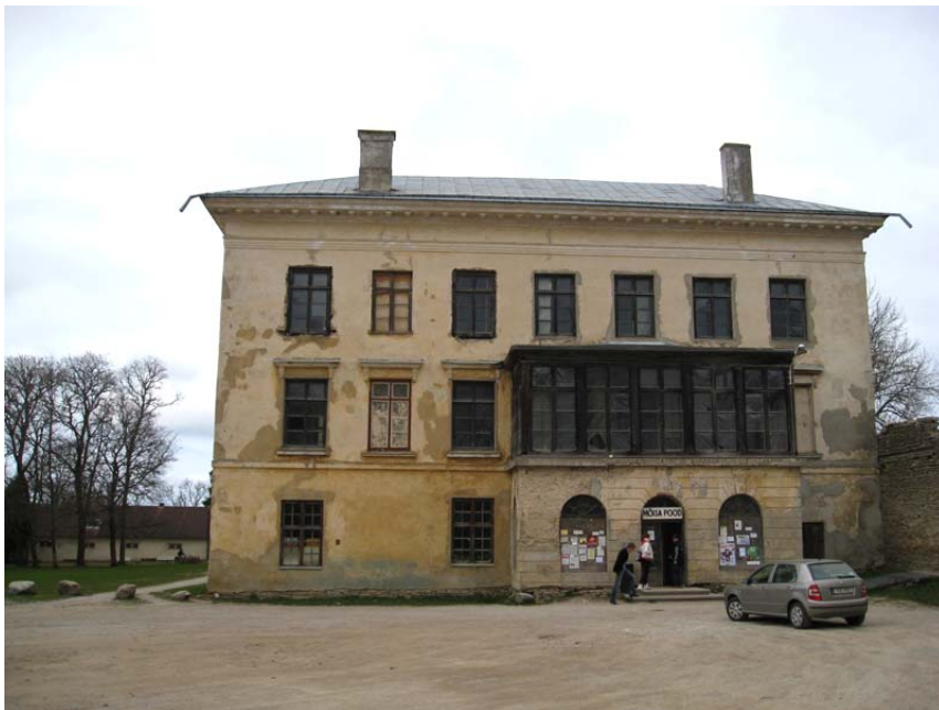
Foto 27. Lõunapoolsest küljest enduv talveaed ja mõisapoe sissepääs. Talveaia kiletatud aknad vajaksid klaase ja plakateid täiskleepitud vineerid tuleks aknaavadest eemaldada ning aknad renoveerida. Autori foto 2011
