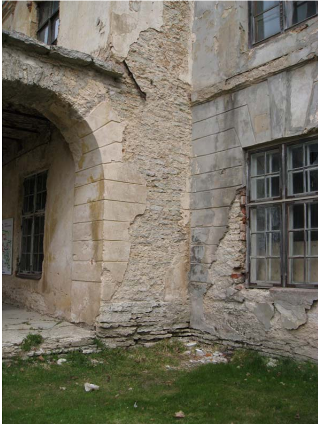
Foto 1. Seintelt ja soklilt mahalangenud lubikrohv. Paekivi sideaine on samuti hakanud murenema. Autori foto 2011
