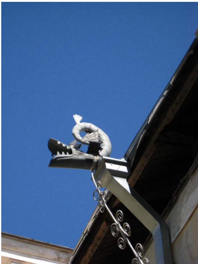
Foto 29. 19. sajandi esimesest poolest säilinud lohe meenutav veesülititi ja uuemal ajal paigaldatud vihmaveetoru. Autori foto 2011
