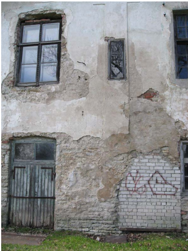
Foto 22. Peahoone tagumisel küljel olev sissepääs, mis on asendatud vertikaallaudisest uksega ning suletud raudlatiga. Kuulub väljavahetamisele. Autori foto 2011
