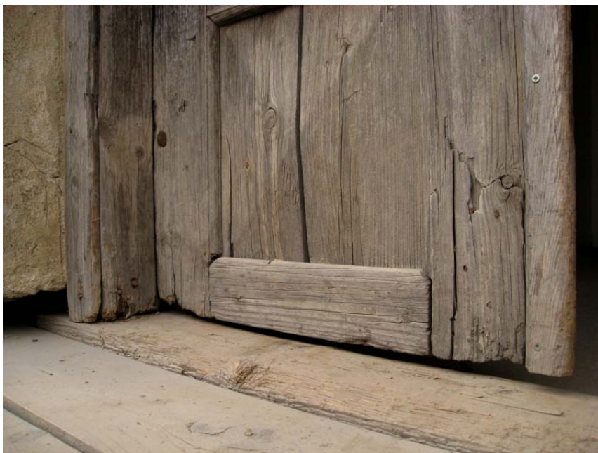
Foto 19. Lõunapoolsel küljel asuva mõisapoe uks. Uks on alumisest äärest pehkinud ja lävepakk kulunud. Autori foto 2011
