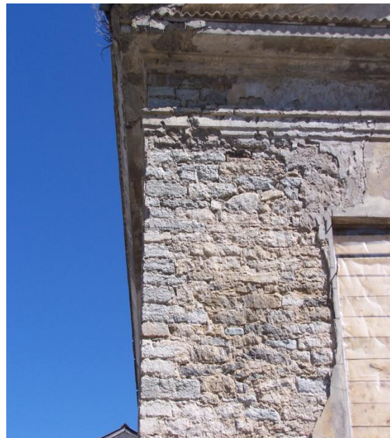
Joonis 4. Krohvi alt paljandunud müüritis
