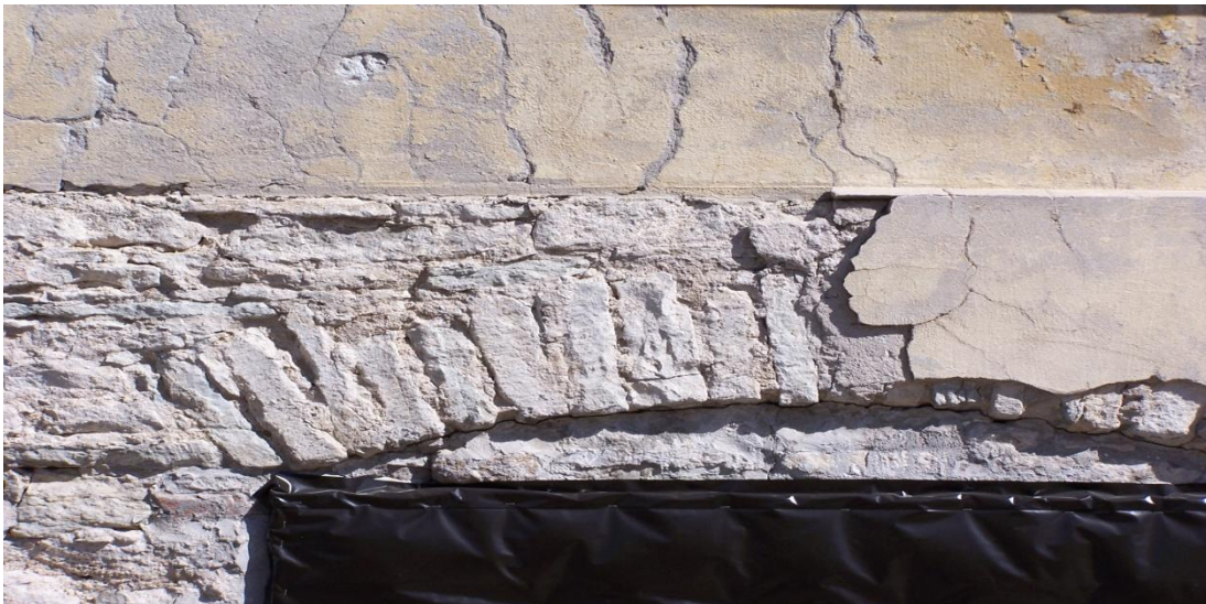
Joonis 5. Võlvitud aknasillus ja täitekivid toetumas lengile
