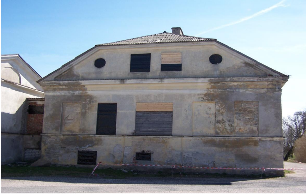
Joonis 10. Kinni müüritud ukseava lõunapoolses otsasoklis
