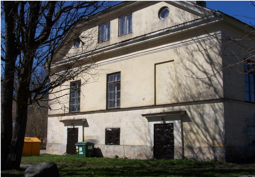
Joonis 9. Pilastritega ukseavad lõunapoolses sokliseinas
