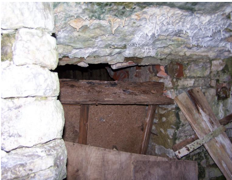
Joonis 8. Tellisvõlvi kerkimine paemüüritiselt
