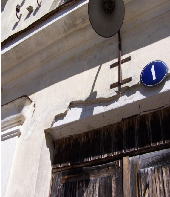
Joonis 19. Silikaltsiitsillus
