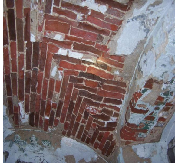
Joonis 7. Varisenud krohvi alt paljanduv lagi
