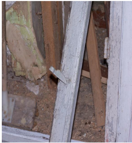
Joonis 23. Kinnitushaak ja raamiprofiil
