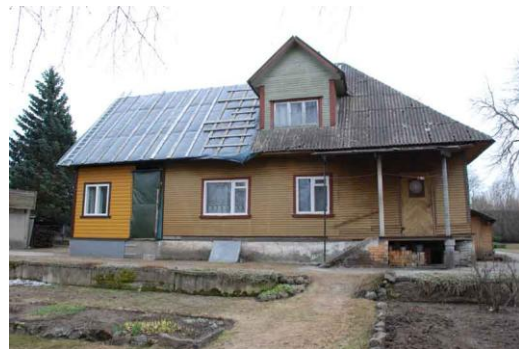
6. Vaade põhjast (hoovi poolt).
