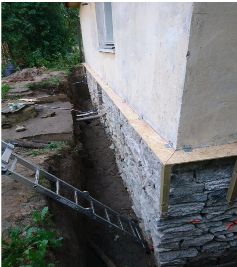
7. Drenaaži paigaldus Põhjapoolsel küljel (2019.a.)
