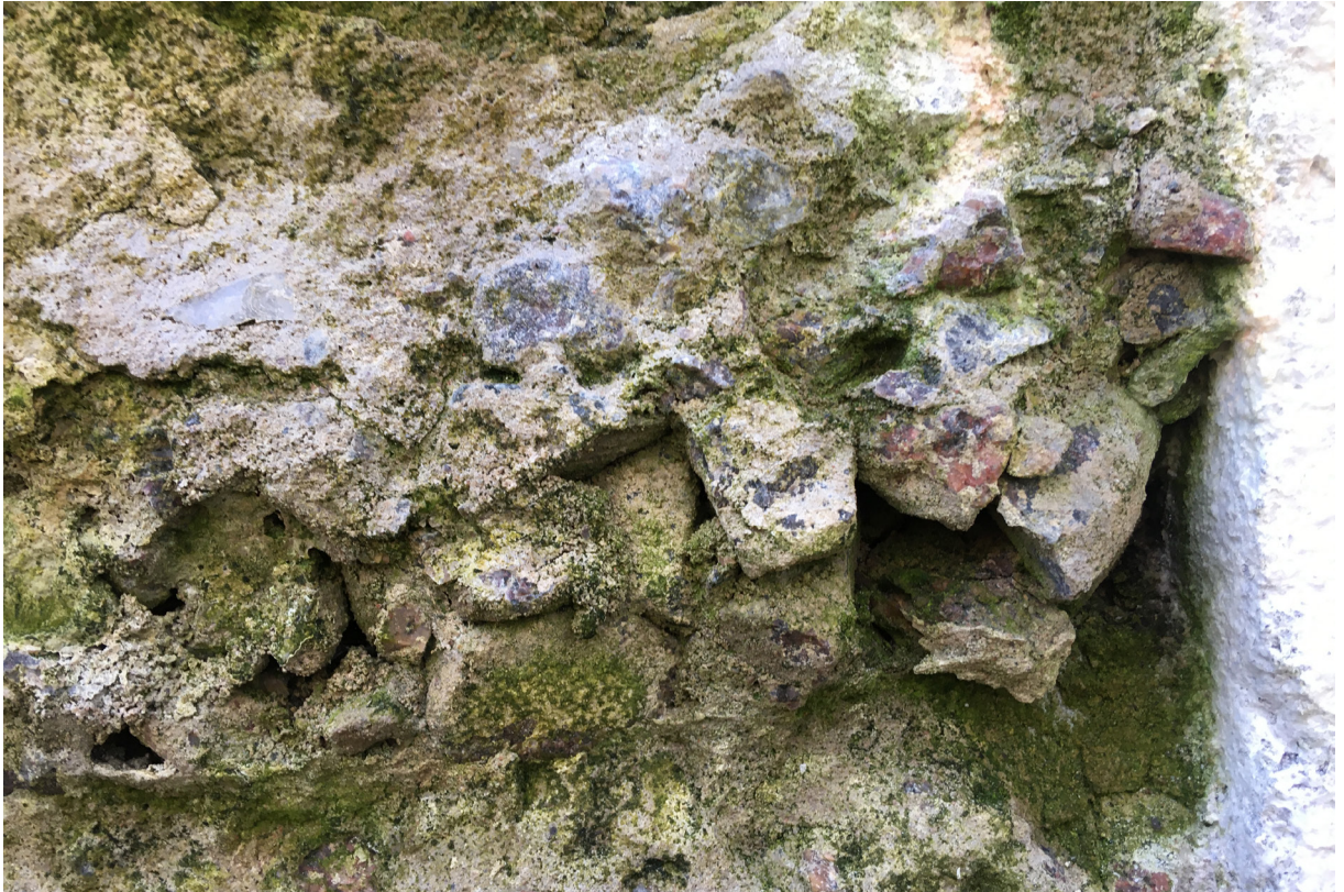
Illustratsioon 11. Betooni täitematerjal on graniitkivitükid
