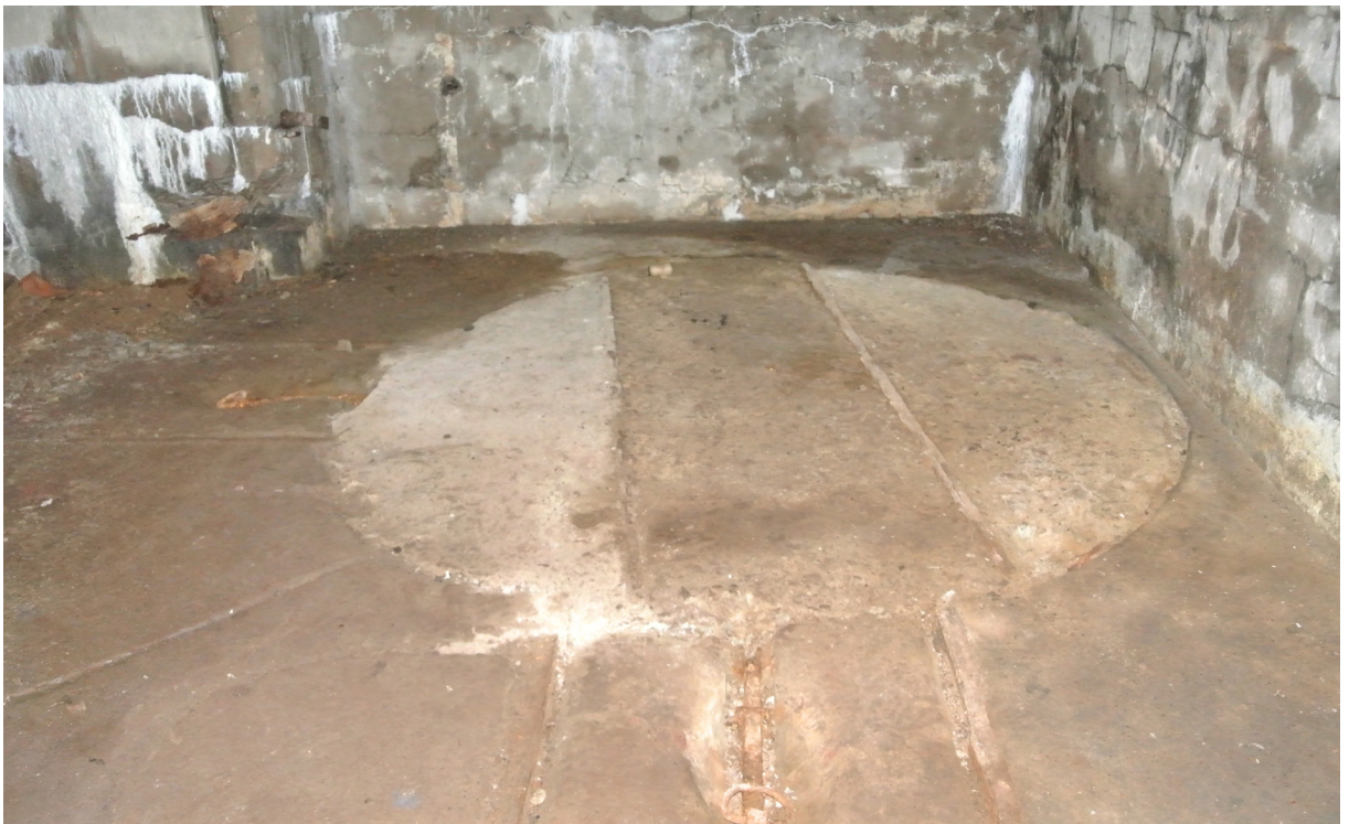
Illustratsioon 20. Pööramisring põrandas
