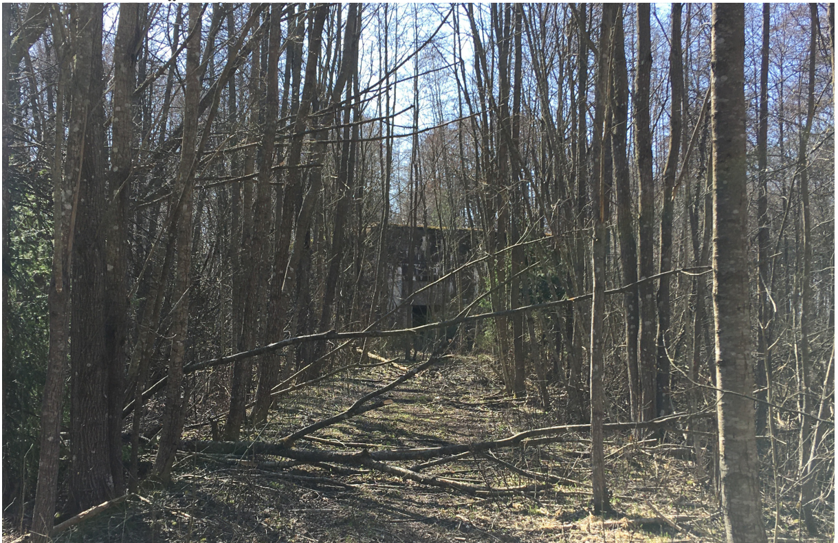
Illustratsioon 14. Vaade varjendile raudteetammilt
