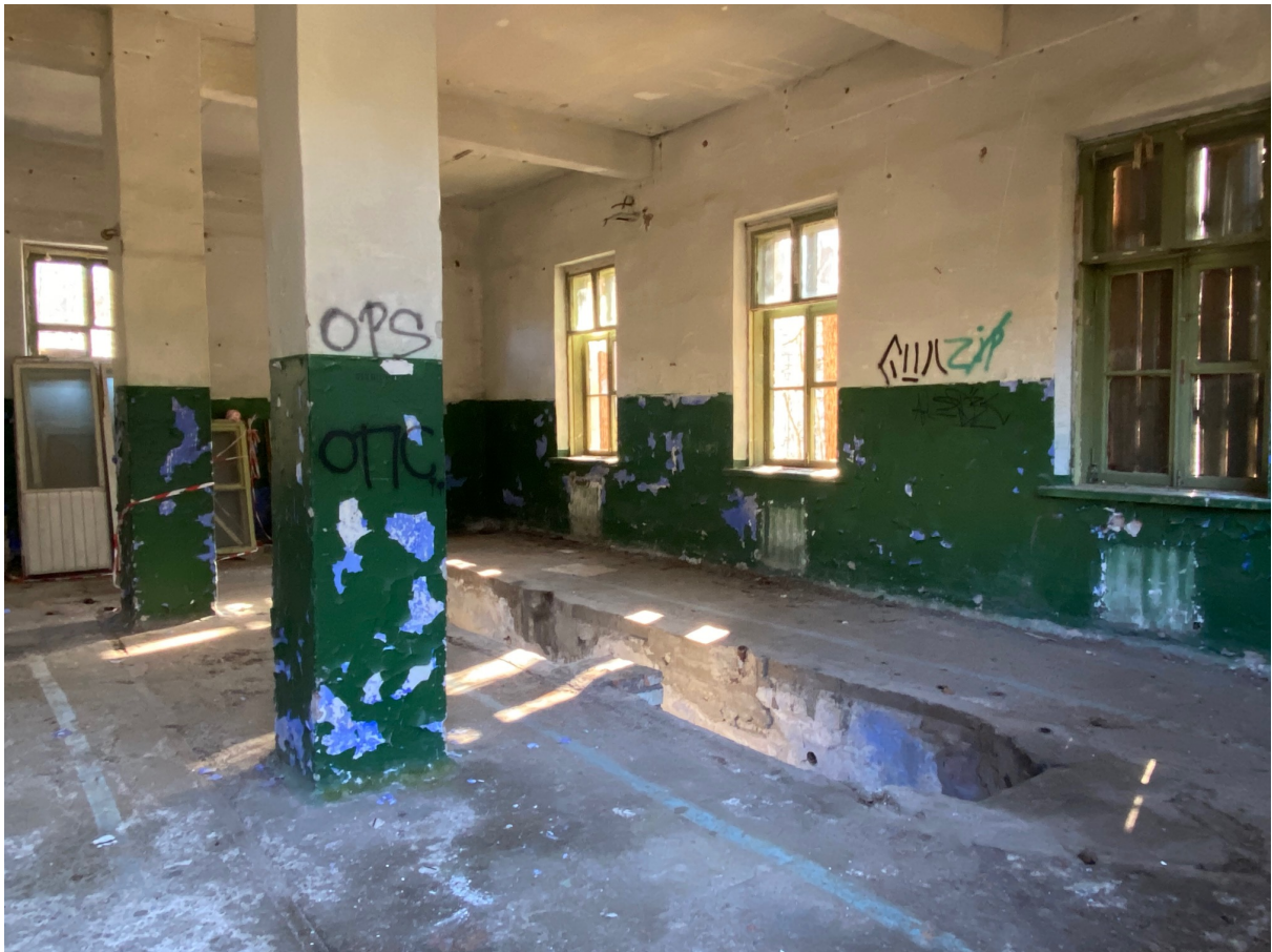
Joonis 54 Tuletõrjedepoo hoone põrandas on kanal autode remontimiseks.
