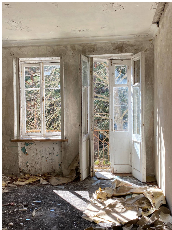
Joonis 40 Samas hoones: lagede lõhutatud kipskarniisid.
