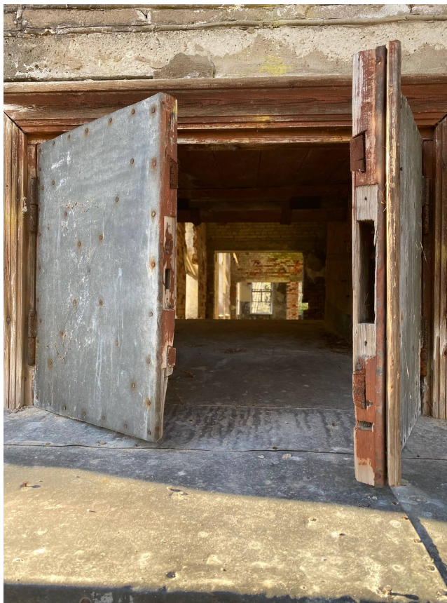
Joonis 109 Ava on luukidega suletav, seestpoolt väljapoole kaldega ja kaetud plekiga, mis viitab millegi väljastamisele. Kuna linnakus oli mitu kauplust, paiknes leiva- ja saiatöökoda ilmselt just siin.
