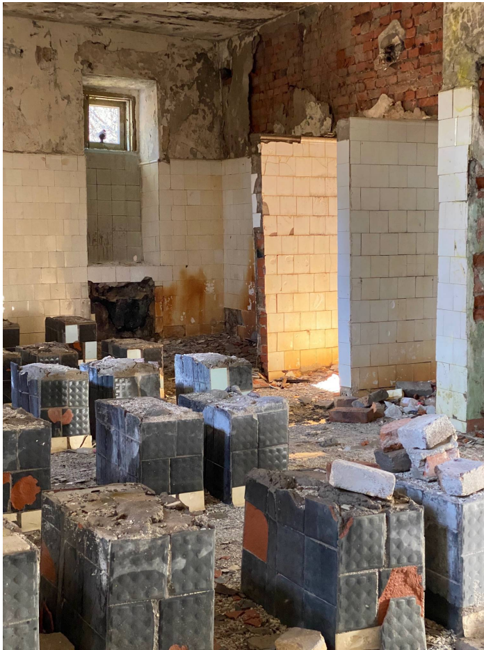
Joonis 61 Sauna pesuruum, milles on alles vaid istepinkide jalad. Istumisosad on kadunud. Pildistamise asukoht ja suund punasega tähistatult plaanil.
