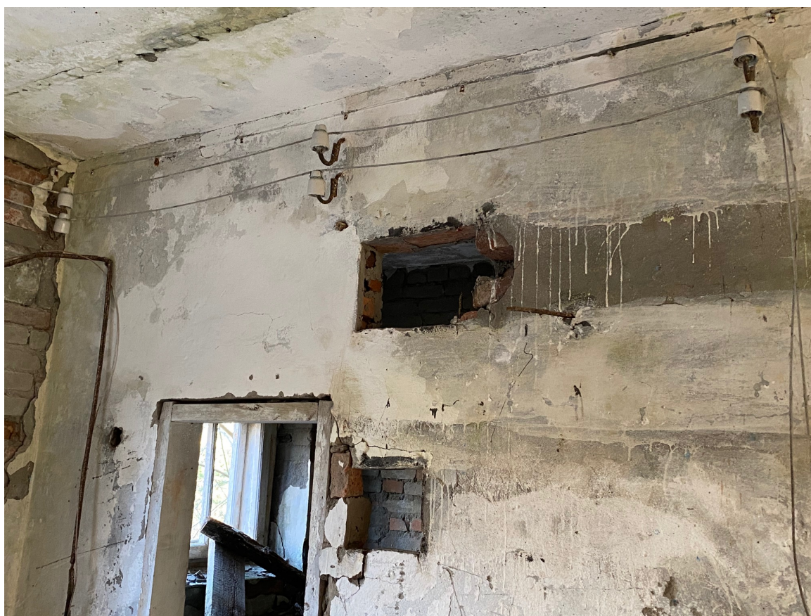
Joonis 107 Hoone eriline elektrilahendus viitab sellele, et tegemist on ühe vanema hoonega linnakus.
