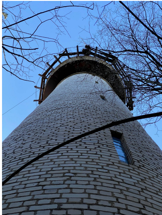
Joonis 67 Uue veetorni ladumismuster.
