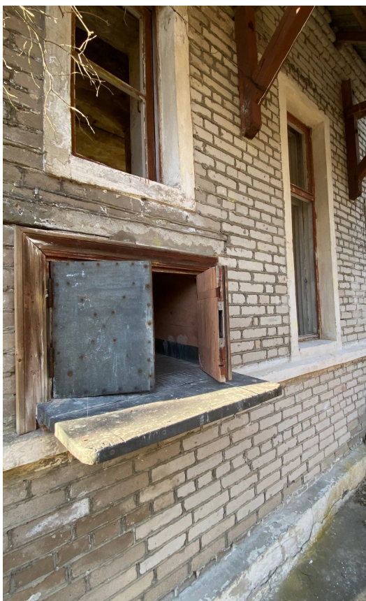
Joonis 109 Ava on luukidega suletav, seestpoolt väljapoole kaldega ja kaetud plekiga, mis viitab millegi väljastamisele. Kuna linnakus oli mitu kauplust, paiknes leiva- ja saiatöökoda ilmselt just siin.
