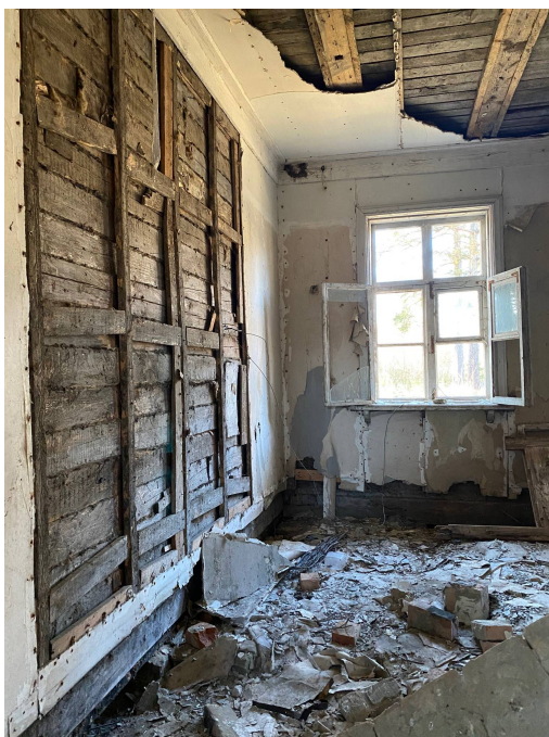
Joonis 77 Kööktubadel on laudadest vaheseinad.
