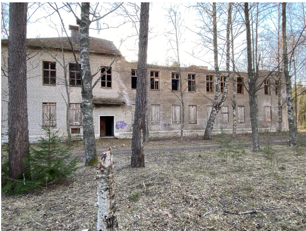
Joonis 35 Kasarmuhoone seisukord halveneb kiiresti. Katus on juba sisse langenud ja konstruktsioonid kahjustuvad.
