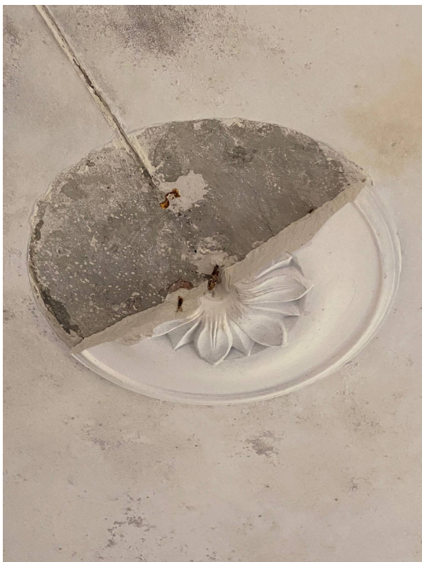
Joonis 39 Lahe põik 2 lõhutatud kipsrosett laes.
