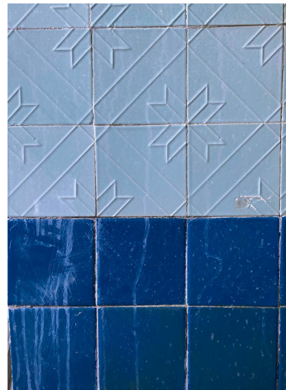
Joonis 57 Söökla köögi ruumi kahhelplaadid (koht märgitud põhiplaanil punasega).
