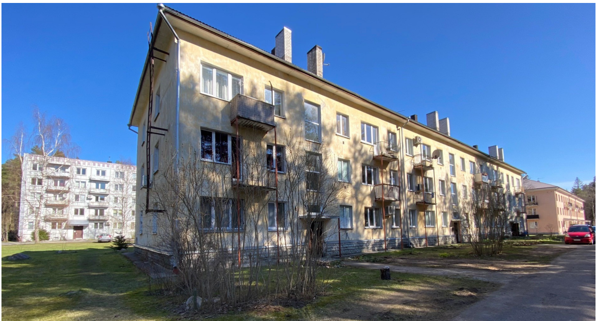
Joonis 38 Asustatud kortermajades on aknad vahetatud plastikakende vastu ja ühe hoone välisseinad soojustatud. Rõdud ja varikatus terastaladega toestatud. Taamal viiekordne paneelmaja.
