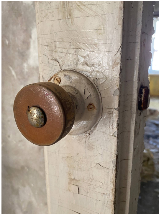
Joonis 96 Originaalsed uksekäepidemed.
