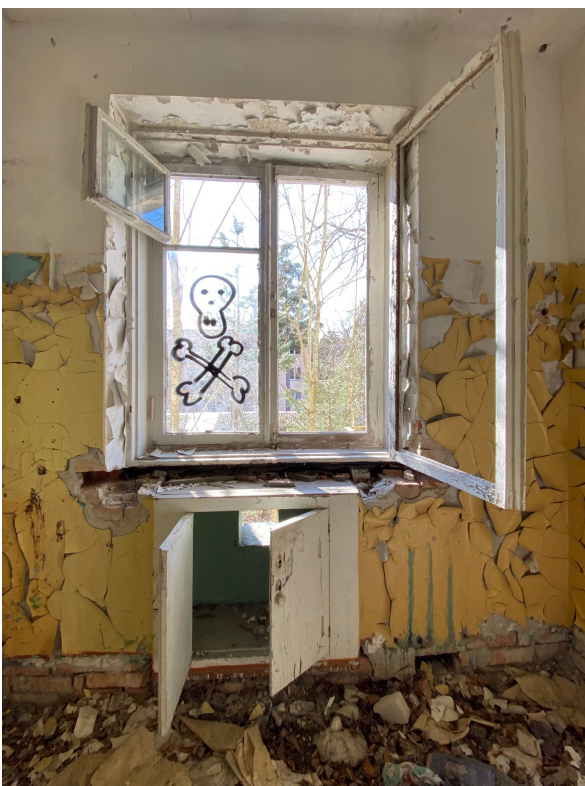
Joonis 46 Köögi akna all on välisõhuga jahutatav külmakapp kiirestirikneva toidu hoidmiseks.
