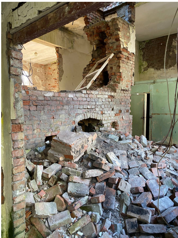
Joonis 105 Vastuse saab sellelt fotolt, millelt nähtub, et hoones on olnud suur leivaahi.
