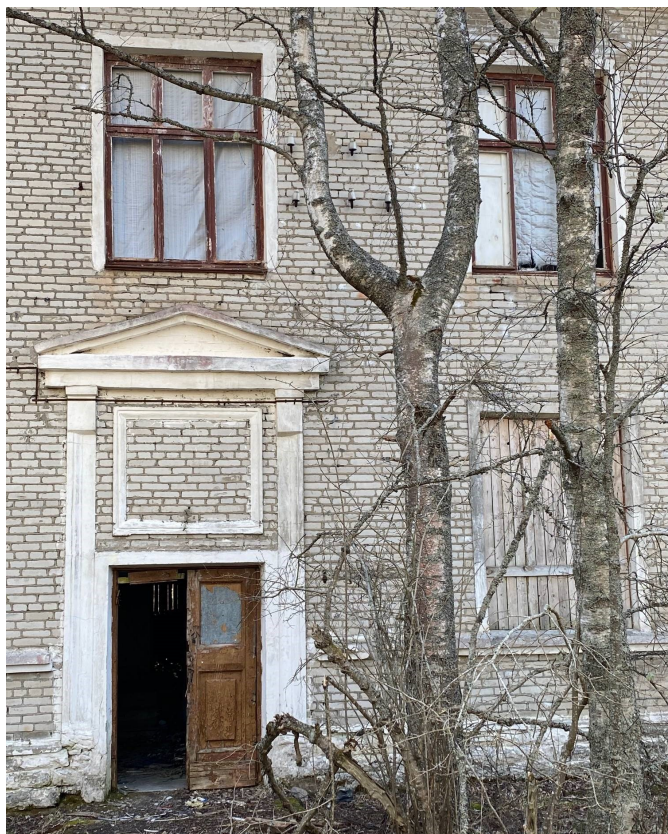
Joonis 33 Lihtsa välisilmega teenistushoone sissepääsud on ebatavaliselt uhked.
