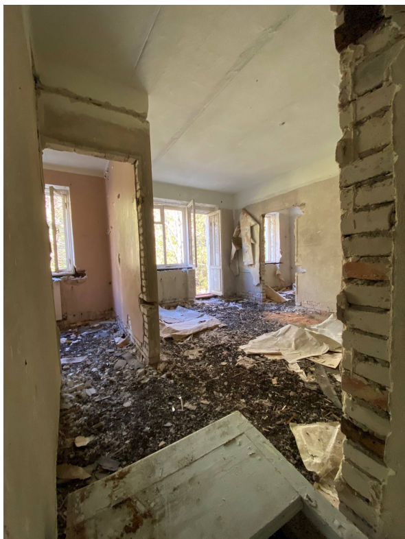
Joonis 45 Korterites olnud liistparkett on välja lõhutud, näha on põrandate täiteks kasutatud šlakki.
