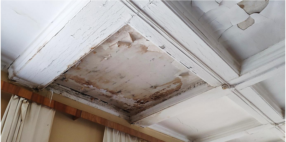
Illustratsioon 40. Kasettlagi, vee läbijooksu koht. Ruum nr 45.
