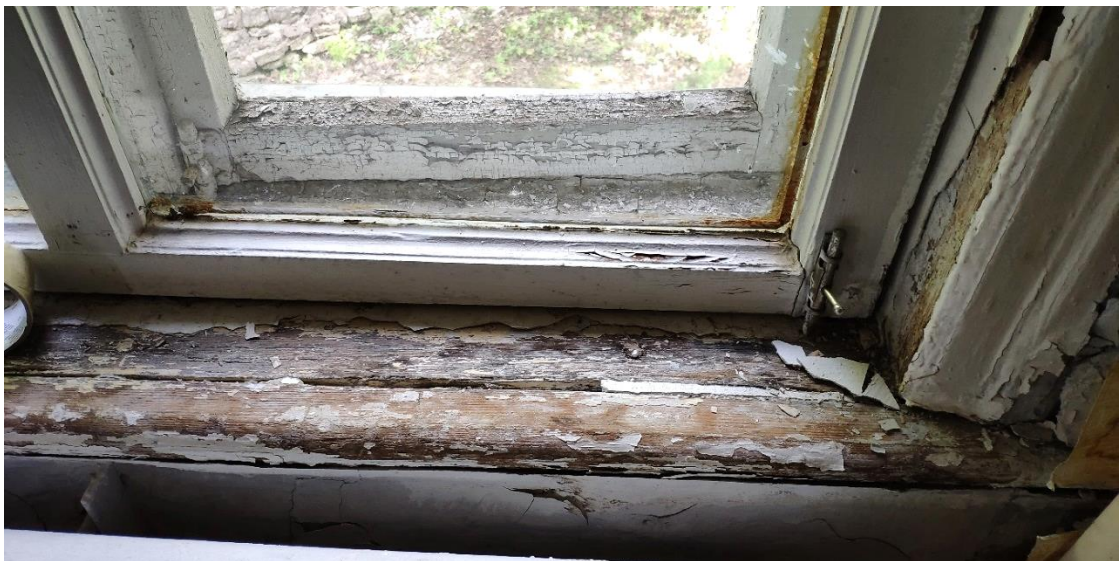
Illustratsioon 32. Akna kahjustused.
