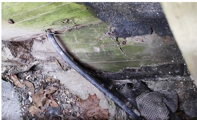
Illustratsioon 13. Vaade soklile ja palkseinale läbi auku soklit katvas laudvoodris.
