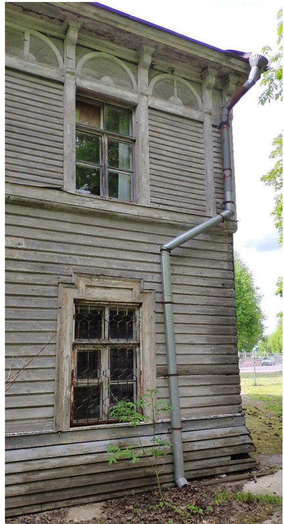
Illustratsioon 16. Vihmaveetoru. Veekahjustus fassadil.
