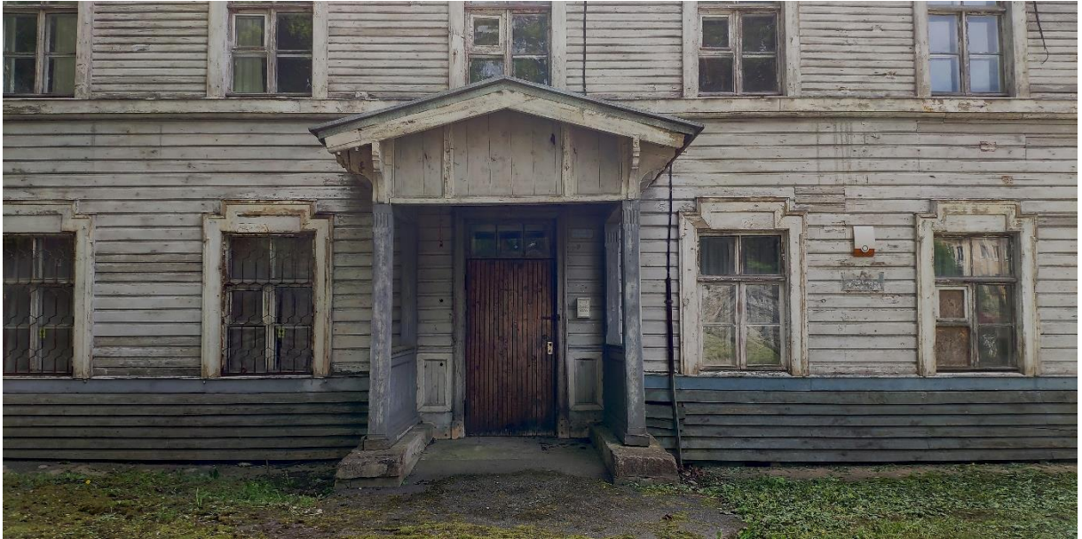
Illustratsioon 25. Välisuks edela külgfassaadil.
