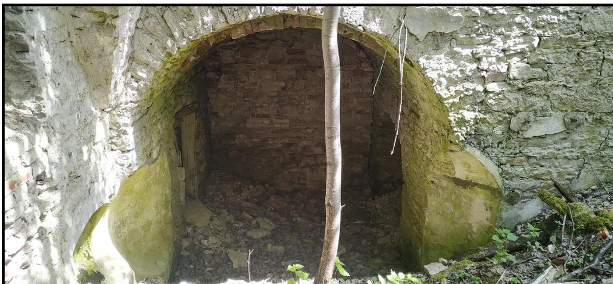
Foto 16 // Vaade eesruumist idatiiva sissepääsule, mis on suuresti sisse varisenud ja kinni müüritud. Viide 19. saj teise poole silindervõlvlaele. Autori foto, 2021 a.
