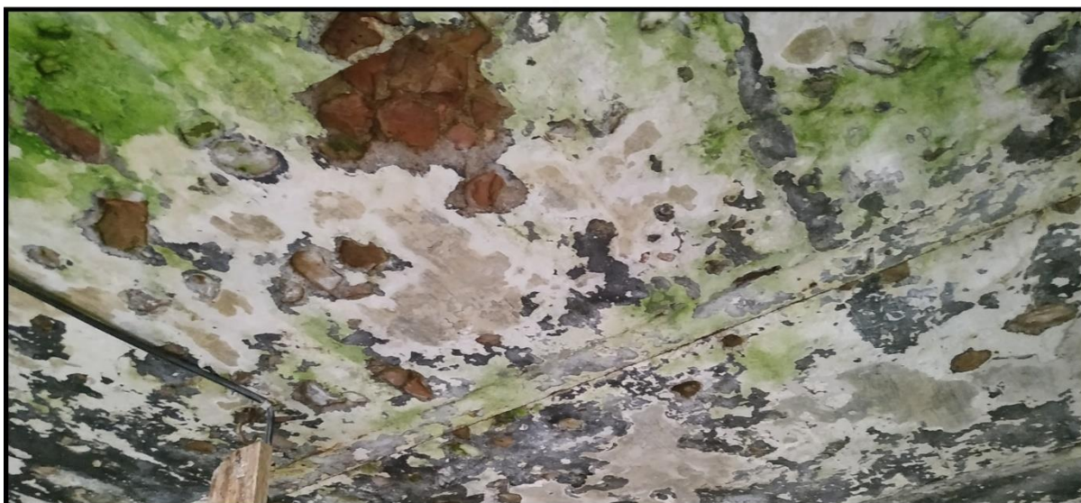
Foto 20 // Parasitosa nr. 1 siseruumi lagi. Metalltalad, betoon ja tellised. Autori foto, 2021 a.
