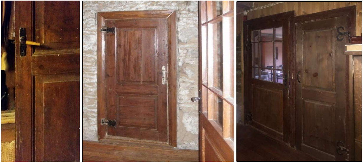
Illustratsioon 24 Säilinud ehitusaegne ukse link ja ehitusaegsed uksed
