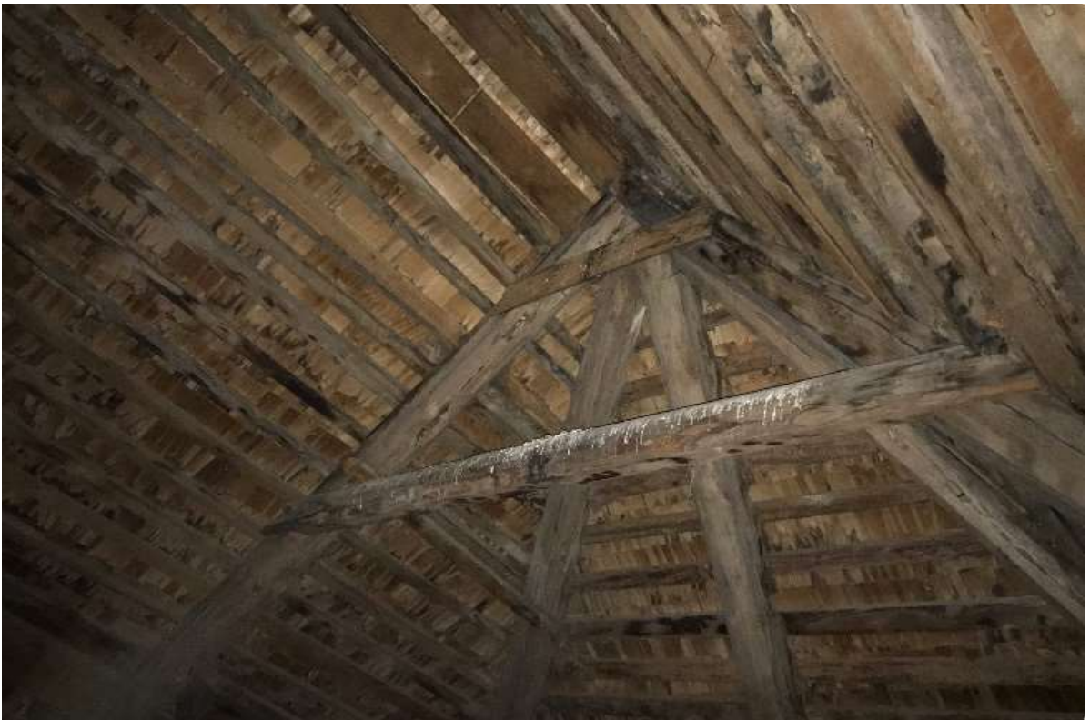
Illustratsioon 18 Katuse konstruktsiooni seisukord (sarikas ja pööning)
