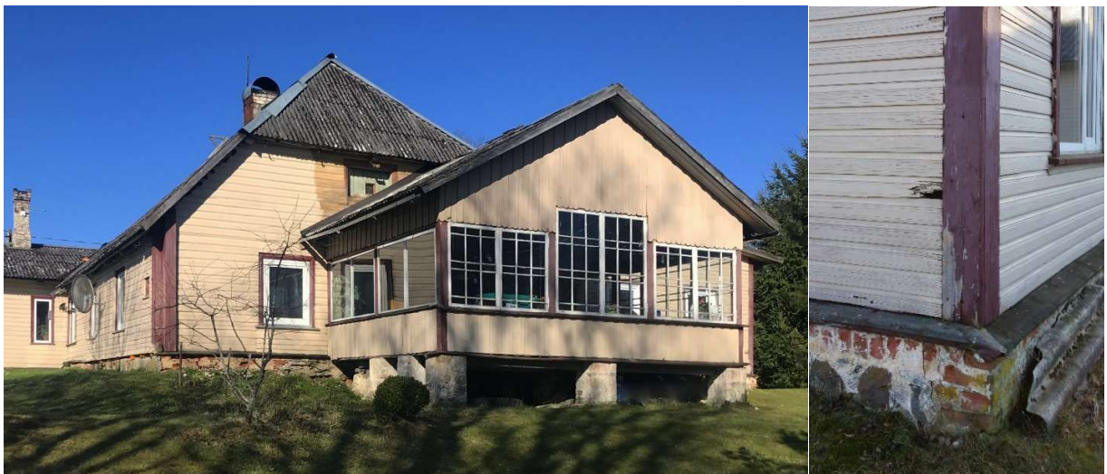
Illustratsioon 16 Seinä seisukord
