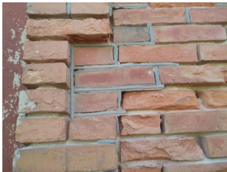
Illustratsioon 10. Irdunud vuugitäite tõttu tekkinud pinnaerosioon. Autori foto.
