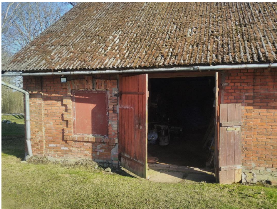
Illustratsioon 4. Kinnilaotud aken ja endise ukseava asukoht. Autori foto.
