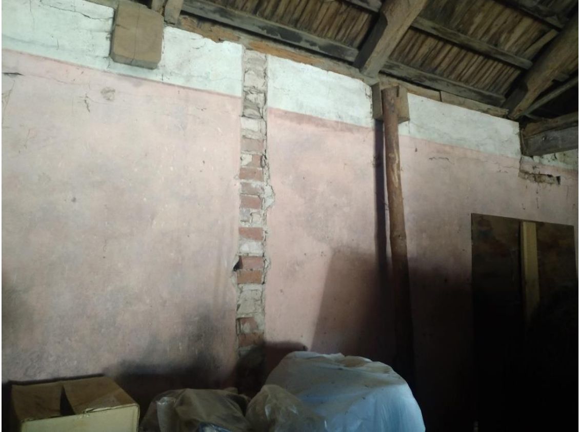
Illustratsioon 17. Vaheseina asukoht, lubikrohviga kaetud seinad. Autori foto.
