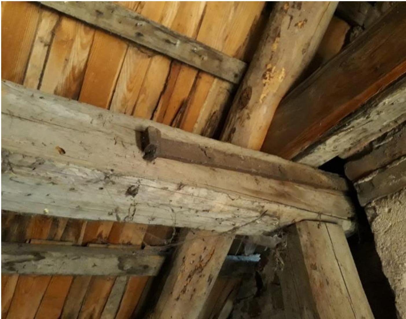
Illustratsioon 11. Katuse toolvärk ja pärlini sepistatud tõmbid. Autori foto.
