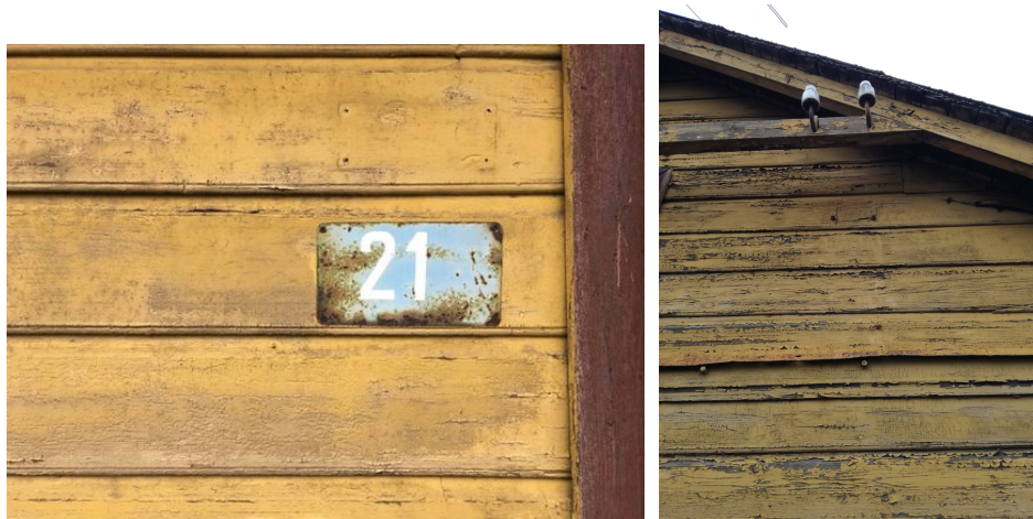
Illustratsioon 37 ja 38. Vanem fassaadilaud ja keraamilised isolaatorid. Allikas: Autori foto
