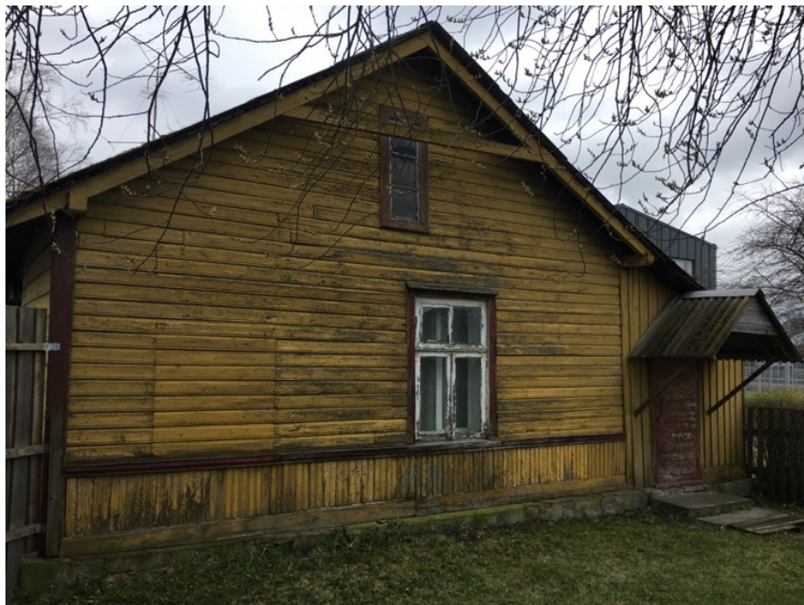
Illustratsioon 23. Hoone loodepoolsesse külge jääv rohkemate kahjustustega voodrilaud. Allikas: Autori foto
