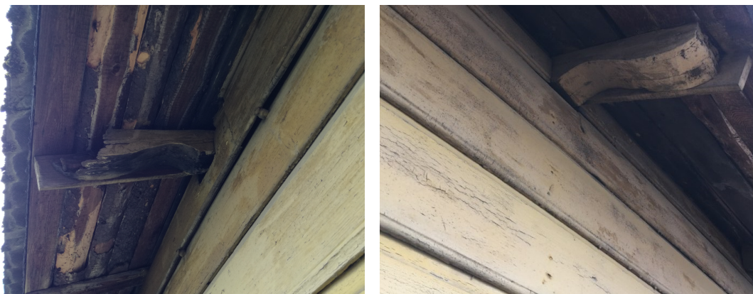
Illustratsioonid 15 ja 16. Ümara profiiliga sarikate otsad. Allikas: Autori fotod
