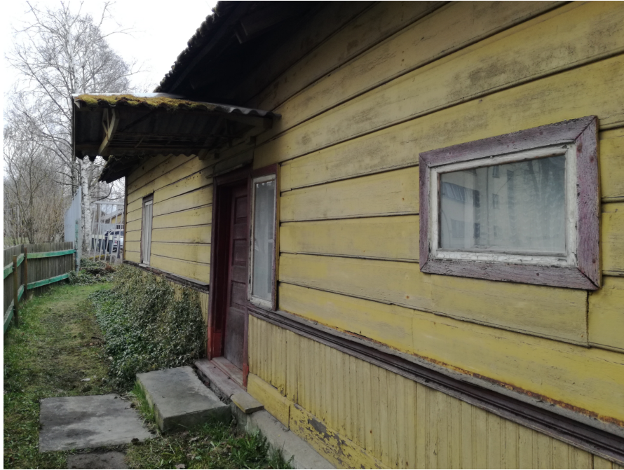
Illustratsioon 22. Tänavapoolne lai voodrilaud. Allikas: Autori foto
