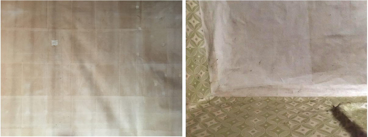
Illustratsioonid 25 ja 26. Eluruumides olevad paberiga kaetud laed. Allikas: Autori fotod
