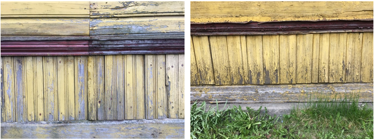
Illustratsioonid 19 ja 20. Hoone erinevatel külgedel asetsev profiillaudisega vööosa. Allikas: Autori fotod
