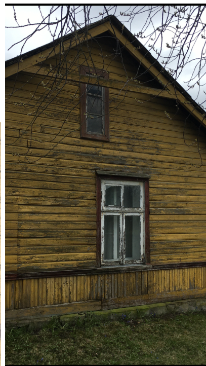
Illustratsioonid 35 ja 36. Eeldatavasti nõukogudeaegsed aknaraamid ja arvatav aken varasemast ajast. Allikas: Autori fotod
