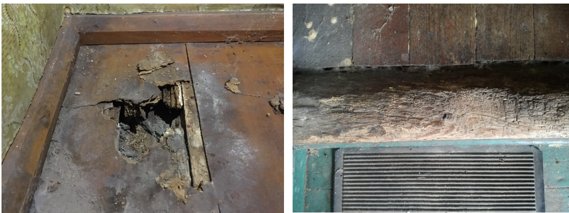
Illustratsioonid 27 ja 28. Põrandas olev auk ja vana lävepakk. Allikas: Autori fotod
