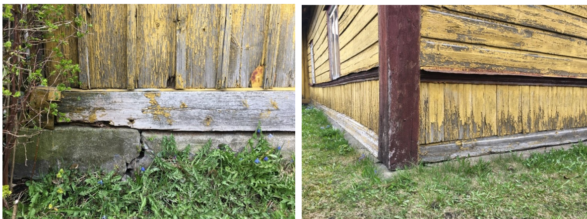
Illustratsioonid 29 ja 30. Pragunenud krohvikihit soklil ja muutused pinnase tasemes. Allikas: Autori fotod
