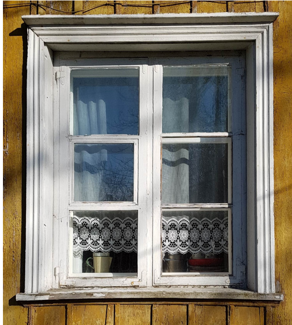
Foto 32 | Arvatavasti asendatud aken. Lahenduselt sama juurdeehituse aegsete akendega. Keskmise raami nähtav, tuulutusaaken keskmises jaotuses. Metallist detailid on algsed.
