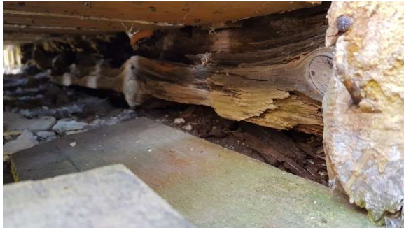
Foto 10 | Mädanenud alumine palk juurdeehituse ukse all. Kohal paistab puidust trepimade.
