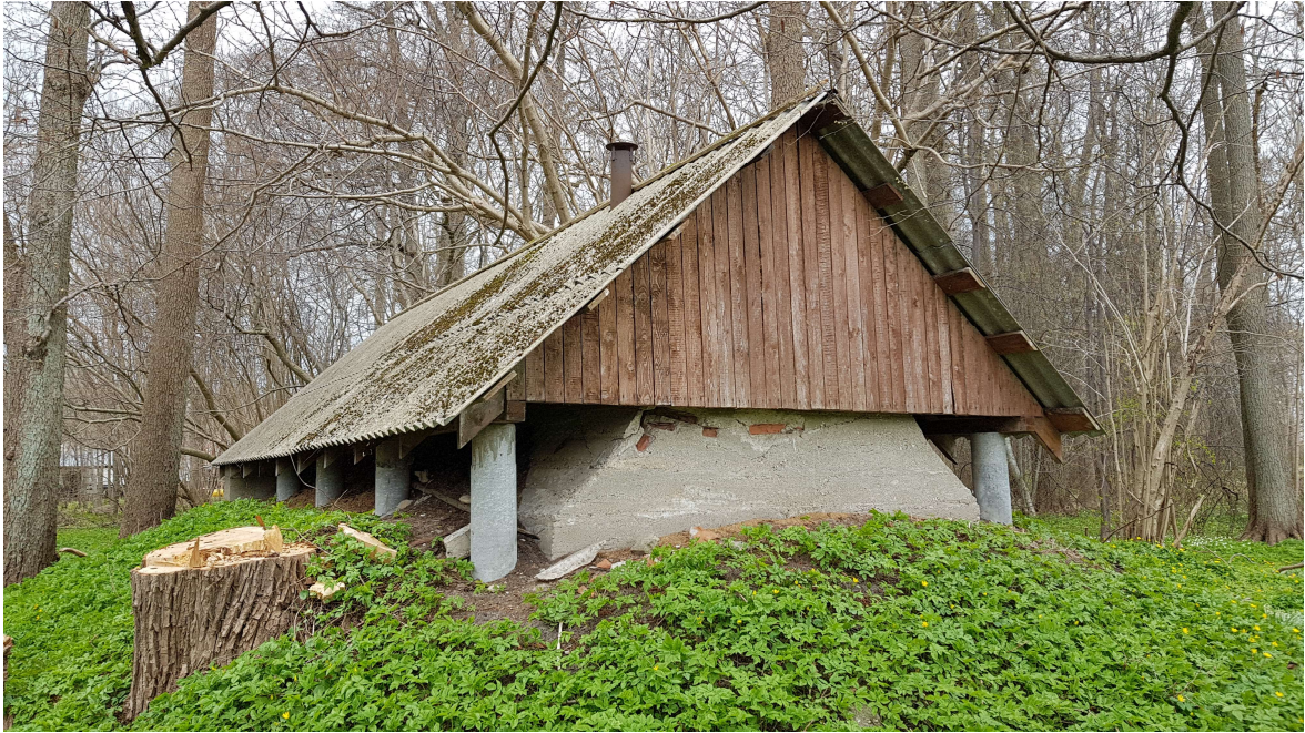
Hoovis paikenna keldri betoneeritud kehand.
