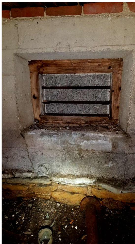
Foto 9 | Juurdeehitus osa betoonvundament. Näha on paekividest taldmik, ava nurgas jooksev pragu, esimese palgi alune telliskivivöö. Lisaks on näha kinniehitatud tuulutussava sokliseinas. Sarnaselt on suletud kõik nii suured tuulutussavad.
