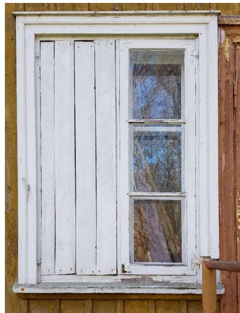
Foto 35 | Juurdeehituse aken. Üks pool laudadega kinni löödud. Arvatavasti lasteaia kahe tualettruumi mahutamiseks, vaheseina rajamiseks.
