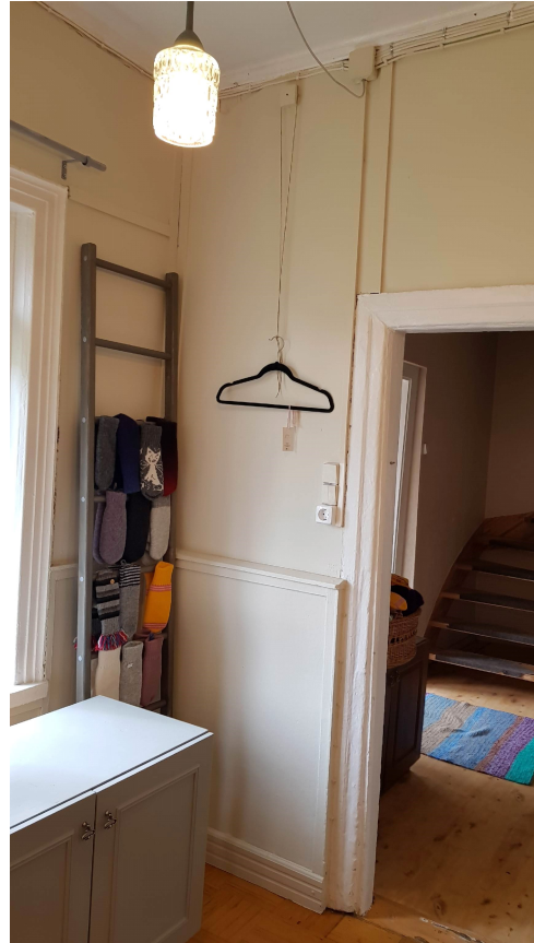
Foto 45 | Vana hoonemahu suurema ruumi sissepääs. Näha soomepaist seinad ja nende alla tehtud seinapaneelid. Seintel jooksevad pinnapeal elektrikaablid.
