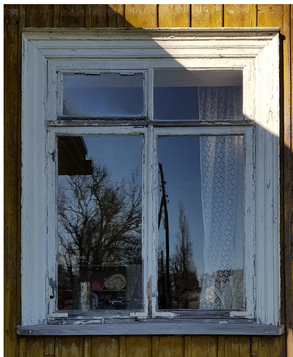
Foto 29 | Hilisem Nõukogudeaegne avatäide. Aknal on lisa tuulutusaken, üleval vasakus jaotuses.
