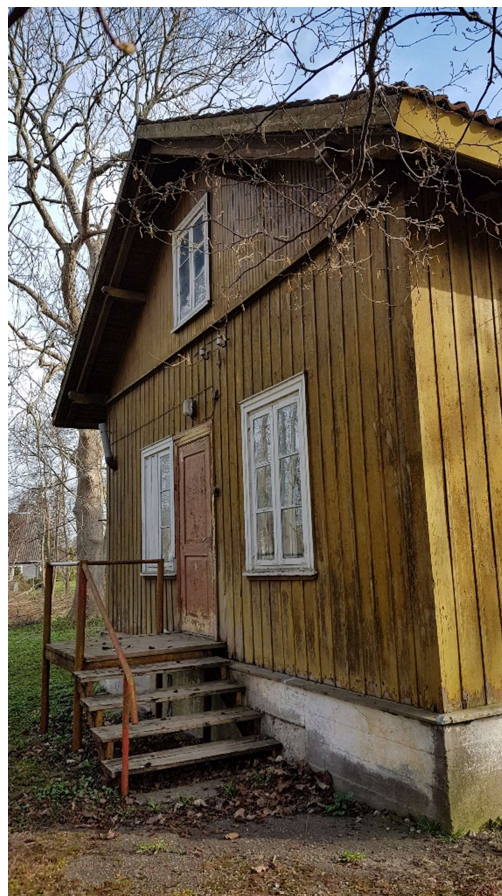
Foto 56 | Juurdeehitusse majanduspääsu trepp.
