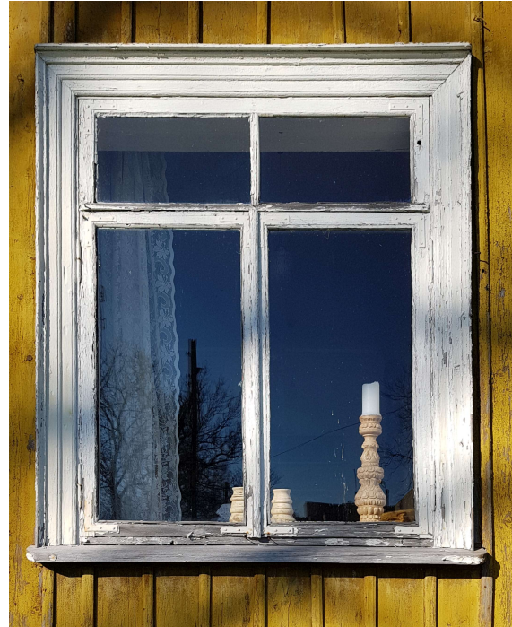
Foto 27 | Vahetatud avatäide. Enne taastamist tuleb otsustada kas õigem oleks algse kujundusga avatäidetega asendada. Kas säilitada ajalooline kihistus või arhitektuurne idee.
