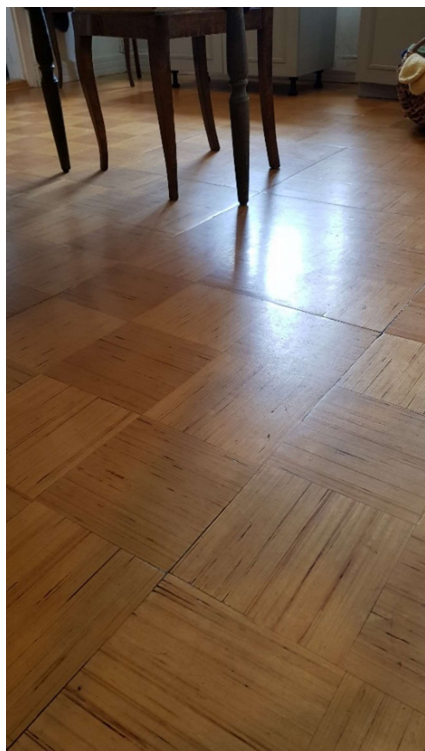
Foto 42 | Lõunapoolse suurema ruumi põrand. Põranda konstruktsioonid olid põrandalusest ruumist vaadates paremas seisus kui põhjakülje omad. Kuna aluskonstruktsioon on paremas seisus on ka viimistluskiht paremas seisus, kui tagatubade oma.
