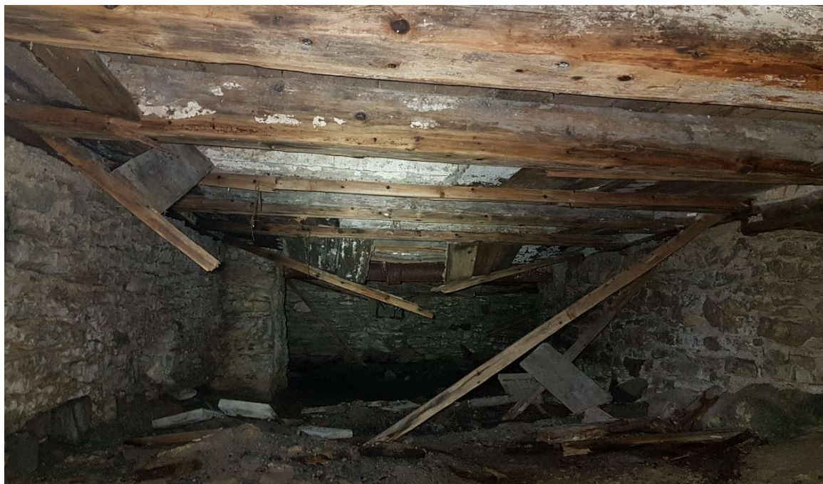
Foto 16 | Vana hoonemahu kirde nurga suunas on näha lagunevat aluslaudise ja soojustuse olukorda. Vasakule jääb põhja külje seina kandev vundament, paremale maakividele toetatud hoone siseseina alune (ka. kosten) vundament.
