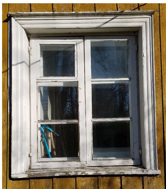
Foto 31 | Algupärane aken, kaheraamiline kuue jaotusega. Tuulutusaken üleval vasakul. Vasakpoolse raami alumised klaasid hävinud, asendatud üle kahe jaotuse prosspulga eest läbi jooksva klaasiga.
