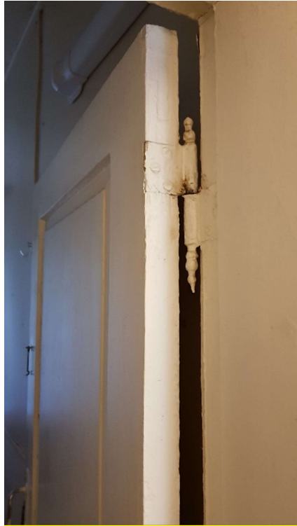
Foto 49 | Juurdeehitusse avanev siseuks. Erikujulised hingeotsad koos ustega väärtuslik detail.
