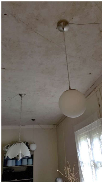
Foto 40 | Värvikihtidest puhastatud lagi. Heas seisus lubikrohv.
