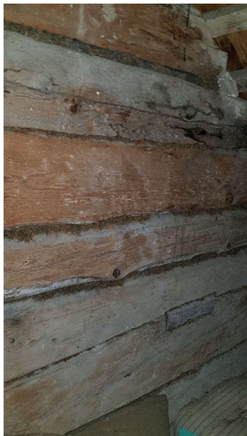
Foto 12 | Algse hoonemahu pööningul on näha katmata palkseina. Tihendatud samblaga.
