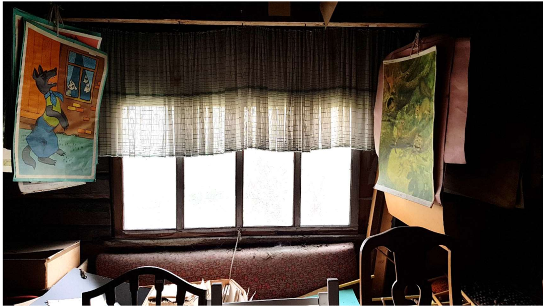
Foto 39 | Mõlemad pööningu aknad on asendatud, pildil idafassaadi aken, algselt oli tegu kolme jaotusega ja diagonaalsete prosspulkadega pilgupüüdja. Aknad asendada fotomaterjali põhjal tehtud koopiatega.
