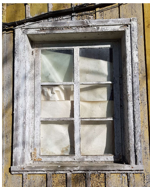
Foto 30 | Kunagisele verandale avanev aken, mis teistest täielikult erinev mõõtudel ja lahendusest. Ühel raamil on kuus jaotust. Seest viimistluskihtide taga ja peaks olema „tumm“ aken. Piirdeliistud profiilita.
