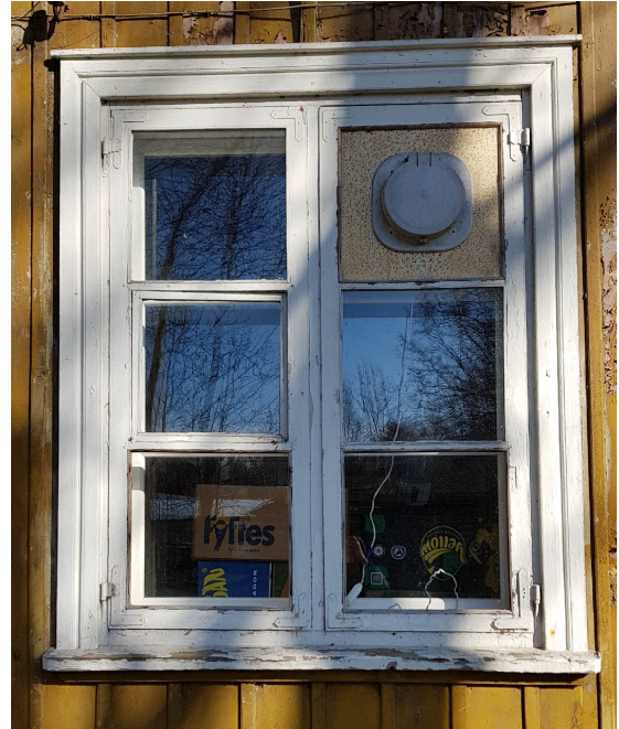
Foto 33 | Juurdeehituse aegne aken. Saavutatud on piisav sarnasus esialgsete akendega, kuid erinevused detailides. Keskmise raami nähtav, tuulutusaaken keskmises jaotuses. Metallist detailid on aga nõ vanamoodsad. Piirdeliistudega ei taotleta isegi sarnasust, tulenevalt akna pinnapeal paiknemisest ei ole enam astmelist tahapoole koondumist.
