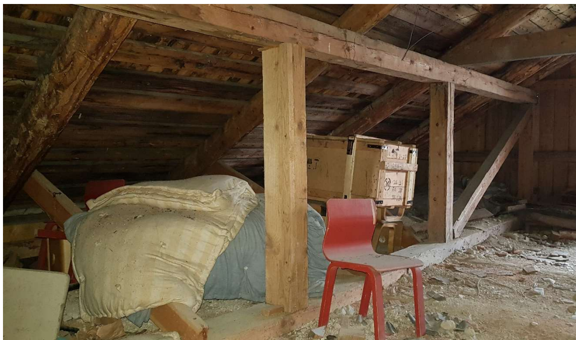
Foto 22 | Juurdeehituse katusealune. Aluskatuseks tihe laudis. Vahelael pööningu küljel laudpõrandat ei ole, nähtaval isolatsioonimaterjal, lubjane tolmiiv ja suuremad killustiku tükid. Viilualuses palksein puudub, voodrilaudis on kinnitatud prussidest karkassile.
