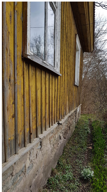
Foto 13 | Algse hoonemahu lõunafassaad. Veelaud on katki ja osaliselt puudu. Laudise alumised otsad täielikult kaitsekihid kaotanud. Sokli krohv suurte laikudena pudenenud.
