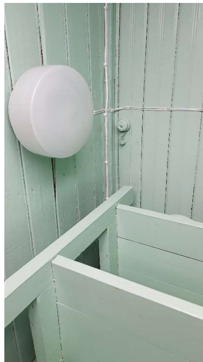
Foto 41 | Juurdeehituses paiknev väike sahver. Koos selle profiiliga sulundlaudisega, mida kasutatud ka ühes tubadest.
