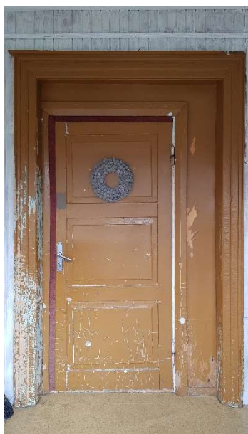
Foto 47 | Hoone välisuks. Raamid on algse ukse suurusega. Avasse paigaldatud kolme tahvliga uks on pigem toodud teiselt hoonelt. Kõik teised ukse, mis hoones paiknevad on kahe tahvliga.
