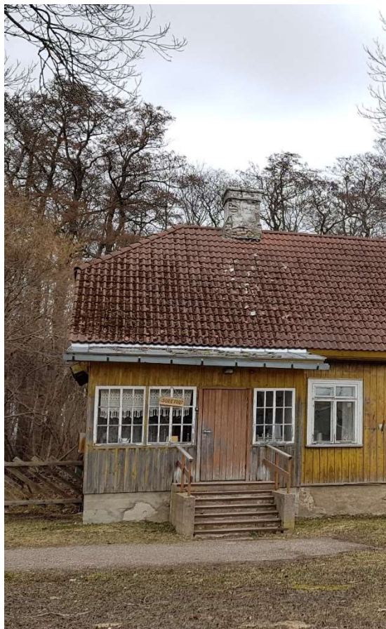
Foto 55 | Peasissepääs, ca 1995 rajatud betoonist trepp.
