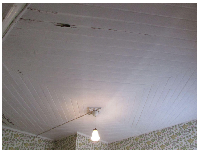
40. Rosetiga rombimustrisse paigaldatud lagi, Suur-Sadama 49. Foto: Keidi Saks, 2021.
