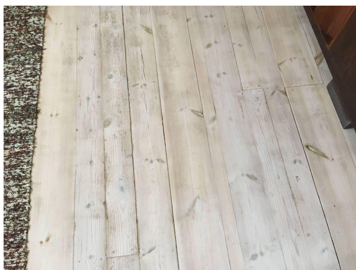
61. Kitsas 13 põrand uute ja vanade põrandalauadega. Foto: Gerda Ruuser, 2021.
