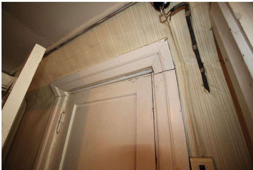
58. Profileeritud uksepiirded, Aia 30. Foto: Astra Tikas, 2019.
