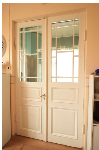
45. Klaasitud ülaosaga tahveluksed, Suur-Põllu 3. Foto: Astra Tikas, 2019.
