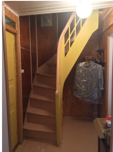
83. Lootsi 16 puidust keerdtrepp. Foto: Gerda Ruuser, 2020.
