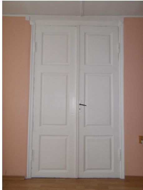
64. Lasteaia 10 kahepoolsed tahveluksed. Foto: Ilmo Au, 2021.
