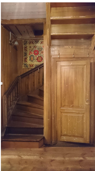
76. Lootsi 11 aaderdatud trepp. Foto: Villu Vatsfeld, 2021.
