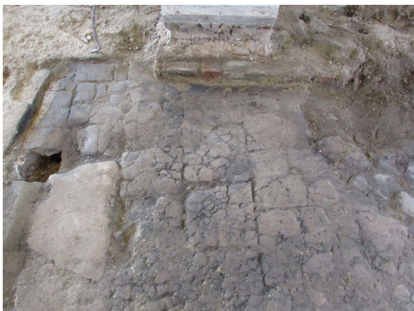
33. Paekivipõranda jäänused leitud mantelkorstna asukohast, Pikk 54. Foto: Keidi Saks, 2019.
