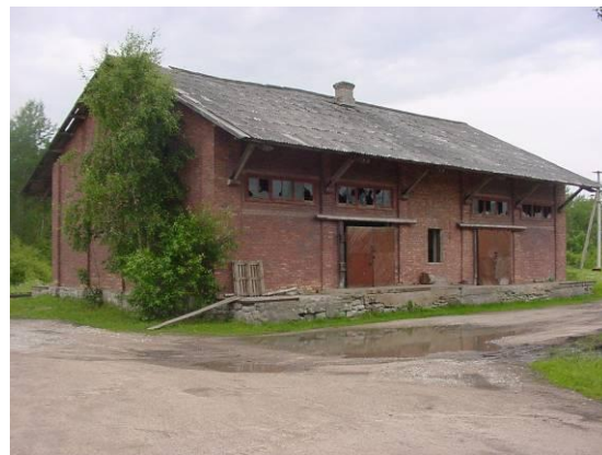
Veriora kaubaait 2004.a. Foto U.Oja
