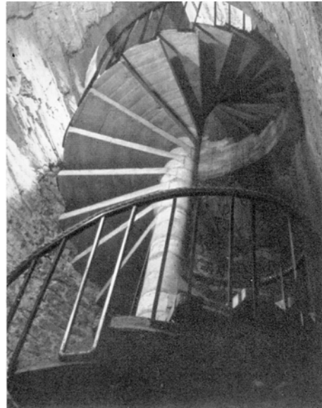
Foto 2 Küllastajate juurdepääsuks Nunnatorni ehitatud raudbetoonist keerdtrepp. Foto: B. Mäemets
