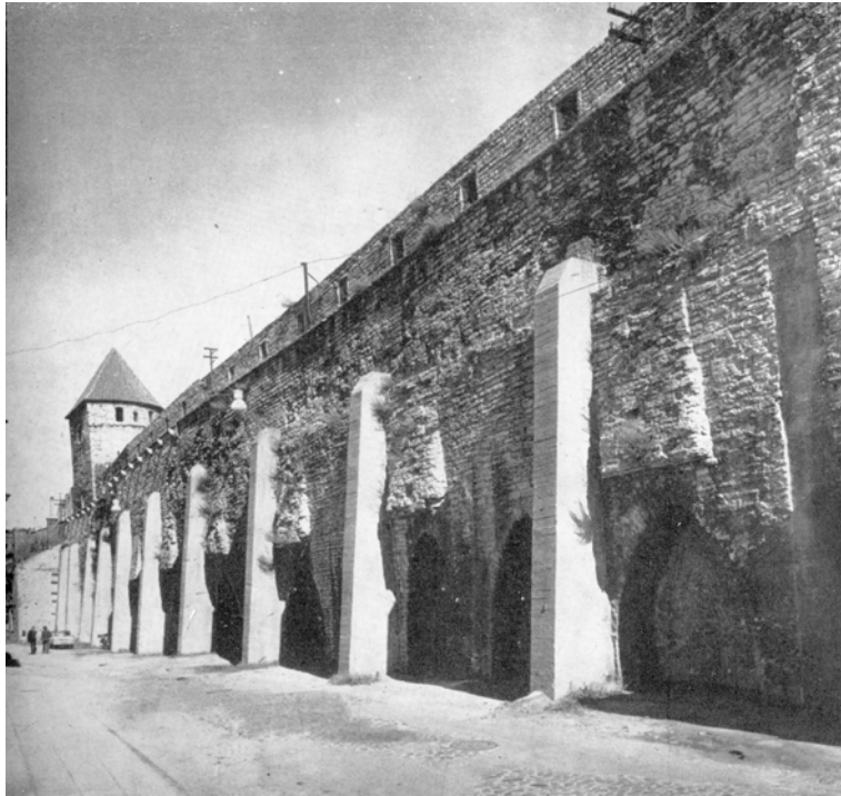
Foto 3 Hellemani torni ja Viru tn vaheline müürlõik uute raudbetoonist kontraforssidega. Foto: B. Mäemets
