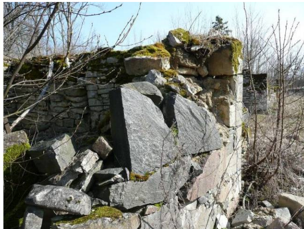
Fotod 107,108. Laut on loobunud, kuid lahatuna on väga hea õppevahend Muhu raudkiviseinte siseelust.
