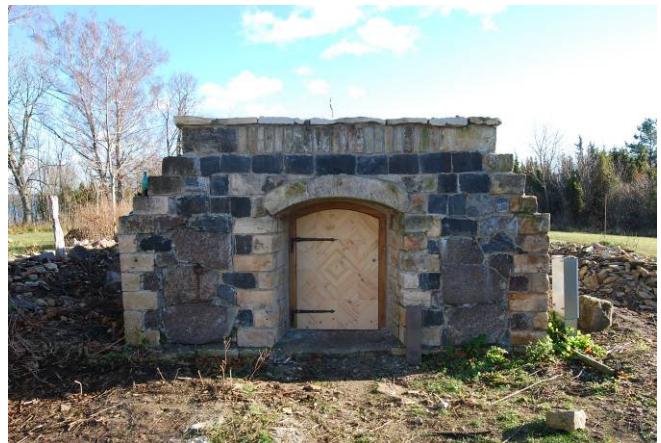
Foto 48. Kesse 5 küla (Kesselaiul) Jaani Aadu korrastatud kelder uue uksega.
