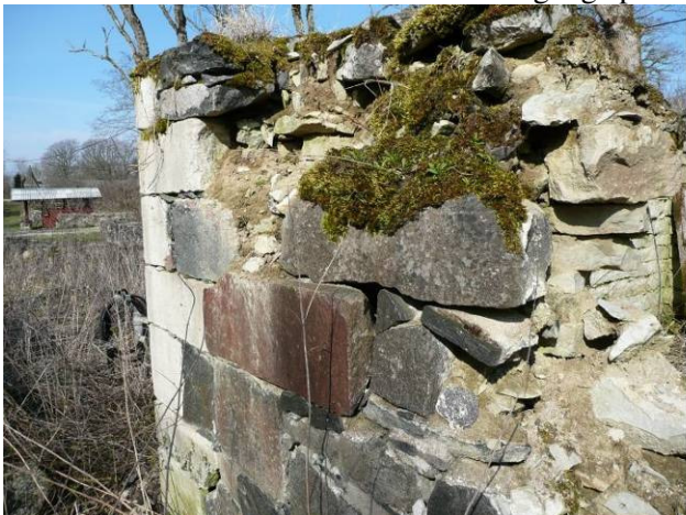
Fotod 107,108. Laut on loobunud, kuid lahatuna on väga hea õppevahend Muhu raudkiviseinte siseelust.
