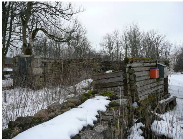
Fotod 105,106. Saun ootab vapralt järjekorras. Kivist külgein on uuesti üles tõstetud ja müüritis konserveeritud. Postkastid ei raatsi kuidagi aga palkseintest loobuda.
