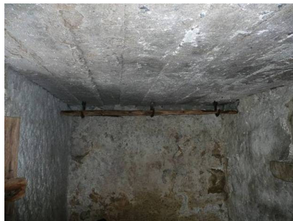
Fotod 98,99. Esikoja paekivist voolitud kandiline astmestik ja betooni valatud lagi
