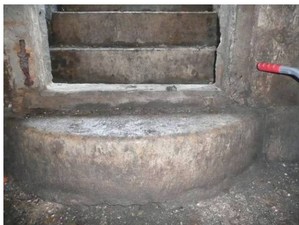
Fotod 100, 101. Keldri võlvlagi ja kaarjas keldriaste on harmoonia tippsaavutus. Põrand paeplaatidest. Vaja oleks ainult ühte Teeme Ära Talgupäeva!
