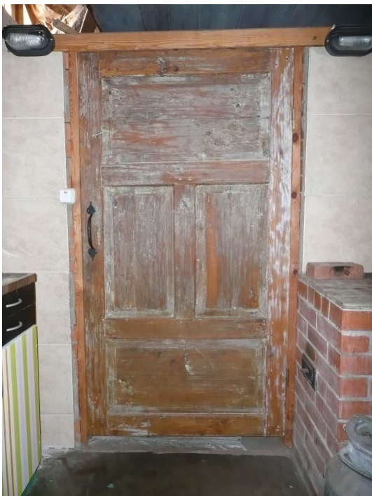
Foto 76 Ukse ja akna raampuude paksused ca 27 mm. Foto 77
