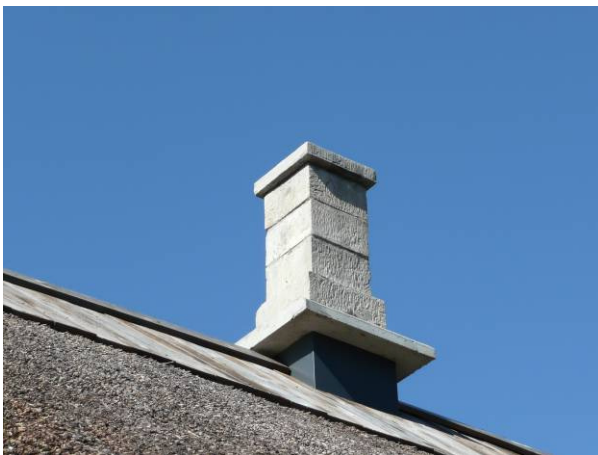
Foto 75. 100 aastane korstnapiip on puhastatult uuel ringil, saades katuse all sõbraks Isokern moodulkorstna elementplokkidega .
