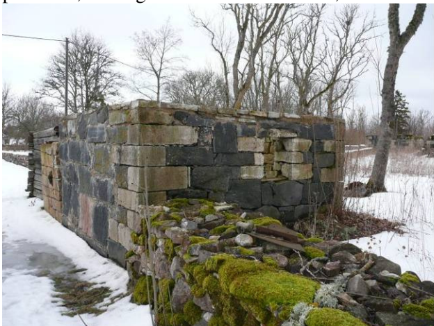
Fotod 105,106. Saun ootab vapralt järjekorras. Kivist külgein on uuesti üles tõstetud ja müüritis konserveeritud. Postkastid ei raatsi kuidagi aga palkseintest loobuda.
