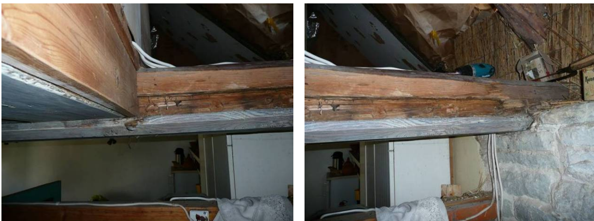
Fotod 69, 70 laepaaride külgsuonte tegemisel on abiks olnud ohardi (käsipuur) ja peitel.
