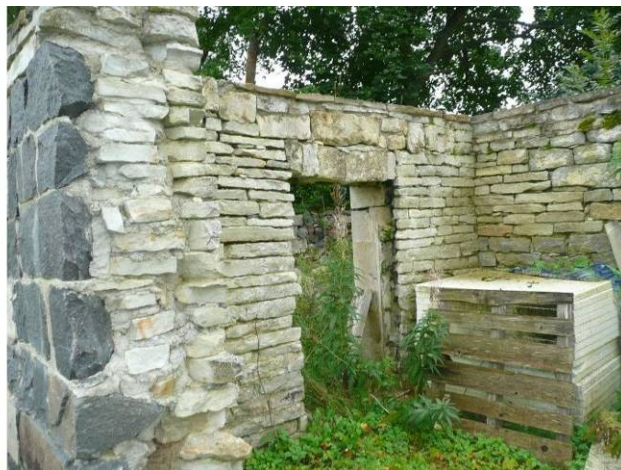
Fotod 103,104. Aida säilinud kiviosa on uute omanike poolt 7 aastat tagasi püütud konserveerida. Palkidest puiduosa, mis tagavaates nähtav fotol 86, on kavandatud tulevikus taastada.
