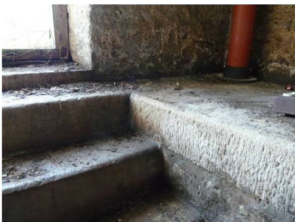
Fotod 98,99. Esikoja paekivist voolitud kandiline astmestik ja betooni valatud lagi
