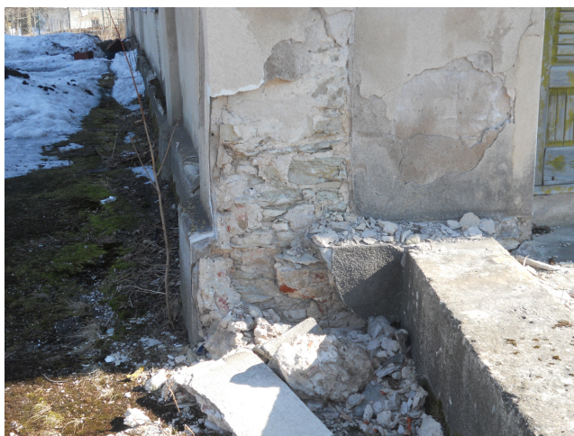
Pilt 18. Läänefassaadil esineb sokli ja seina lokaalne varing. Allikas: Tatjana Hünne, aprill 2012.
