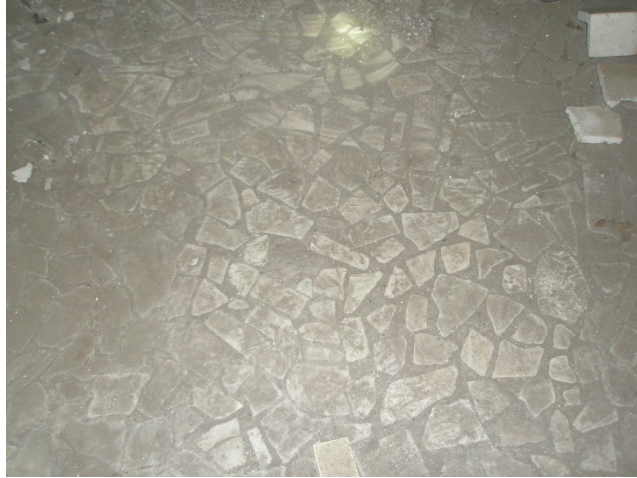
Pilt 25. Marmortükkiidega betooni põranda seisukord. Allikas: Tatjana Hünne, aprill 2012.
