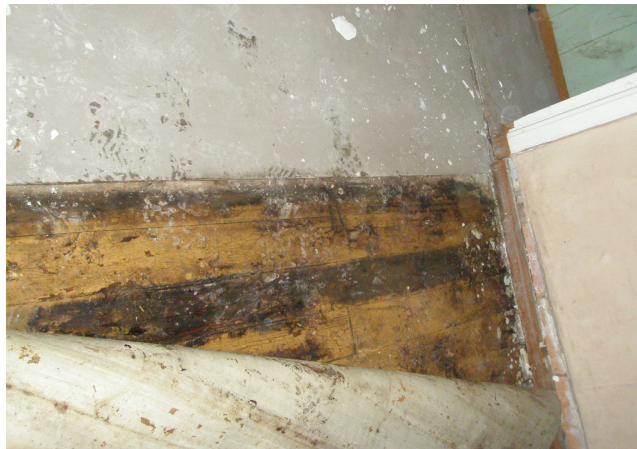
Pilt 23. Ebasobiva põrandakatte kasutamise tulemusel pehastunud esimese korruse puitpõrandad. Allikas: Tatjana Hünne, aprill 2012.
