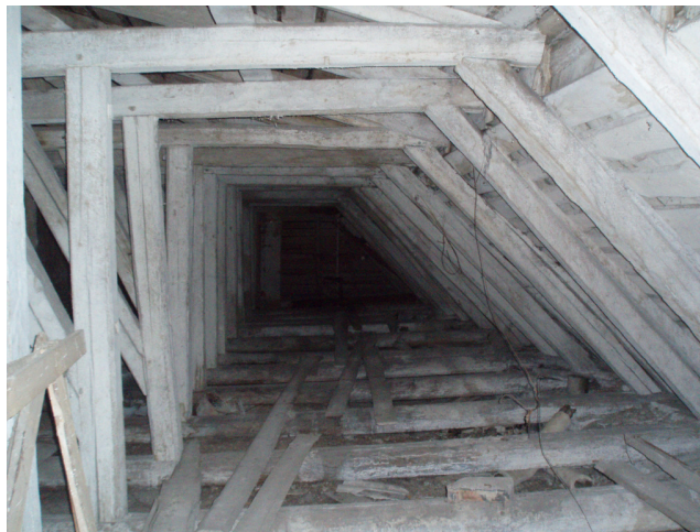
Pilt 34. Sarikate osas siiski suuri läbivajumisi ei ole, kuna defektidega sarikad asuvad erinevates kohtades ja väiksem kandevõime on kompenseeritud naabersarikate tugevusega. Allikas: Tatjana Hünne, aprill 2012.
