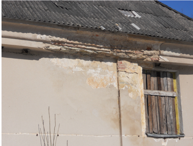
Pilt 21. Lagunenud karniisi osa teise korruse akende kohal. Allikas: Tatjana Hünne, aprill 2012.
