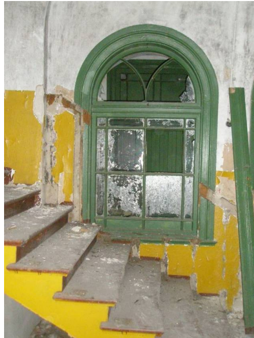
Pilt 32. Algupärane siseaken kuulub säilitamisele ja restaureerimisele. Allikas: Tatjana Hünne, aprill 2012.
