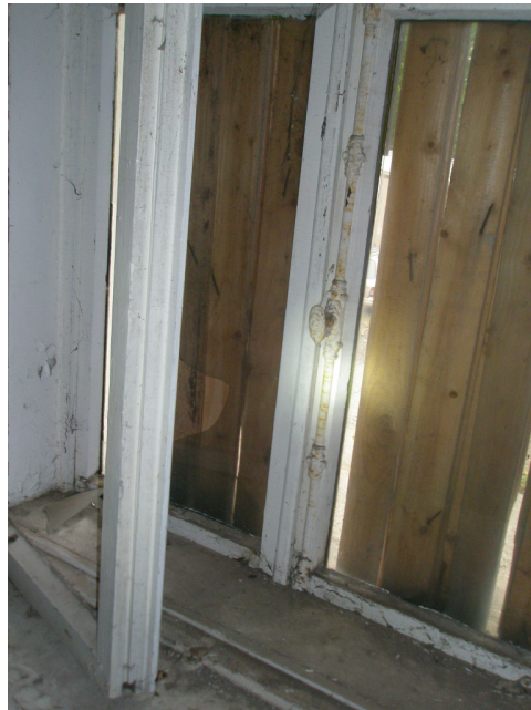
Pilt 31. Mitmetel akendel on säilinud algsed kremoonid. Allikas: Tatjana Hünne, aprill 2012.
