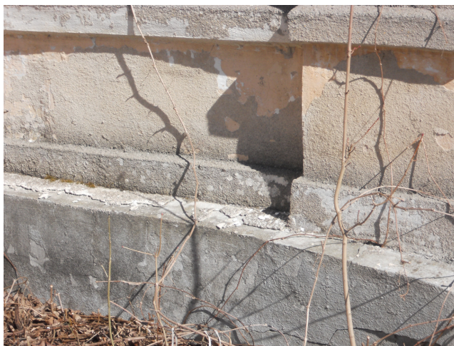
Pilt 17. Sokkel on peamiselt rahuldavas seisukorras. Allikas: Tatjana Hünne, aprill 2012.
