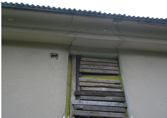
Pilt 20. Prao moodustumine on arvatavasti seotud silluse valesti valitud ristlõikega. Allikas: Tatjana Hünne, aprill 2012.
