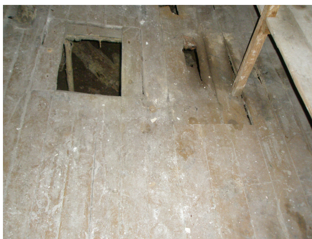
Pilt 24. Põrandalauad on kahjustatud niiskuse tõttu. Allikas: Tatjana Hünne, aprill 2012.
