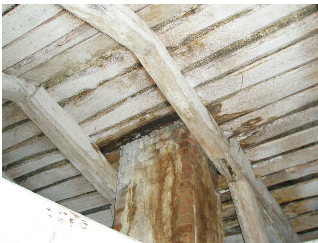
Pilt 36. Ulatuslikud läbijooksud, puidust kandekonstruktsioonid on pehkinud. Allikas: Tatjana Hünne, aprill 2012.
