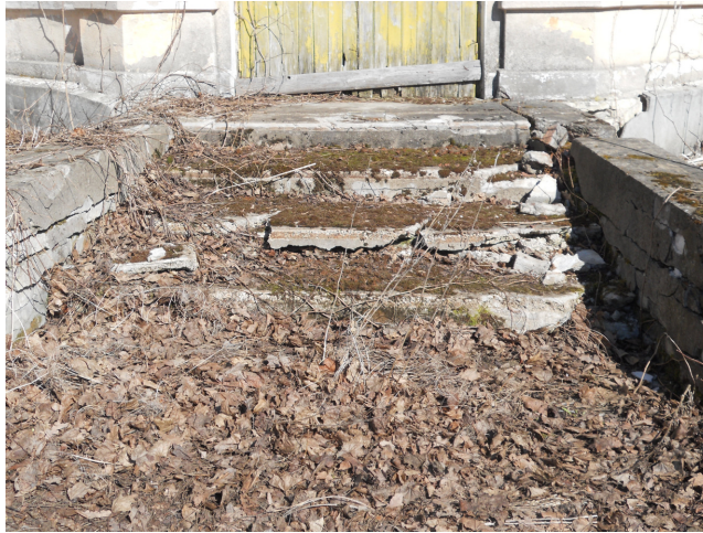
Pilt 38. Nõukogude ajal hävinud terrassi asemel ehitatud betoontrepp on lagunenu. Trepil käsipuud puuduvad. Allikas: Tatjana Hünne, aprill 2012.
