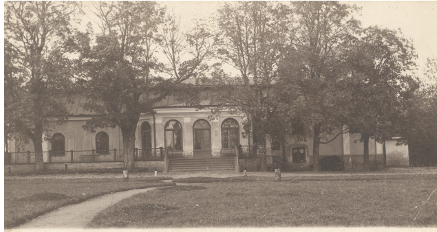
Pilt 4. Edise mõisa peahoone peafassaad, 1900.a. Hoone peasissepääs on ümber ehitatud aknaks ning hoonesse pääseb praegu vasakuküljel paikneva ukse kaudu. Allikas: Jaan Vali fotokogust.
