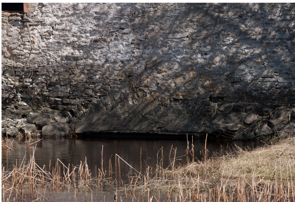
Veskikoja lääneseina veerenni avaus
