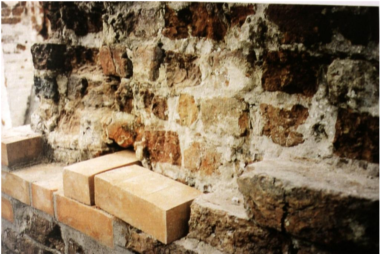
2. Tellismüüritise ladumina Tartu toomkiriku varemets 2002. aastal. (Restaureerimise-konserveerimise aruanne, MKA, s A-6904, lk 31)
