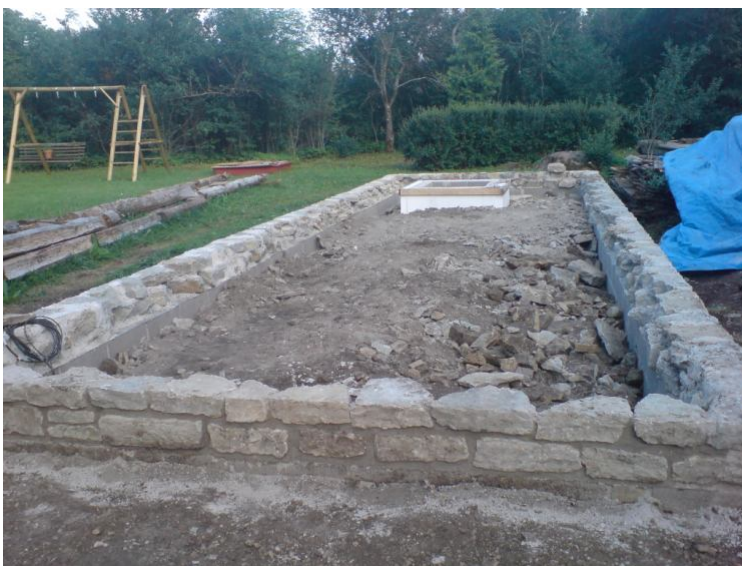
Joonis nr. 11. Aida vundament. Allikas: Autori foto juuni 2011.
