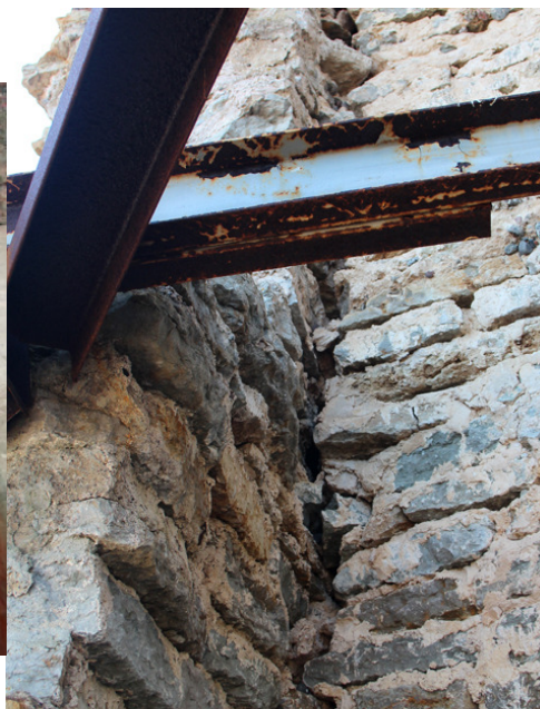
Foto 3.9.paremal- jälgastav ristmüür, ka trepialuse täite tugisein.
