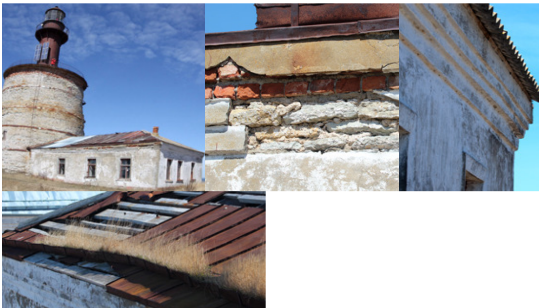
Fotod: 3.35-3.38. Vaade kõrvalhoonele, fotod väliskonstruktsioonide hetkeseisust
