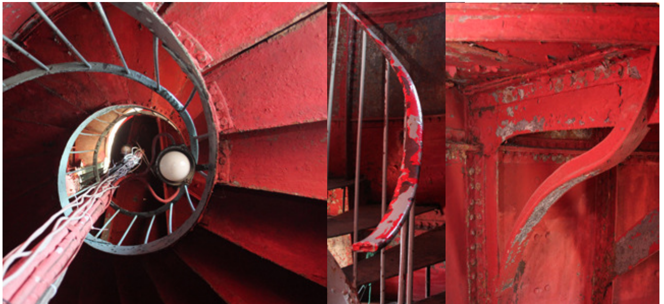
Fotod 3.22.-3.25. Keerdtrepp, trepi piire ja laternaruumi põranda kandekonstruktsioon
