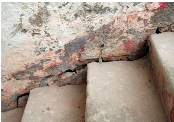
Foto 3.9.paremal- jälgastav ristmüür, ka trepialuse täite tugisein.
