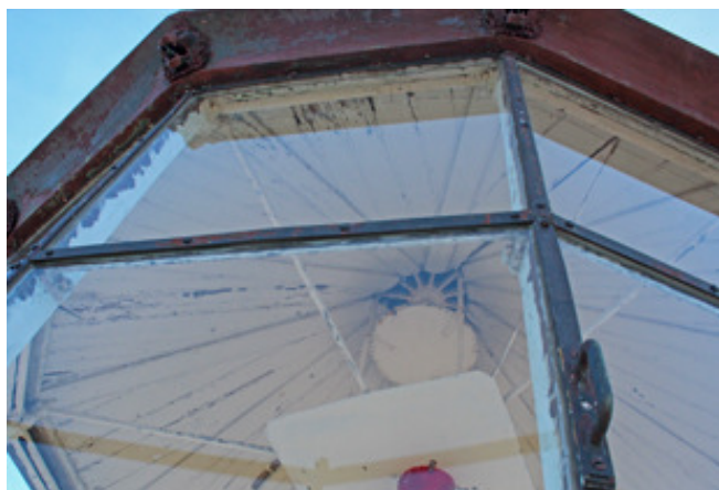
Foto 3.14. Laternaruumi puitlagi ja klaasseinad
