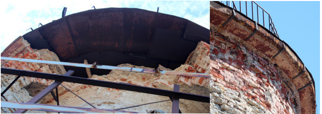
Fotod 3.11 ja 3.12. Alla kukkunud r/b karniis ja tellisvõlv ning lagunev savitellistes müüriosa.
