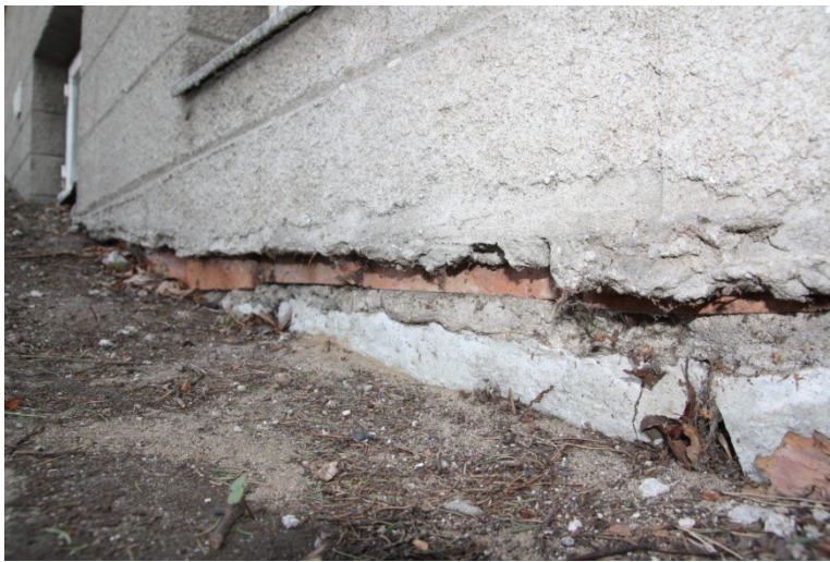
Foto 4. Maapind ja soklikrohvi üleminek, suure kalde tõttu mulde erosioon.
