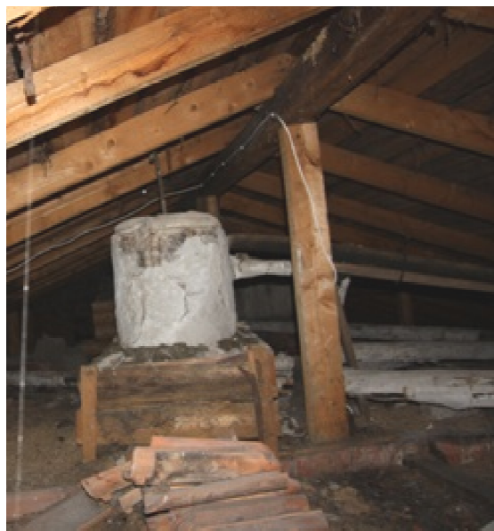
Foto 14, keskküttesüsteemi harutorustik paagiga
