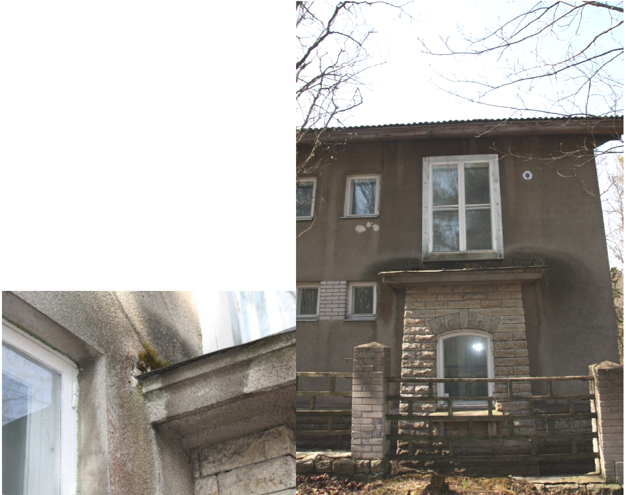
Foto 6, välisseina niiskuskahjustus suures plaanis ja erkli karniisi lähivõte
